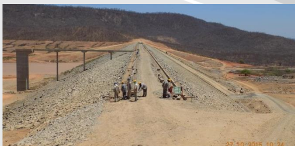
Reservatório Boa Vista
