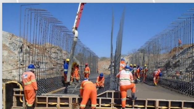
Execução de bueiros sob o canal.
