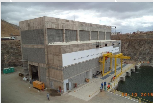
Estação de bombeamento EBV-2.
