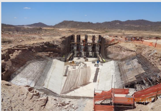
Estrutura de controle Negreiros
