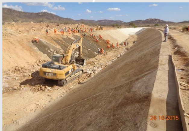
Execução de canal entre Res. Negreiros e Milagres.
