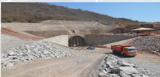
Túnel Cuncas I
