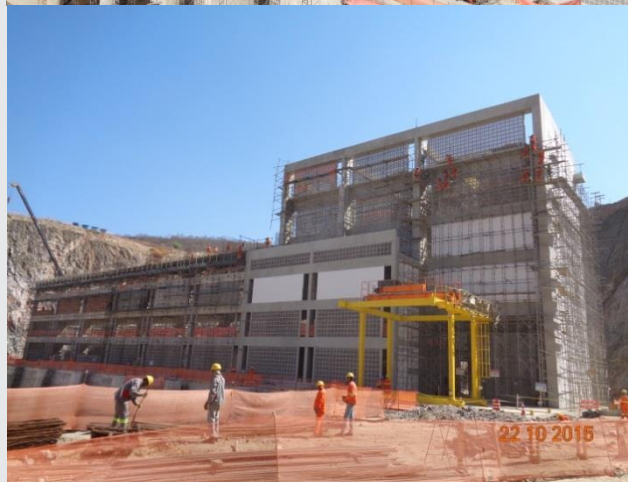
Execução da Estação de Bombeamento EBI-3
