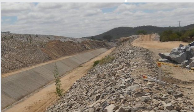
Canal entre o Res. Barro Branco e o Túnel Giancarlo
