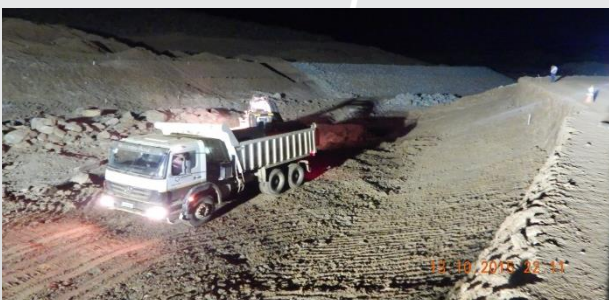
Segmento de Canal entre Jati e Atalho
