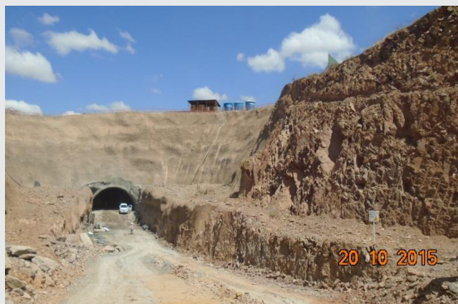
Emboque do túnel Milagres.
