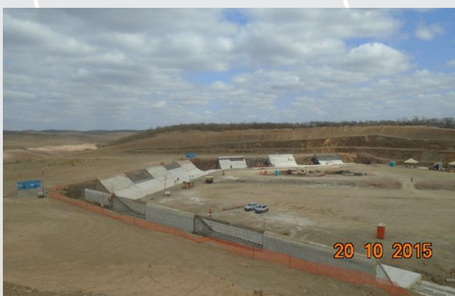
Vertedouro do Reservatório Milagres
