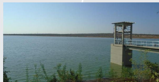
Enchimento do Reservatório Areias concluído.
