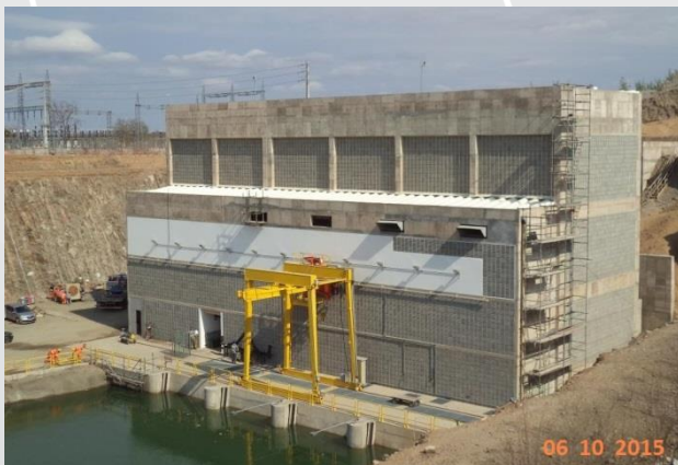
Estação de bombeamento EBV-2.
