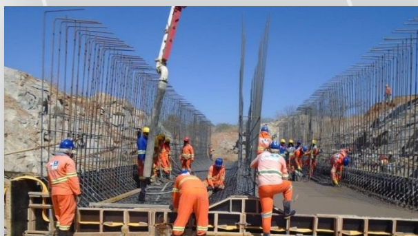
Execução de bueiros sob o canal.
