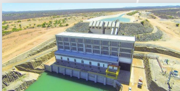
Estação de bombeamento EBI-1 em funcionamento.
