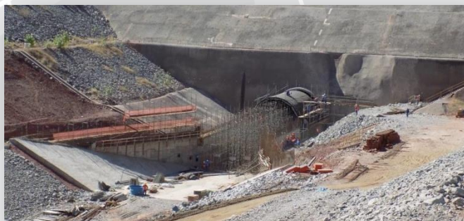
Segmento de canal entre Res. Morros e Boa Vista
