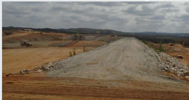
Reservatório Barro Branco
