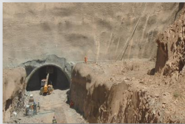
Emboque do túnel Milagres.
