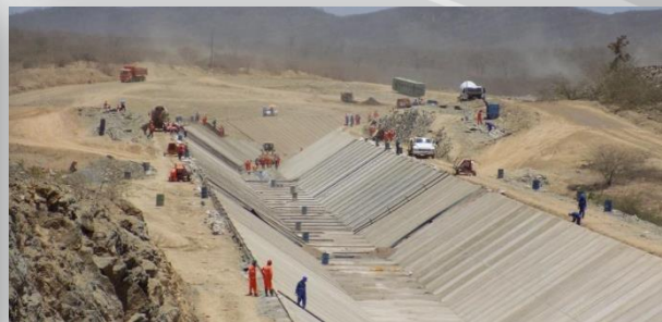
Concretagem de canal
