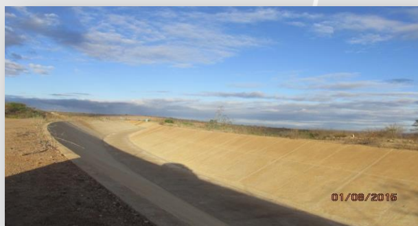
Segmento de canal entre EBV-2 e Reservatório Braúnas
