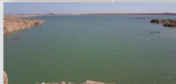
Enchimento do Reservatório Tucutú.
