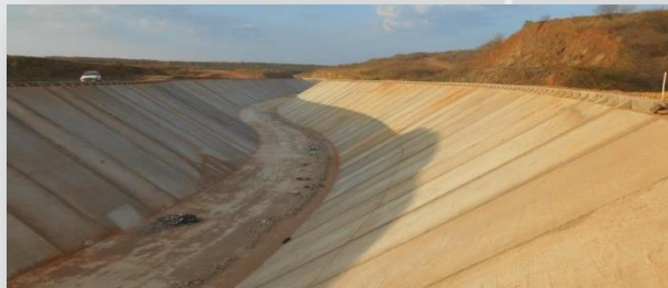
Segmento de canal concluído.
