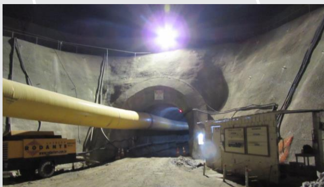
Desemboque do Túnel Eng. Giancarlo Lins Cavalcanti
