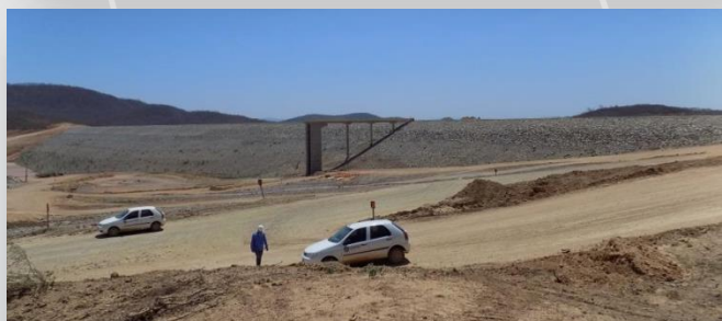
Reservatório Boa Vista
