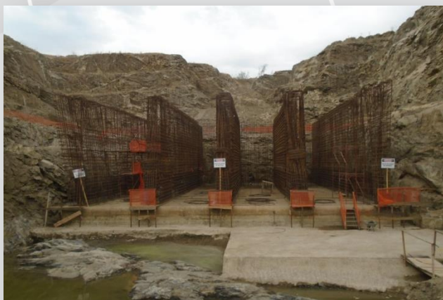
Estação de bombeamento EBV-6
