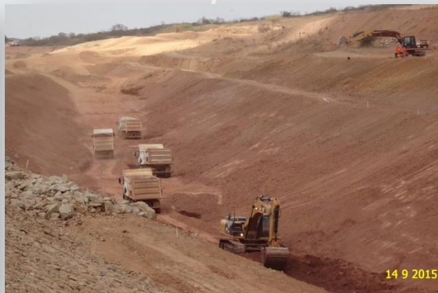
Escavação de canal após Res. Milagres.
