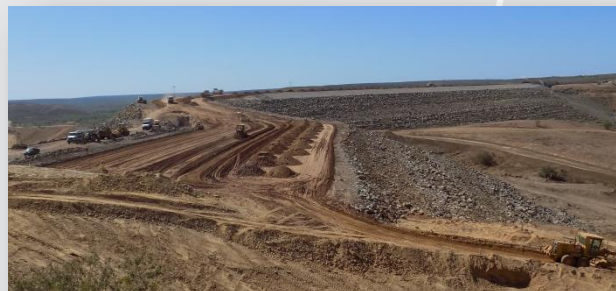
Dique do Reservatório Jati.
