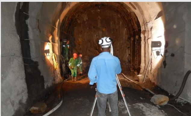
Túnel Eng. Giancarlo Lins Cavalcanti
