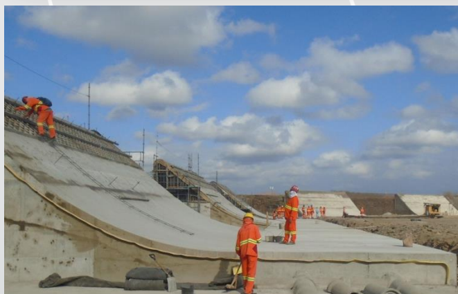
Vertedouro do Reservatório Milagres
