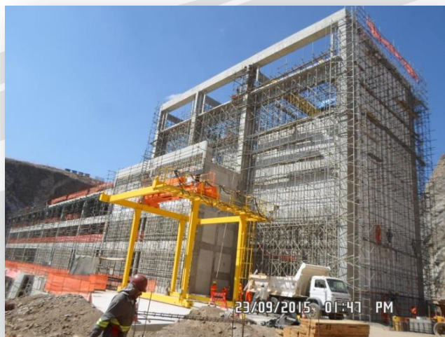
Execução da Estação de Bombeamento EBI-3
