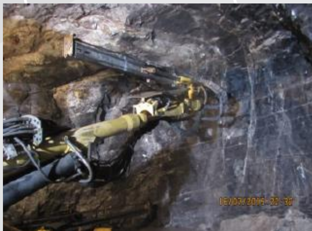
Túnel Eng. Giancarlo Lins Cavalcanti
