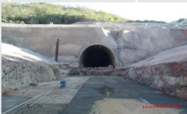
Túnel Cuncas I
