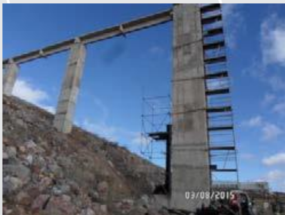
Tomada d’água do Reservatório Braúnas.
