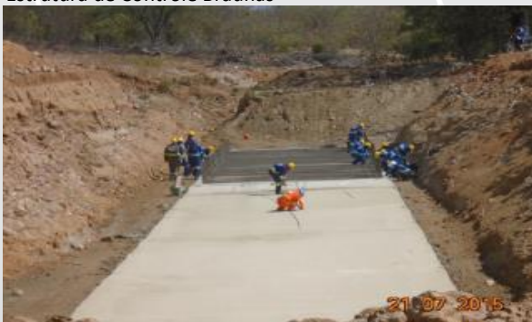
Segmento de canal entre Reservatório Salgueiro e Muquém
