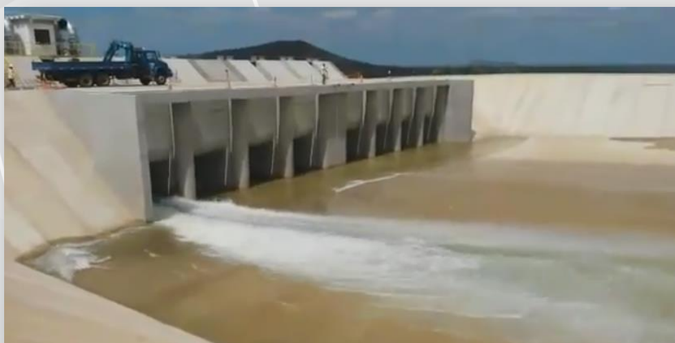
Início dos testes na estação de bombeamento EBI-1 ocorrido em 03/08/2015
