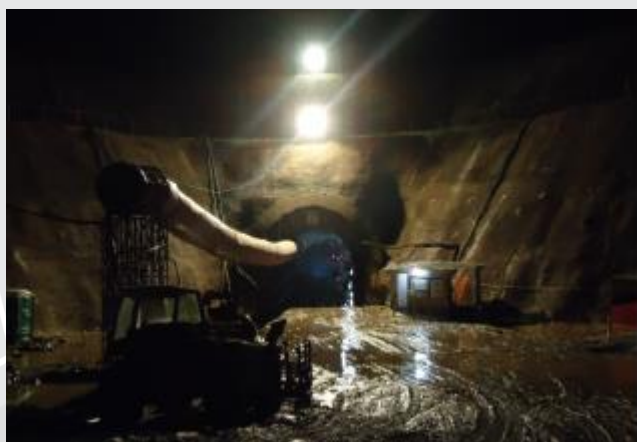
Túnel Eng. Giancarlo Lins Cavalcanti
