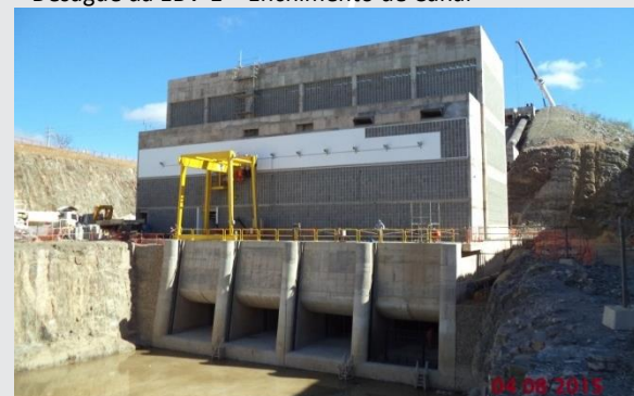
Estação de Bombeamento EBV 2
