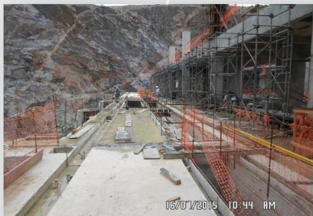
Execução da Estação de Bombeamento EBI-3
