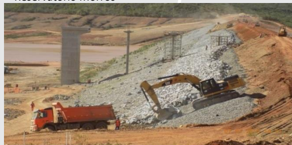
Reservatório Boa Vista
