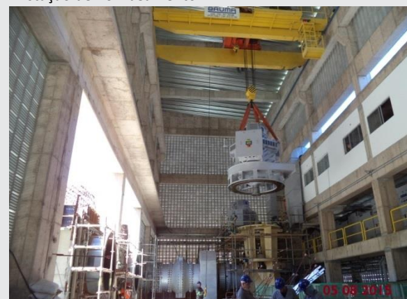
Montagem do conjunto motobomba da EBV 2.
