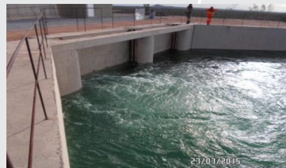
Desague da EBV-1 – Enchimento de Canal
