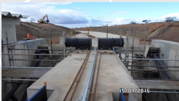
Estrutura de Controle Braúnas
