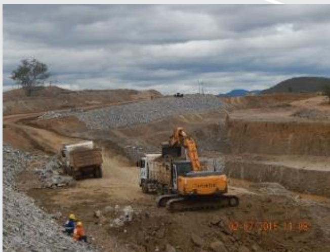
Segmento de Canal entre Túnel Giancarlo e Adutora Monteiro
