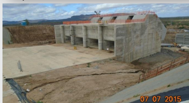
Estação de bombeamento EBI-2 – forebay de jusante
