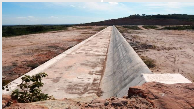
Reservatório Cipó – Vertedouro concluído.
