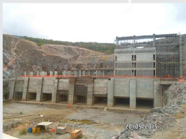
Execução da Estação de Bombeamento EBI-3
