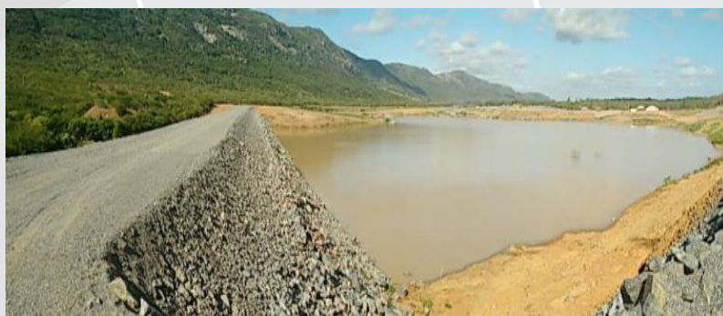
Reservatório Morros - concluído
