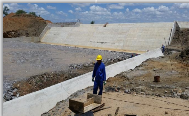
Reservatório Serra do Livramento
