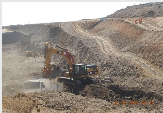
Segmento de Canal entre Túnel Giancarlo e Adutora Monteiro
