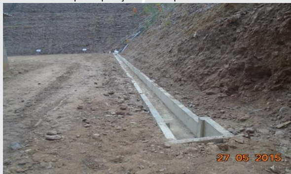
Drenagem interna em execução .
