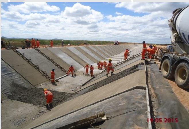
Segmento de canal entre Reservatório Salgueiro e Múquem
