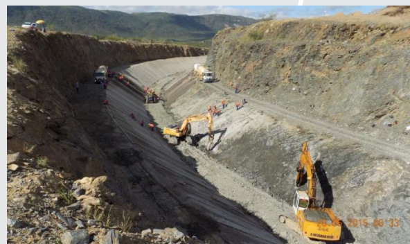
Execução de canal entre Res. Morros e Res. Boa Vista
