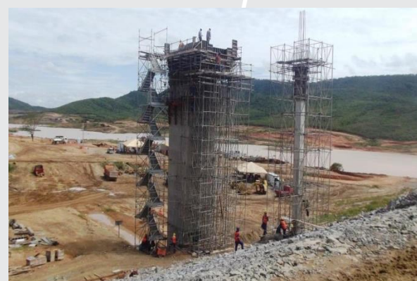
Reservatório Boa Vista
