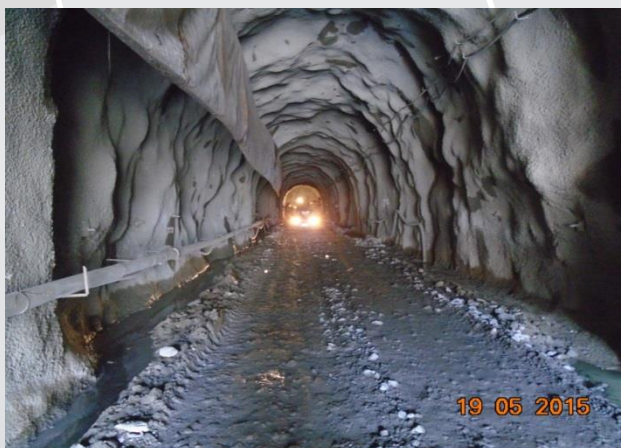
Túnel Eng. Giancarlo Lins Cavalcanti
