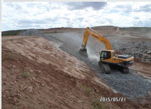
Barragem de Mandantes.
