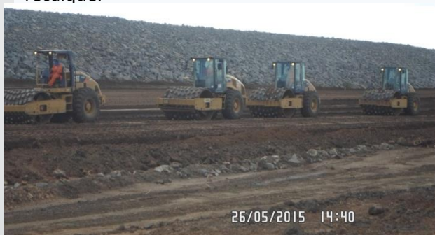
Reservatório Terra Nova
