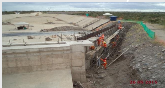
Execução do Sistema de desague da Estação EBV 2.
