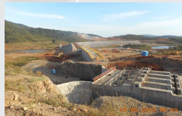
Barragem Caiçara ao fundo e estrutura de controle.
