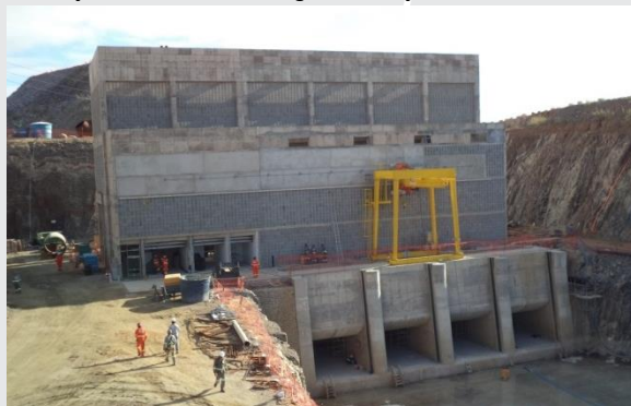
Estação de Bombeamento EBV 2 - Preparo e tratamento superficial em rocha para estruturas de concreto.
