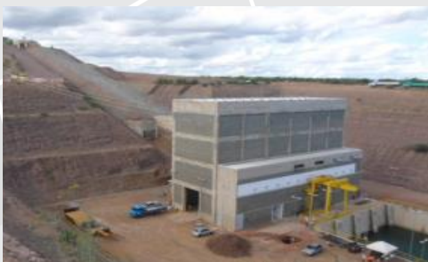
Vista frontal da Estação de Bombeamento EBV-1.
