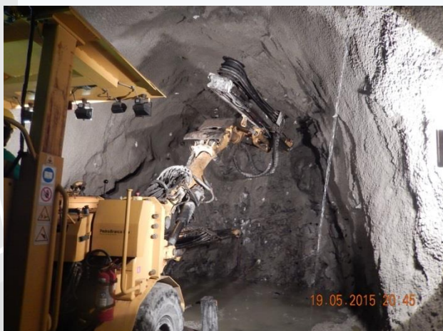
Túnel Eng. Giancarlo Lins Cavalcanti
