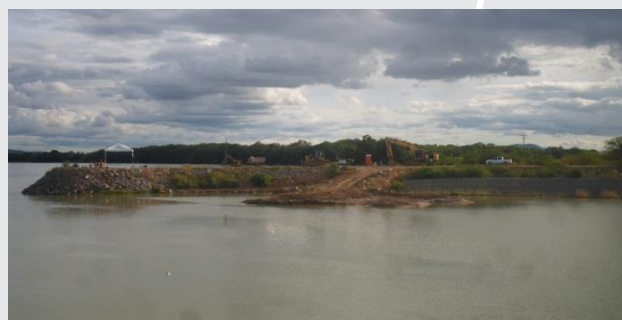
Canal de Captação - abertura do septo
