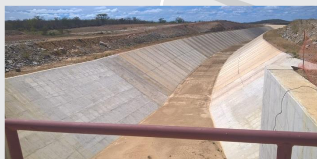
Segmento de canal após Res. Tucutu – concluído.
