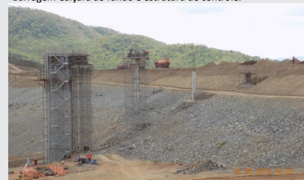
Reservatório Boa Vista - Tomada de água .
