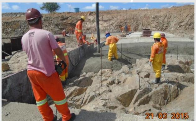
Reservatório Barreiros – fundação do vertedouro.
