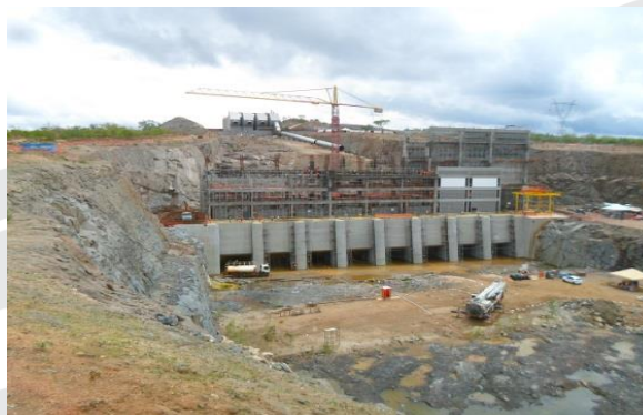
Execução da Estação de Bombeamento EBI-2
