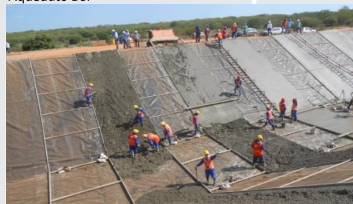
Canal entre Aqueduto Catingueira e Bueiro Palha
