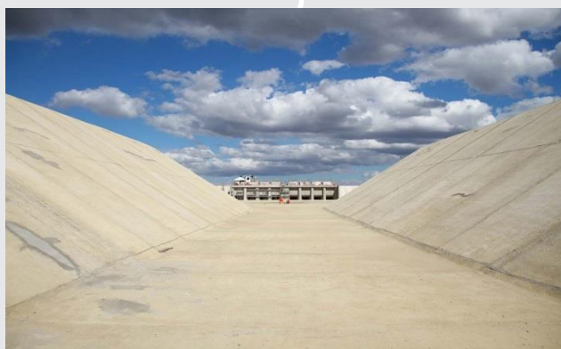
Segmento de Canal entre a EBI – 1 até Barragem Tucutu
