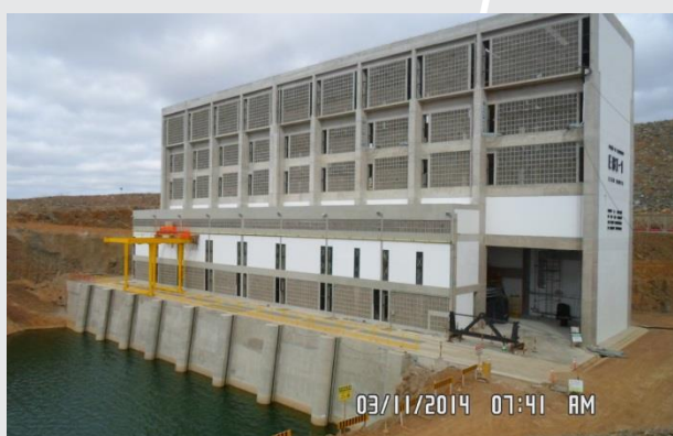
Estação de Bombeamento EBI - 1.
