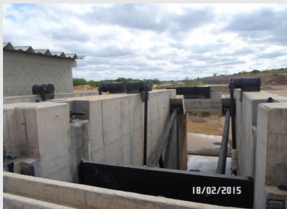
Estrutura de Controle do Reservatório Areias.
