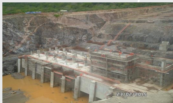
Execução da Estação de Bombeamento EBI-3
