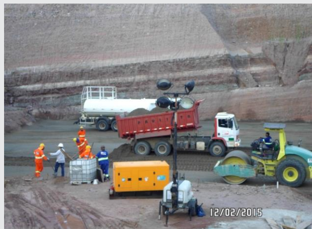
Execução de CCR. - Estação de Bombeamento EBV-3
