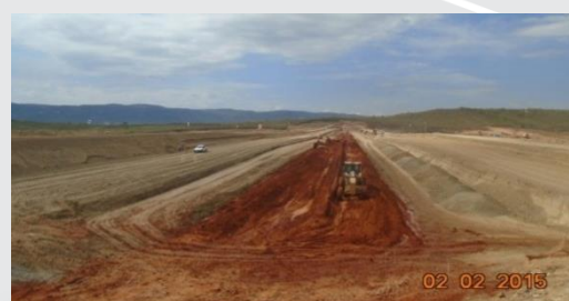
Reservatório Boa Vista
