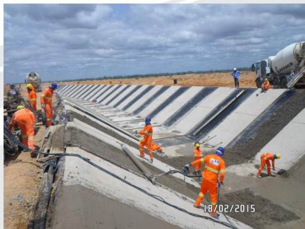
Segmento de Canal entre o Res. Salgueiro e Múquem.
