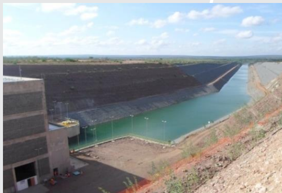
Estação de Bombeamento EBV-1.
