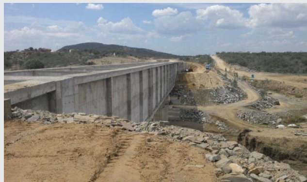
Aqueduto Terra Nova
