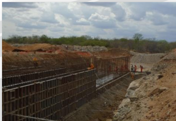
Execução de bueiro em trechos de canal em aterro..
