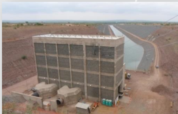
Estação de Bombeamento EBV-1.
