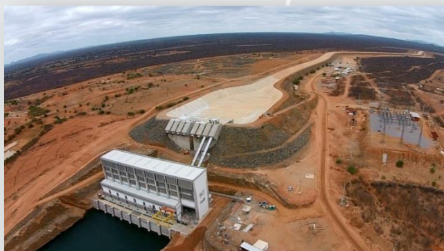
Estação de Bombeamento EBI - 1.
