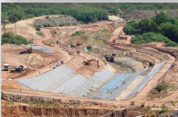
Segmento de Canal entre Jati e Atalho
