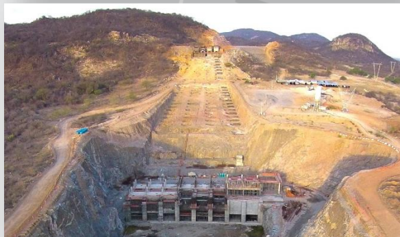
Execução da Estação de Bombeamento EBI-3
