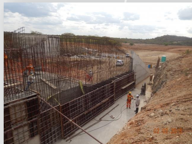
Vertedouro do Reservatório Campos.
