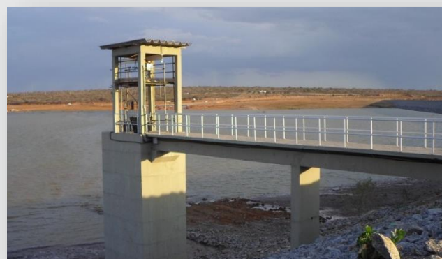
Tomada de água do Reservatório Areias.
