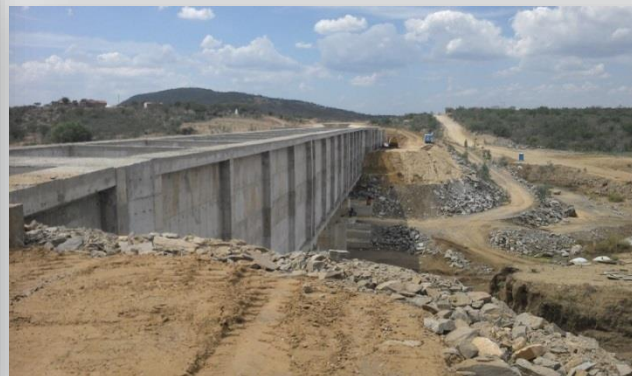
Aqueduto Terra Nova
