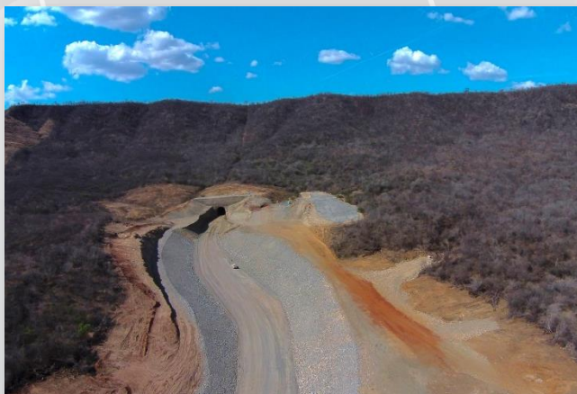
Emboque do Túnel Cuncas II.
