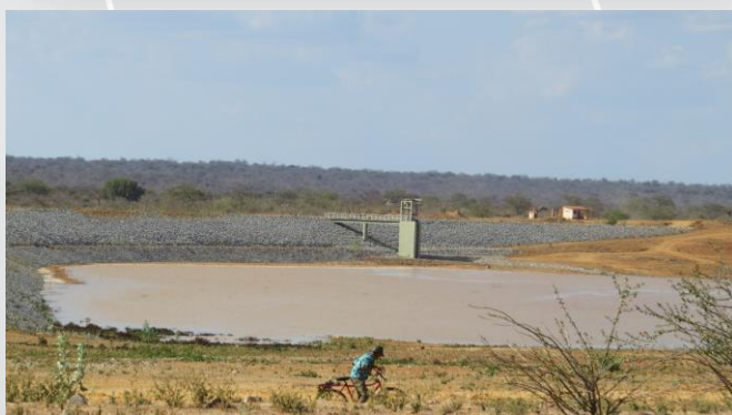
Reservatório Areias recebendo água da EBV-1.
