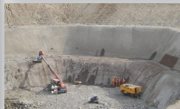
Desemboque do Túnel Giancarlo.
