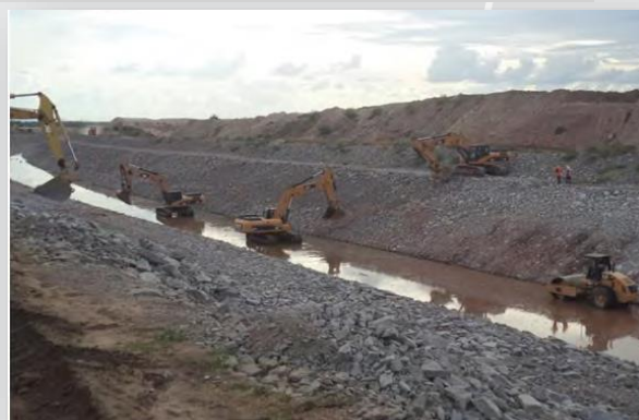
Segmento de canal entre Bueiro Palha e galeria Sobradinho
