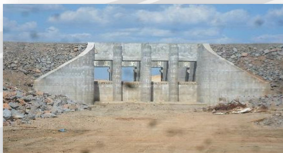
Estrutura de controle Serra do Livramento.
