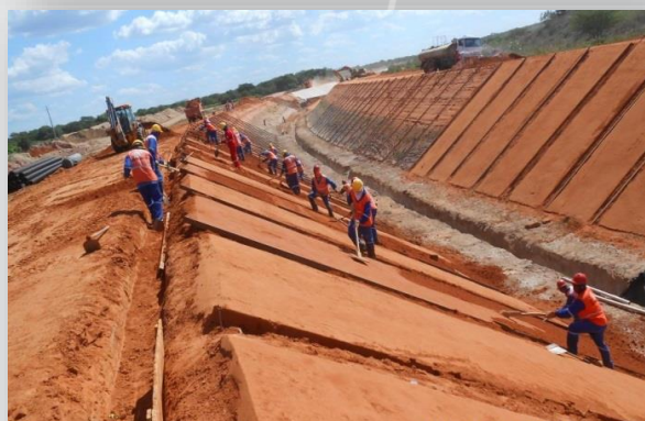
Canal entre Aqueduto Catingueira e Bueiro Palha
