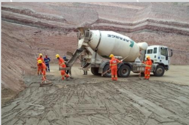
Execução de CCR. - Estação de Bombeamento EBV-3
