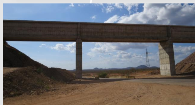
Aqueduto sobre BR-316, entre EBV-1 e Res. Areias.
