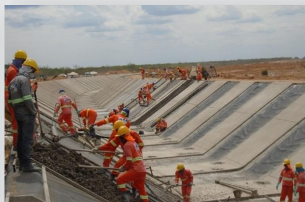
Execução da canal na Meta 2L.
