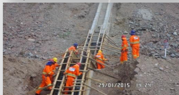
Execução de canaletas de drenagem no entorno da EBV-1.
