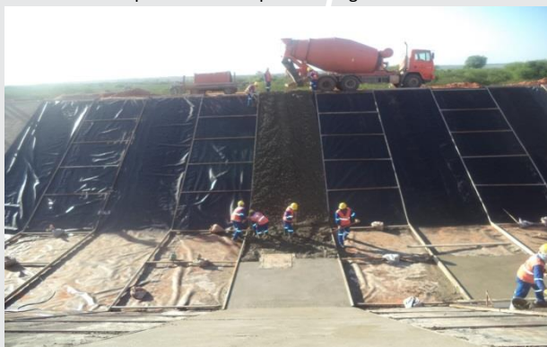
Canal entre Aqueduto Catingueira e Bueiro Palha
