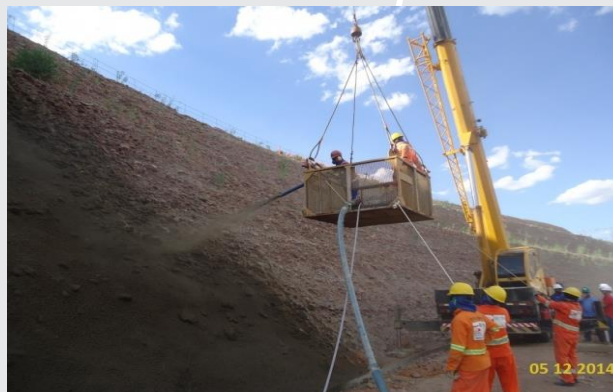
Proteção de talude - EBV-1.
