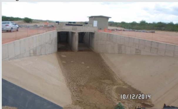
Estrutura de Controle do Reservatório Areias.
