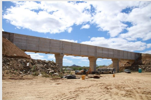
Aqueduto Saco da Serra.
