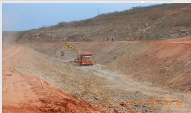
Canal entre Aqueduto Boi e Aqueduto Pinga.
