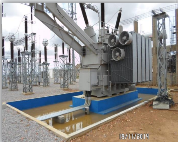
Montagem da Subestação de energia N1, junto à EBI-1.
