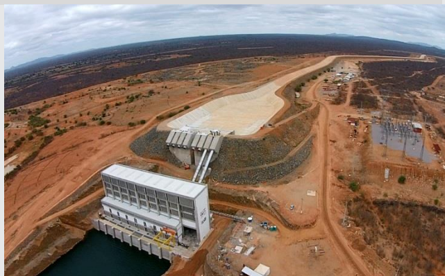
Estação de Bombeamento EBI - 1.
