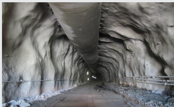
Túnel Cuncas I
