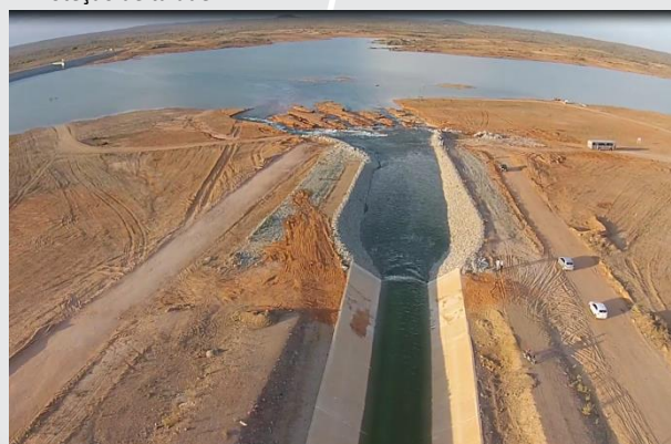
Chegada do canal no Reservatório Areias.
