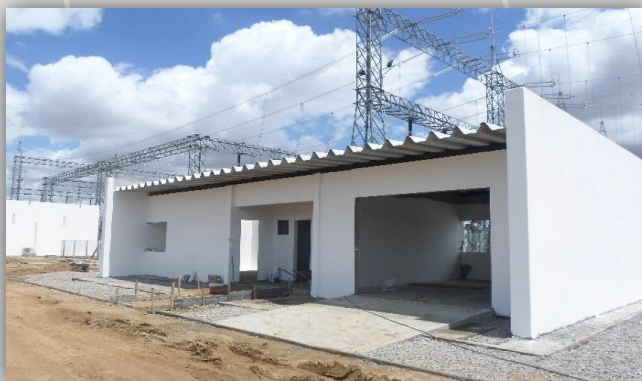
Subestação de Energia E0 – implantação da casa de apoio.
