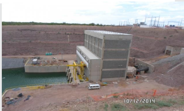
Estação de Bombeamento EBV-1.
