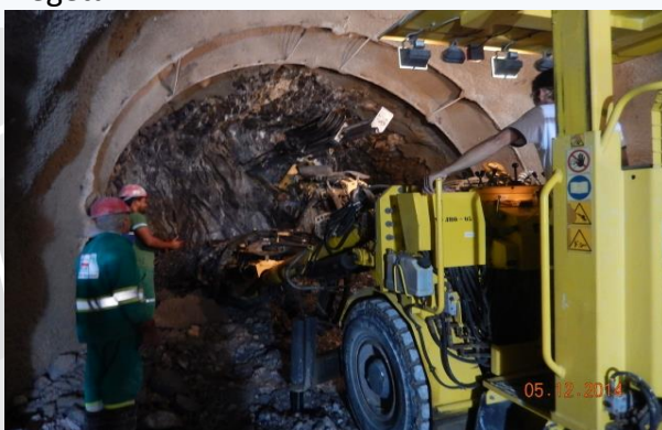
Escavação do Túnel Eng. Giancarlo Lins Cavalcanti.
