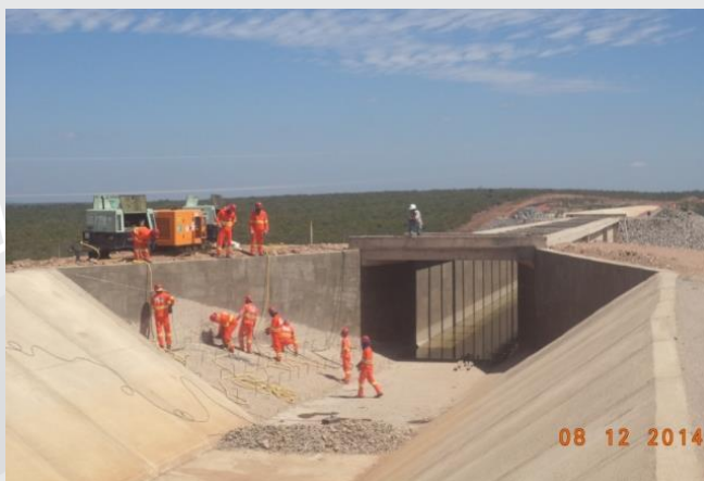
Execução de concreto ciclópico - Aqueduto sobre a BR 316.
