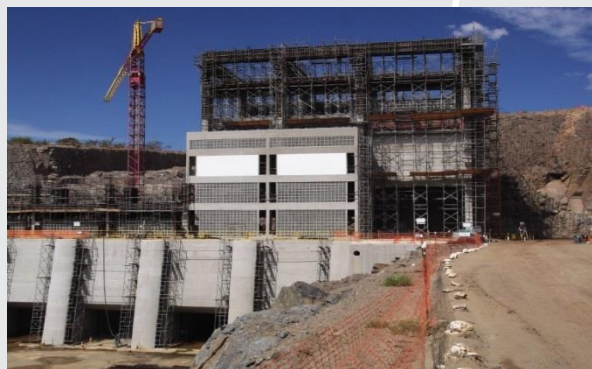
Execução da EBI-2
