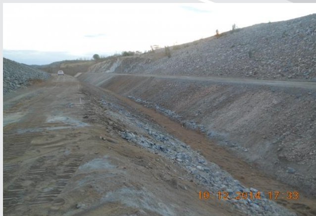
Segmento de Canal entre Res. Barro Branco e o do Túnel Eng. Giancarlo Lins Cavalcanti.
