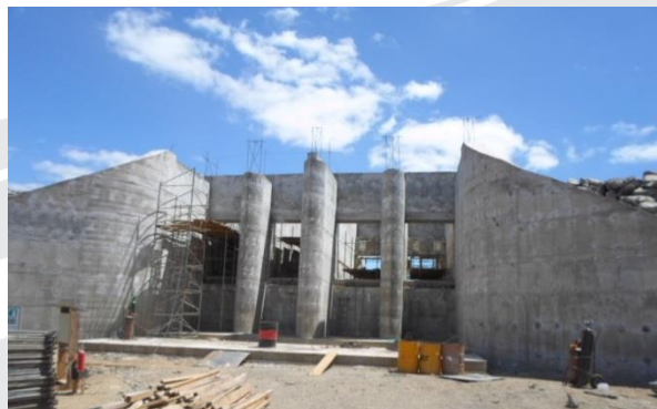
Estrutura de controle Serra do Livramento.
