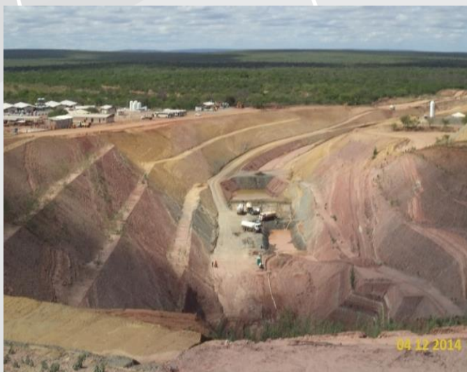
Estação de Bombeamento EBV-3
