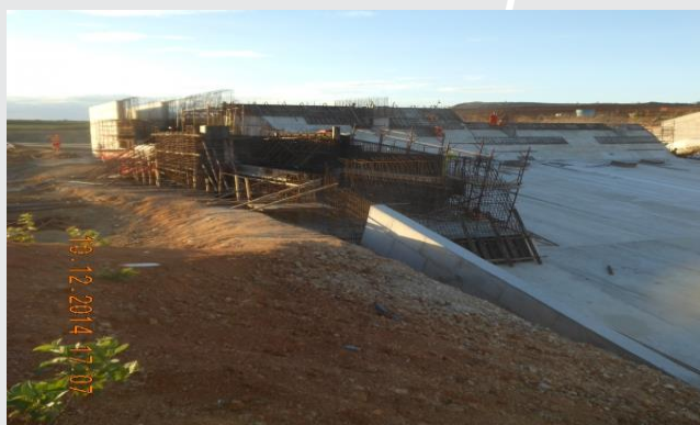
Res. Barro Branco - vista da tomada d'água e vertedouro.
