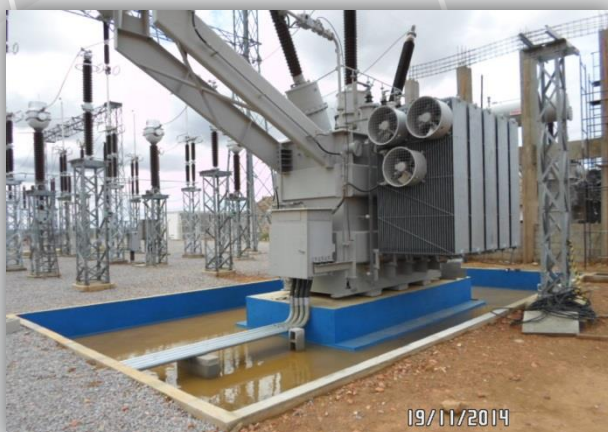
Montagem da Subestação de energia N1, junto à EBI-1.
