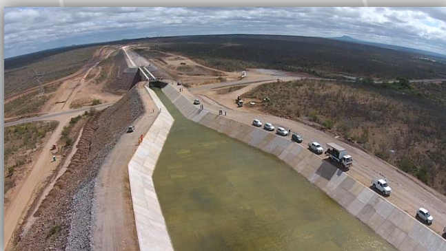
Passagem da água pelo Aqueduto sobre a BR 316.
