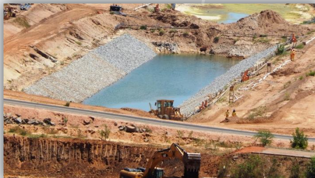
Canal de interligação dos Reservatórios Jati e Atalho.
