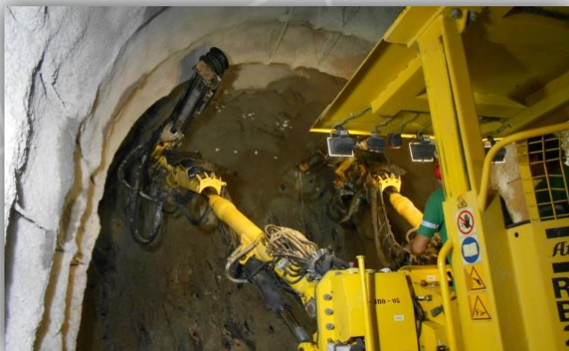
Escavação do Túnel Eng. Giancarlo Lins Cavalcanti.
