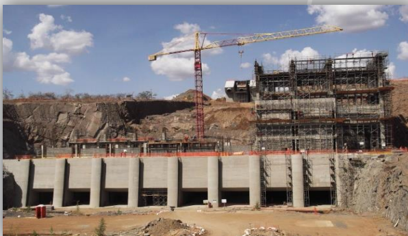
Execução da EBI-2
