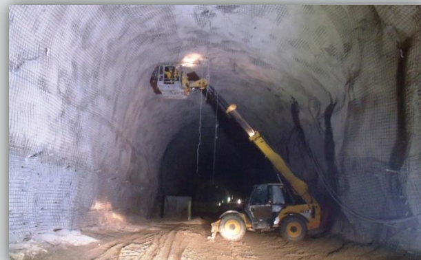
Túnel Cuncas I – concreto projetado.
