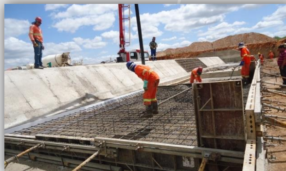
Concretagem do vertedouro do Res. Mandantes.
