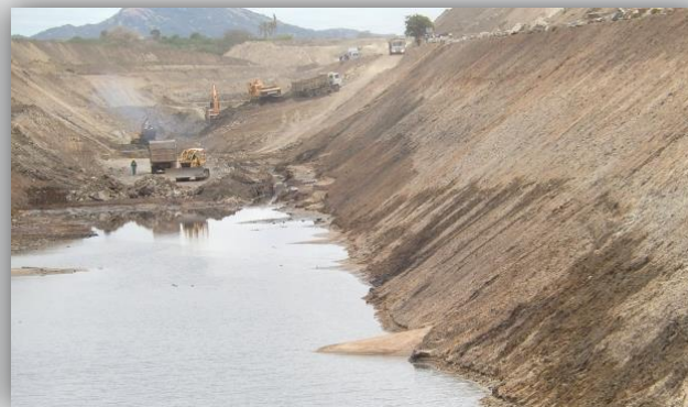
Escavação galeria Monteiro.
