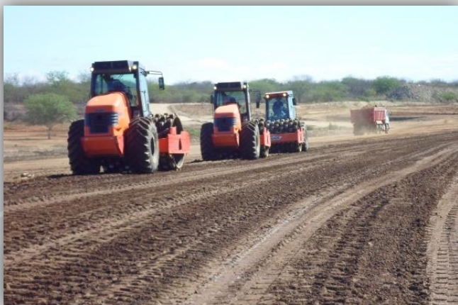
Execução do maciço do Reservatório Moxotó.
