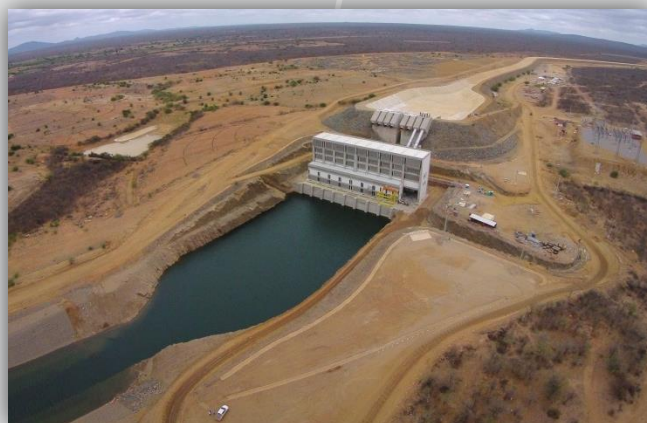
Vista aérea da Estação de Bombeamento EBI-1.
