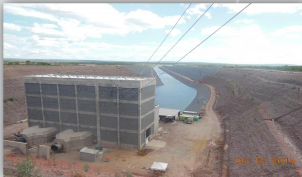
Estação de Bombeamento EBV-1.
