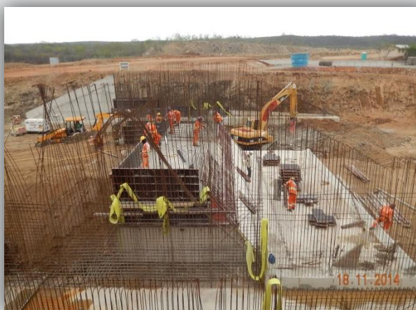
Reservatório Campos – execução do vertedouro.
