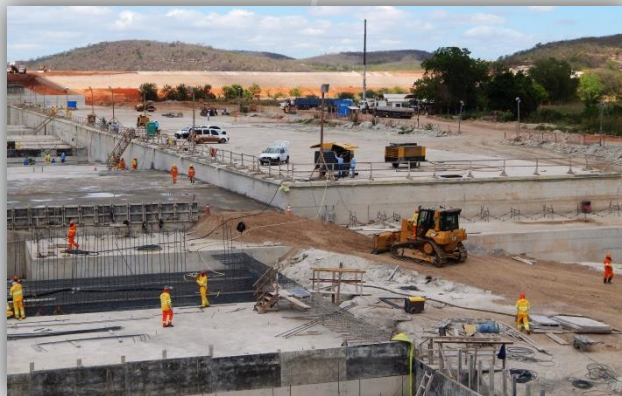
Reservatório Porcos – vista do vertedouro.
