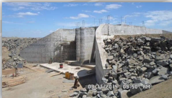
Estrutura de controle Serra do Livramento.
