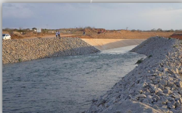
Chegada do canal no Reservatório Areias.
