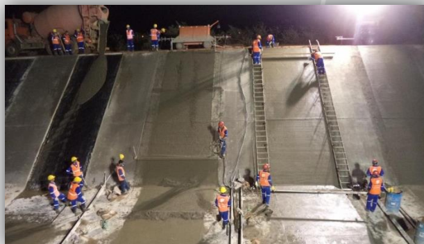
Revestimento de canal.
