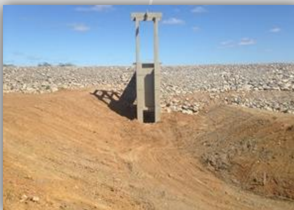
Reservatório Cacimba Nova- vista da tomada d'água.
