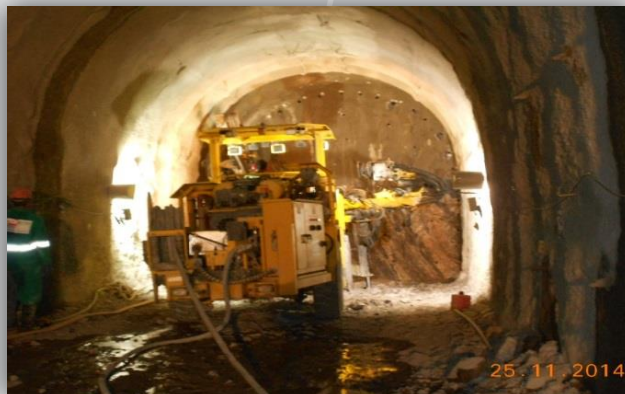
Escavação do Túnel Eng. Giancarlo Lins Cavalcanti.
