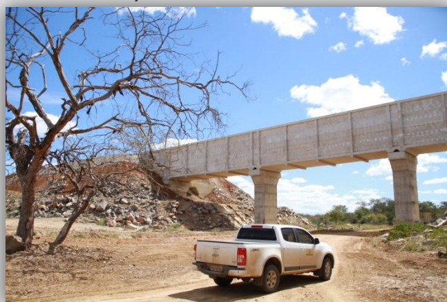
Aqueduto Logradouro concluído.
