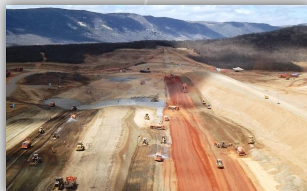
Reservatório Boa Vista.
