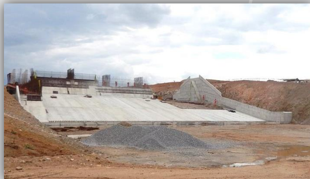
Res. Barro Branco - vista da tomada d'água e vertedouro.
