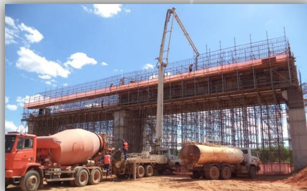
Concretagem do Aqueduto Pinga.
