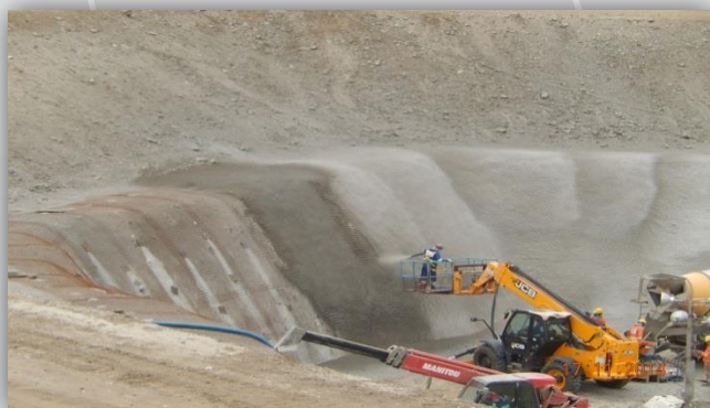
Desemboque Túnel Eng. Giancarlo Lins Cavalcanti - concreto projetado.
