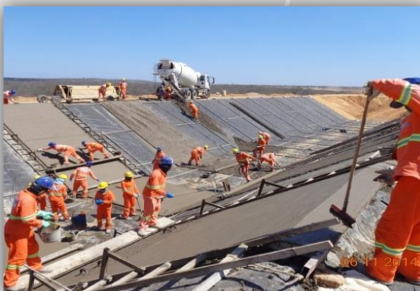
Segmento de Canal entre o Res. Salgueiro e Múquem.
