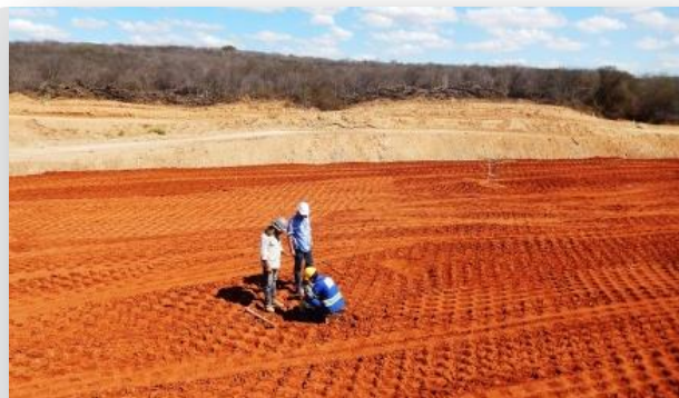
Reservatório Barro Branco: execução do aterro do maciço
