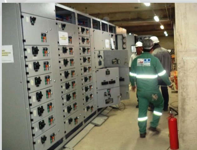
Comissionamento dos quadros de distribuição de energia dos motores.
