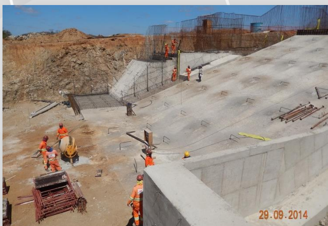
Reservatório Moxotó – execução do vertedouro.
