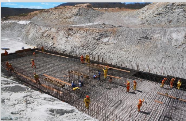
Concretagem do Vertedouro da Barragem Cana Brava
