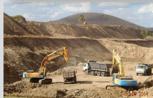
Escavação do canal a jusante do Túnel Monteiro.
