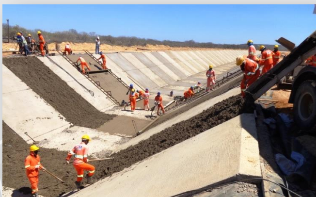
Concretagem de canal entre Res. Salgueiro e Muquém.
