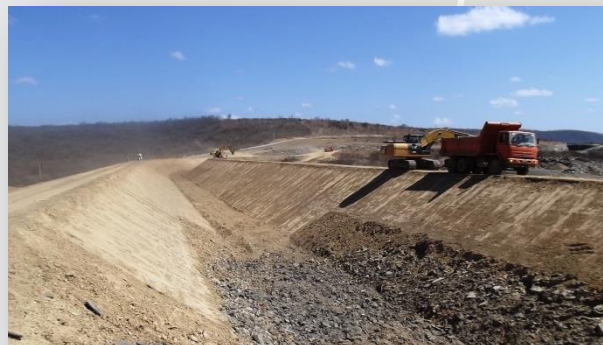
Execução de limpeza de canal
