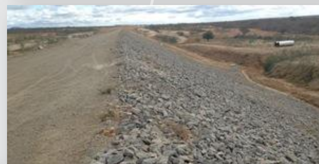
Maciço do Reservatório Muquém
