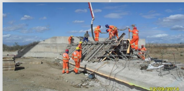
Concretagem do vertedouro do Res. Braúnas.
