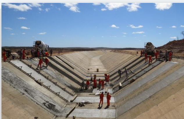
Canal entre Reservatórios Negreiros e Milagres
