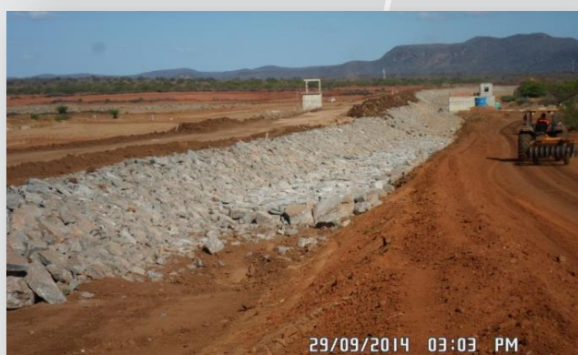
Tomada d'água do Reservatório Terra Nova.
