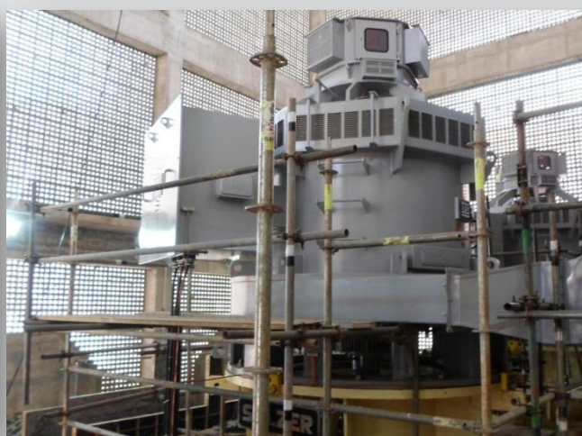
Motor nº 2 da EBV-1 sendo comissionado.
