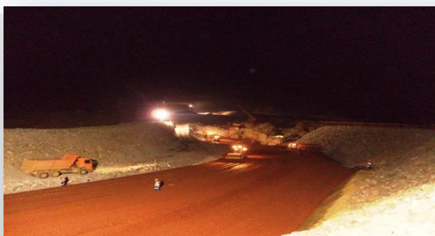
Trabalho noturno no Reservatório Caiçaras.
