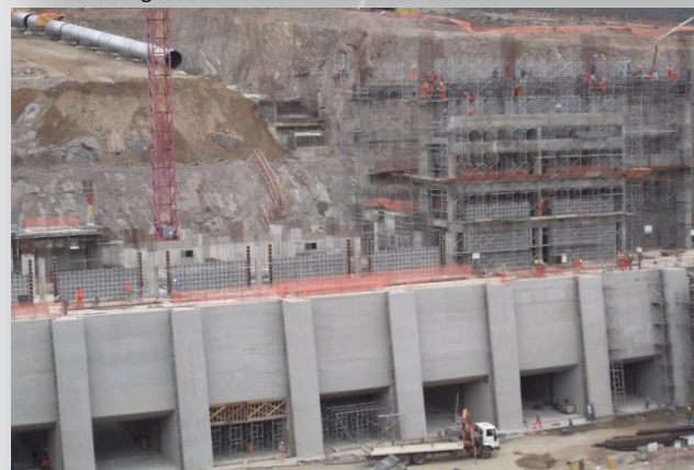
Execução da EBI-2
