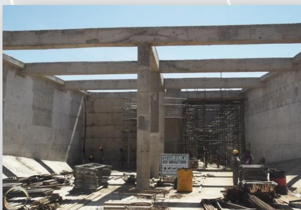
Aqueduto Salgueiro.- vista da transição de jusante.
