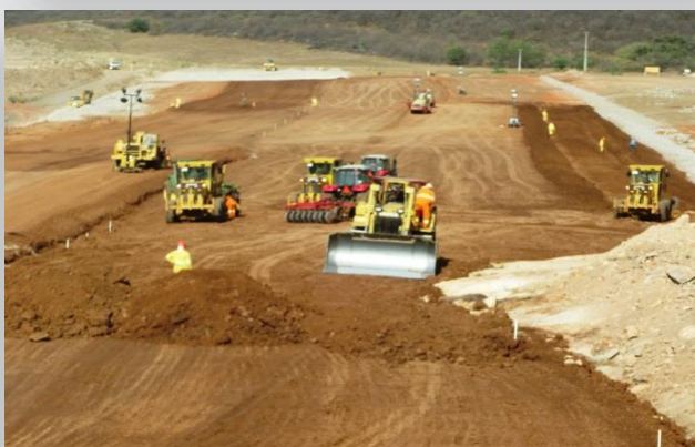
Terraplanagem no Reservatório Cana Brava
