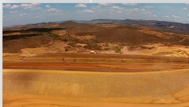
Reservatório Boa Vista.
