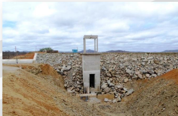
Vista do vertedouro do Reservatório Mangueira.
