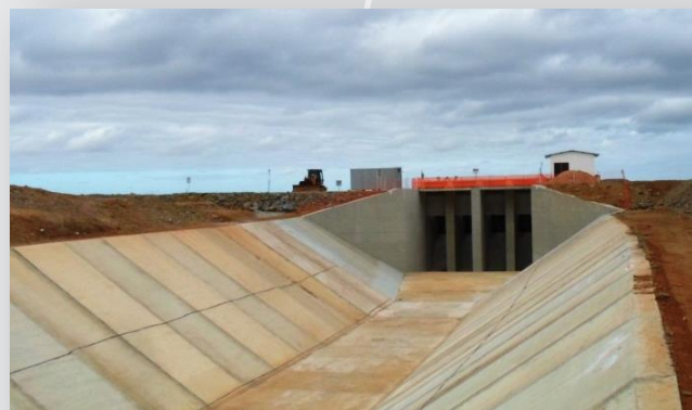
Vista do canal após estrutura de controle do Res. Tucutú.
