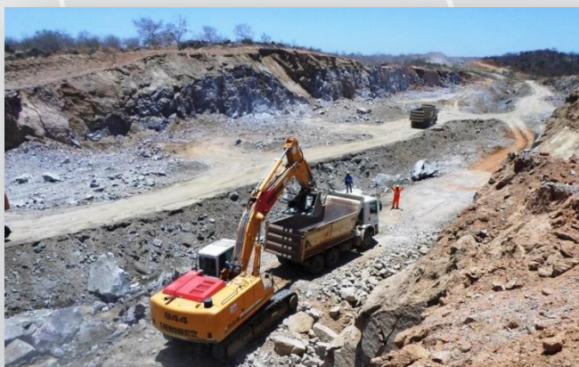
Escavações no segmento de canal entre Res. Braúnas e Mandantes.
