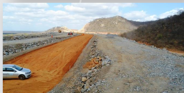
Execução do dique Negreiros.
