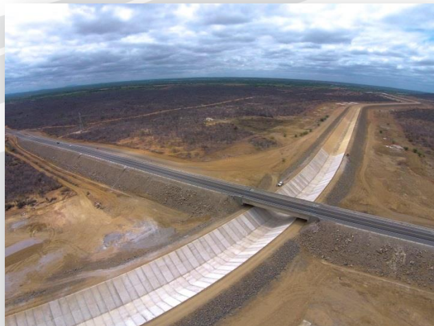
Trecho de canal entre EBI-1 e Res. Tucutú, cruzando com BR-428.
