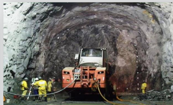
Túnel Cuncas I
