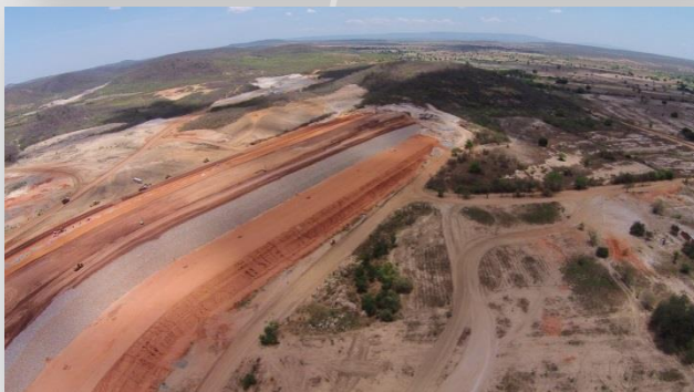
Vista Panorâmica do Vertedouro do Res. Porcos
