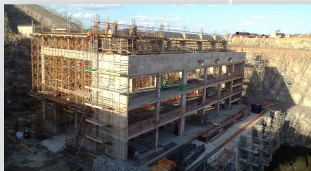
Vista da estação de bombeamento EBV-2
