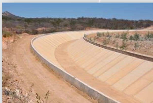
Segmento de canal concluído no Lote 10.
