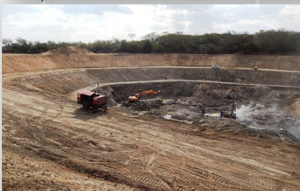
Desemboque Túnel Monteiro
