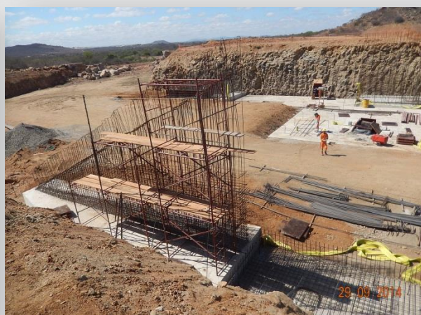
Reservatório Campos – execução do vertedouro.
