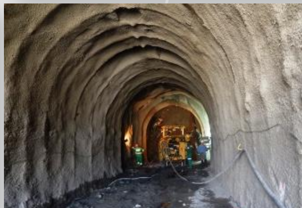
Emboque do Túnel Monteiro
