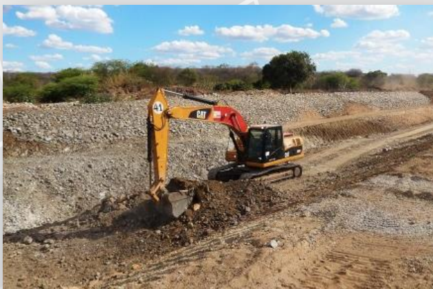
Escavação do canal a montante do Túnel Monteiro.
