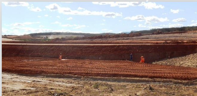
Reservatório Barro Branco: execução do aterro do maciço
