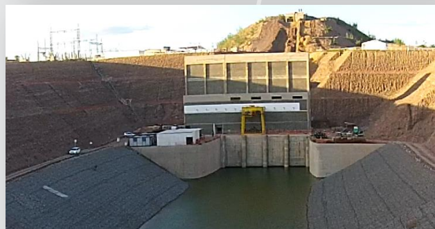
Estação de Bombeamento EBV-1.
