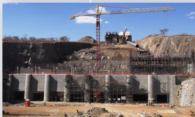
Vista frontal /da Estação de Bombeamento EBI-2.
