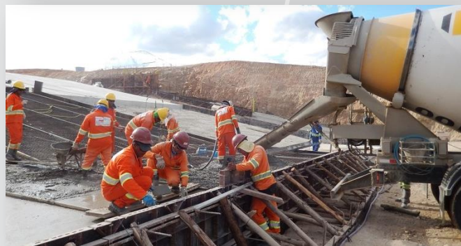
Reservatório Barro Branco: concretagem do vertedouro.
