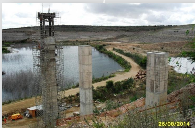
Reservatório Braúnas – execução da tomada d’água.
