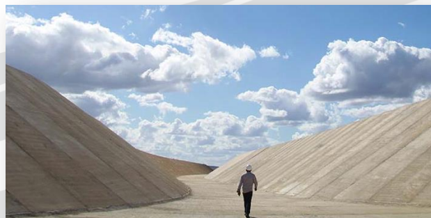
Canal concluído entre Res. Tucutú e Aqueduto Logradouro.
