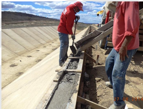
Reservatório Bagres – execução de canaleta de drenagem
