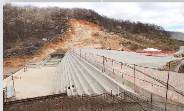
Reservatório Negreiros – vista do barramento em CCR.
