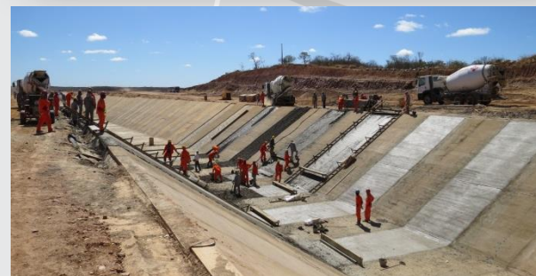
Canal entre Reservatórios Negreiros e Milagres
