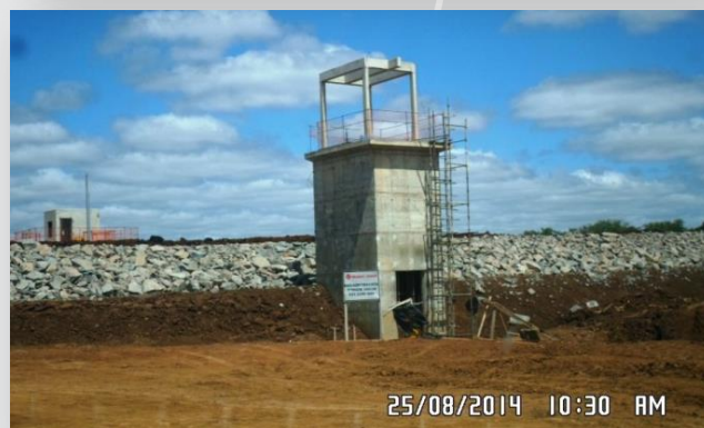
Tomada d'água do Reservatório Terra Nova.
