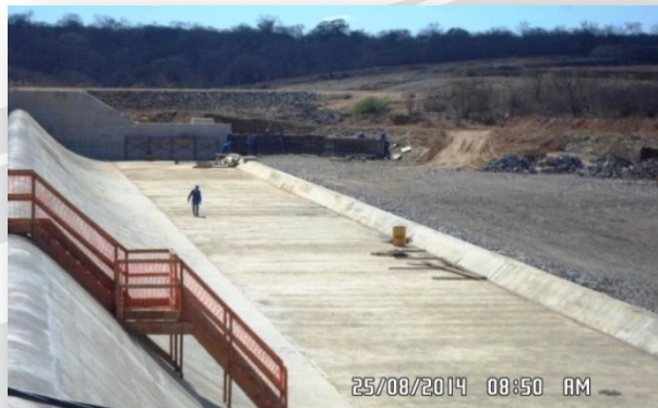
Vista do vertedouro do Reservatório Mangueira.
