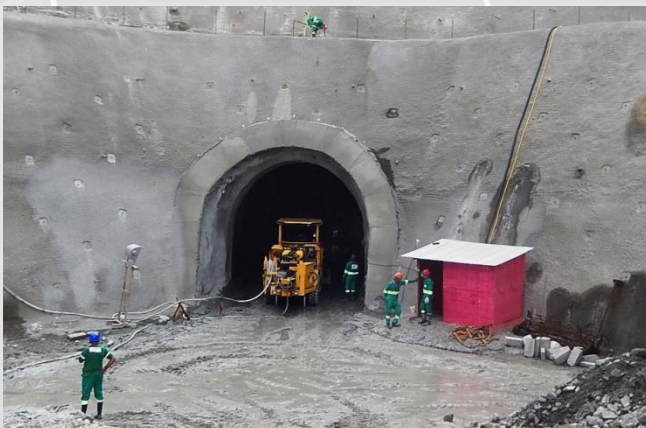
Emboque do Túnel Monteiro
