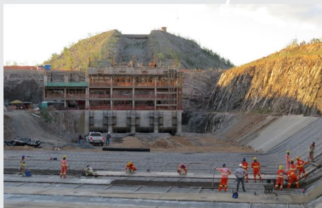
Vista da estação de bombeamento EBV-2
