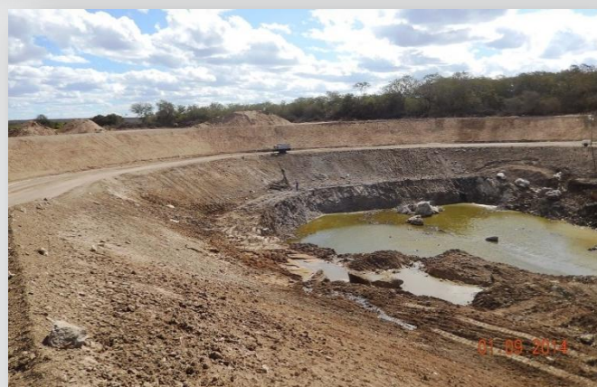
Desemboque Túnel Monteiro
