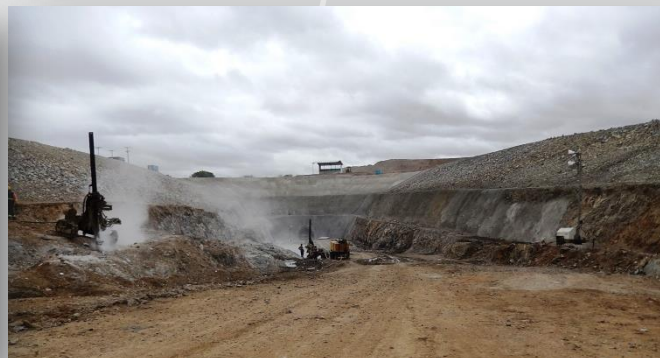
Escavação do canal a montante do Túnel Monteiro.
