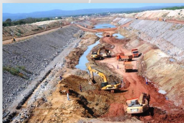
Segmento de canal a montante do Túnel Cuncas I.
