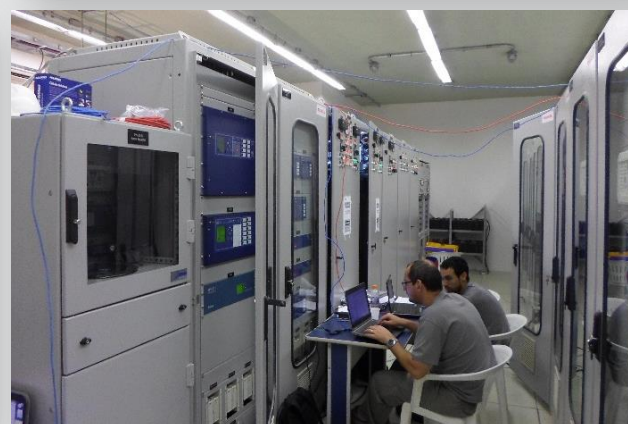
Comissionamento da sala de comanda da subestação E0.
