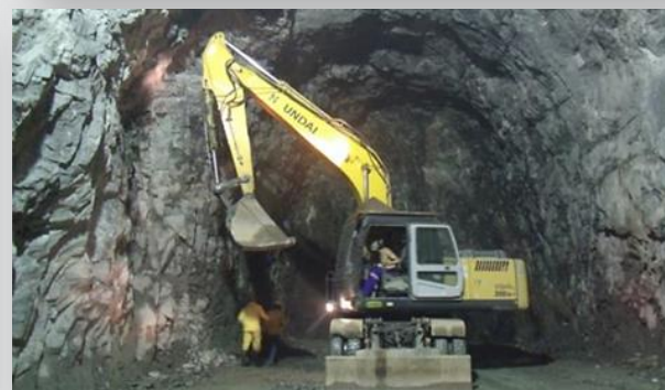
Túnel Cuncas I
