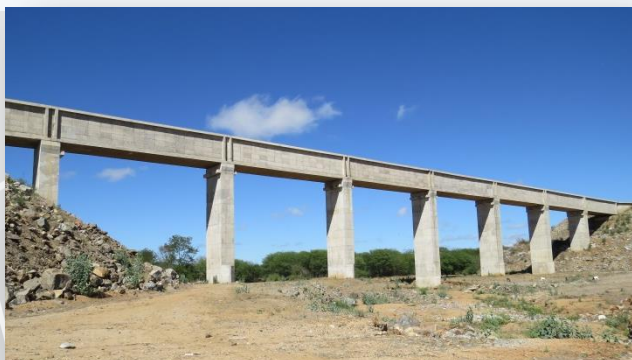
Aqueduto Branco – Concluído.
