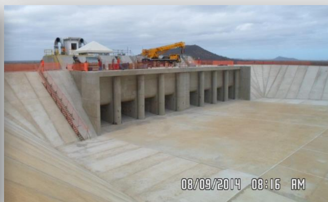
Forebay de jusante da EBI-1 concluído.
