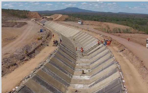
Frente de serviço executando o canal.
