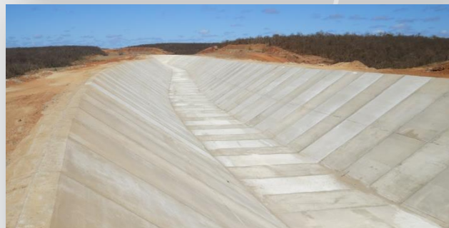
Segmento de canal concluído.
