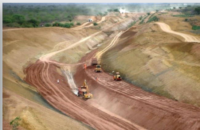
Execução do canal a montante da EBV-3.
