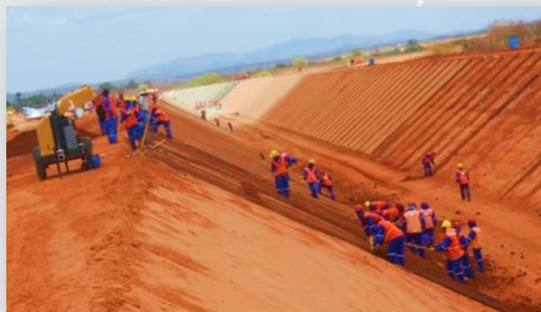
Segmento de canal em execução.
