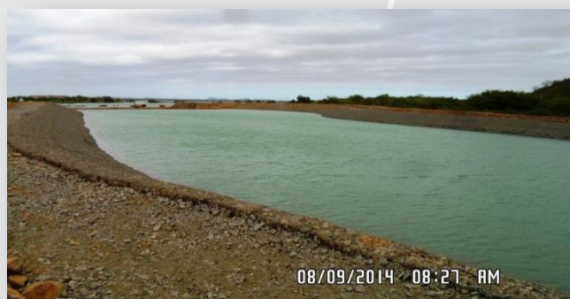
Canal de Captação junto ao Rio São Francisco – concluído enchimento.
