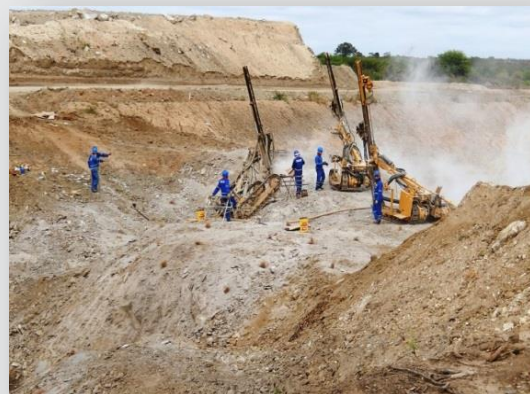
Desemboque Túnel Monteiro
