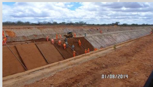
Execução de regularização do canal
