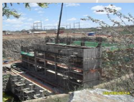
Vista da estação de bombeamento EBV-2
