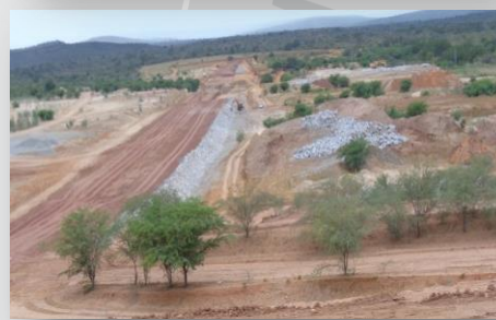
Reservatório Mandantes – execução do barramento
