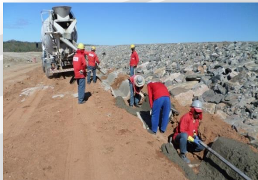
Reservatório Bagres – execução de canaleta de drenagem
