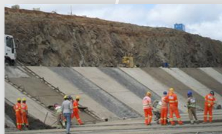
Execução do revestimento de canal
