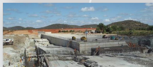
Vista Panorâmica do Vertedouro do Res. Porcos
