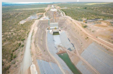
Vista aérea do canal de aproximação e EBV-1.
