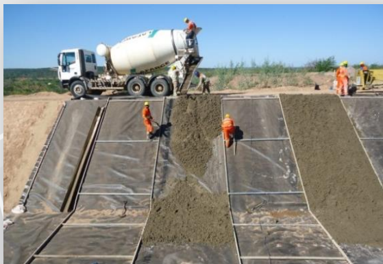
Execução de canal entre Res. Braúnas e Mandantes
