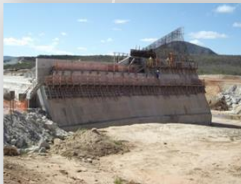
Execução do Muro do Vertedouro – Res. Porcos
