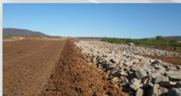
Reservatório Terra Nova
