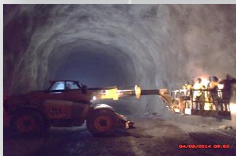
Cuncas I: Aplicação da 2ª malha de tela na janela ao desemboque
