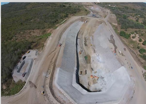
Emboque do Túnel Monteiro
