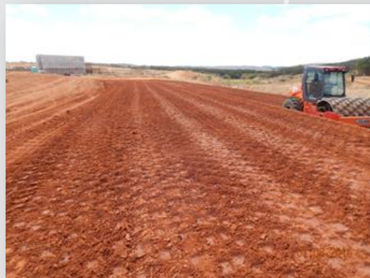
Reservatório Barro Branco: compactação aterro solo argiloso
