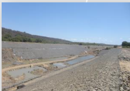
Canal de Captação junto ao Rio São Francisco.
