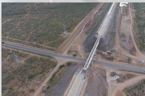
Canal e Aqueduto da BR-316.
