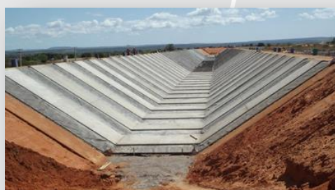
Etapas construtivas do canal
