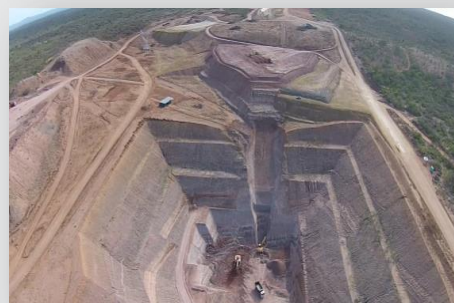
Estação de Bombeamento EBV-3.
