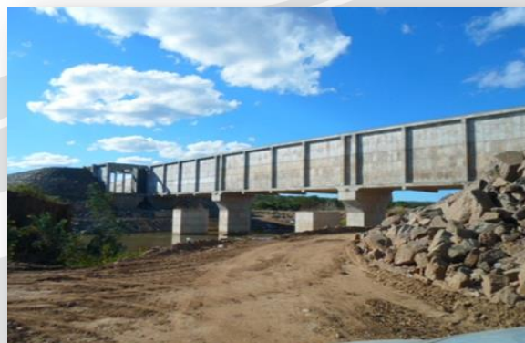
Aqueduto Terra Nova
