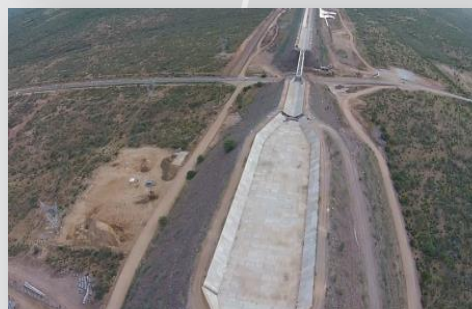
Estação de bombeamento EBV-1.
