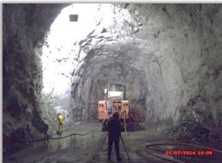
Cuncas I: Marcação topográfica dos furos para detonação
