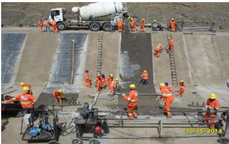
WBS 2206 - Segmento de canal: Execução de concreto de revestimento e proteção da geomembrana (fabricação e lançamento). Est. 845
