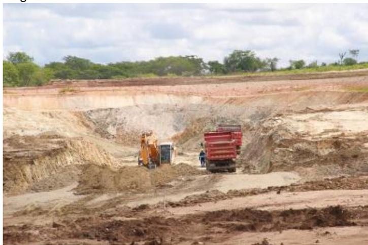
Túnel Monteiro - Escavação do emboque.
