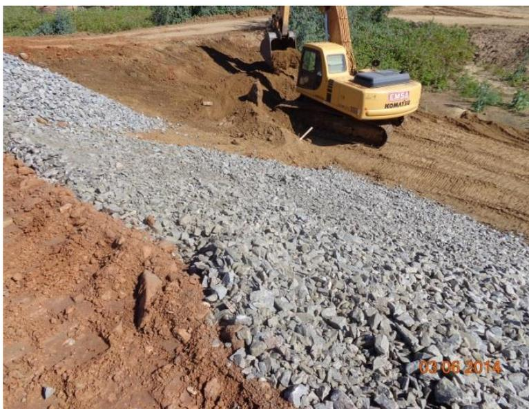
Reservatório Cacimba Nova: Execução Transição lançada e enrocamento lançado
