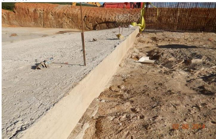
Barragem Barro Branco: Concreto magro vertedor/ferragem tomada d'água.
