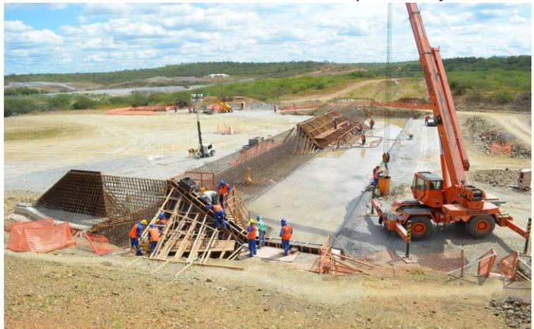
Reservatório de Morros: Concretagem do creager do vertedouro.
