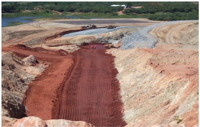
Reservatório Caiçara: Aterro compactado do cut-off com material argiloso.
