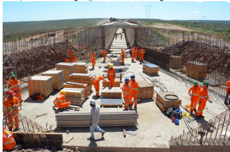
Aqueduto sobre BR-316: Execução de forma e armação em barras de aço, aplicação de concreto na transição de montante.
