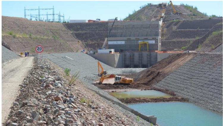
EBV-1: Escavação de material com carga e transporte até a 1,00 km e execução de gabião manta (fornecimento e instalação).
