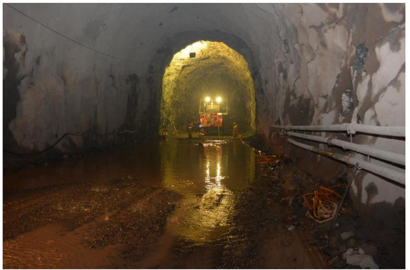
Túnel Cuncas I: Emboque Cuncas I - batimento do choco na estaca 106+18,85m.
