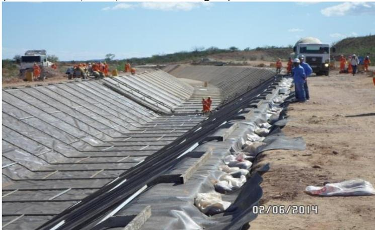
WBS 2208 - Segmento de Canal: Execução de concreto de revestimento e proteção da geomembrana (fabricação e lançamento).
