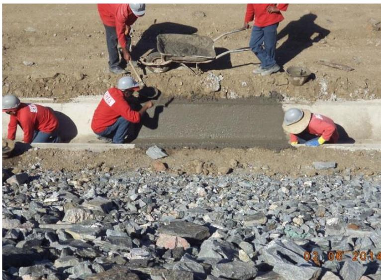
Barragem Bagres: Execução de Canaletas de drenagem moldadas in loco
