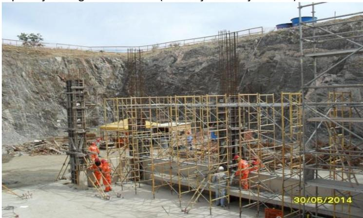
WBS 2620 - EBV-2: Execução de forma e armação em barras de aço (fornecimento, corte, dobra e montagem).
