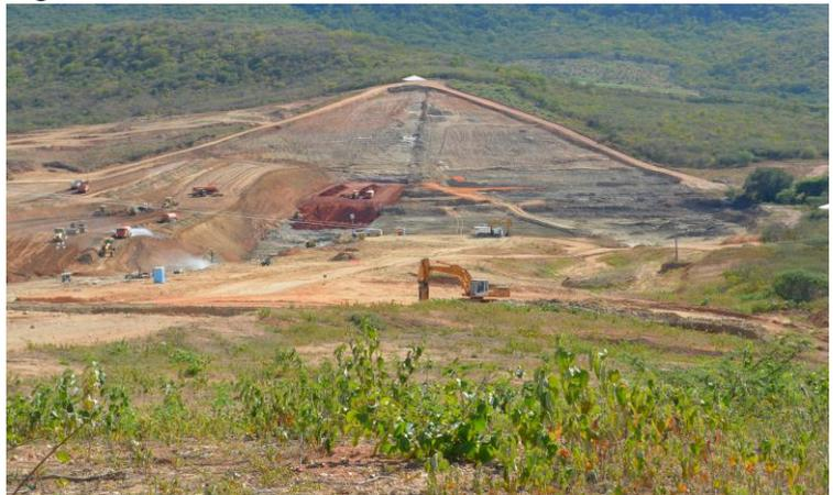
Reservatório Boa Vista: Vista panorâmica da ombreira esquerda para a ombreira direita. Aterro compactado do espaldar de montante, cut-off e filtro horizontal no espaldar de jusante.
