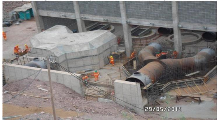
EBV-1: Execução de forma e armação em barras de aço (fornecimento, corte, dobra e montagem), do bloco de ancoragem.
