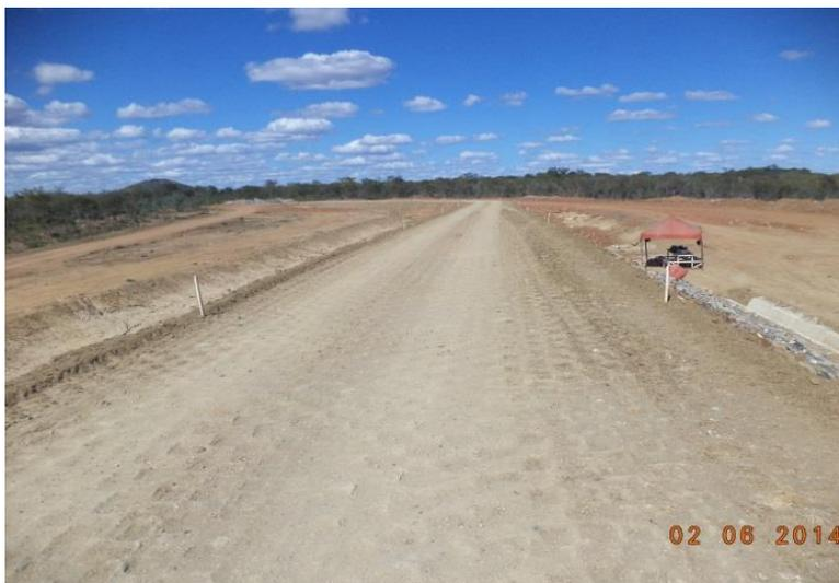
Barragem Bagres: Execução de aterro compactado
