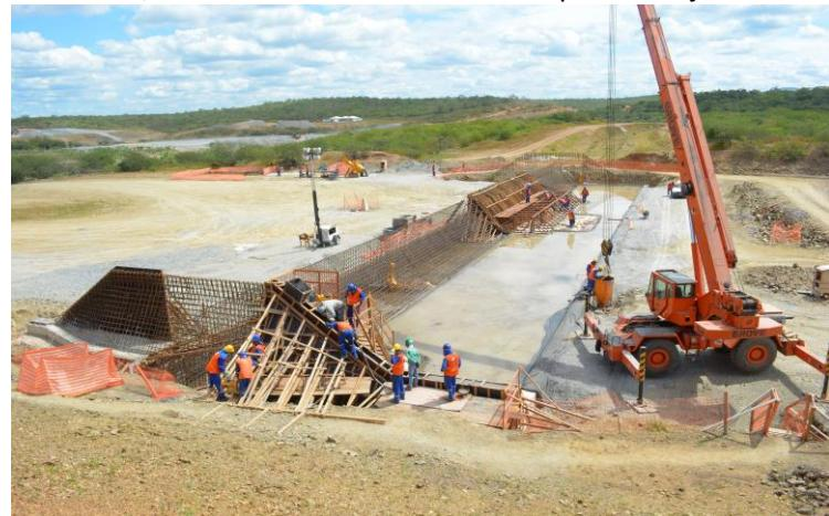
Reservatório de Morros: Concretagem do creager do vertedouro.
