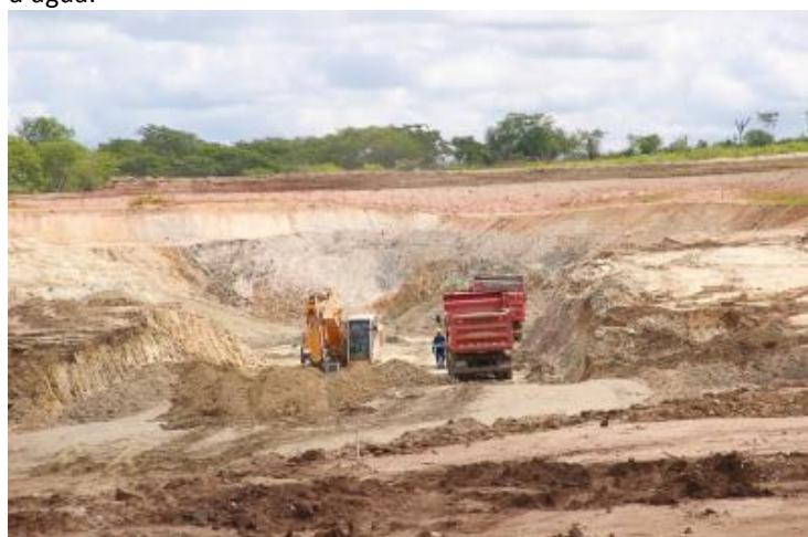
Túnel Monteiro - Escavação do emboque.
