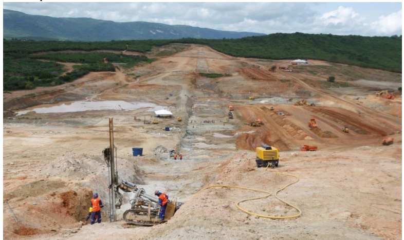
Reservatório Boa Vista: execução da fundação.
