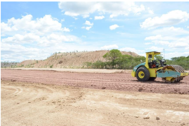
Execução do barramento do Reservatório Salgueiro.
