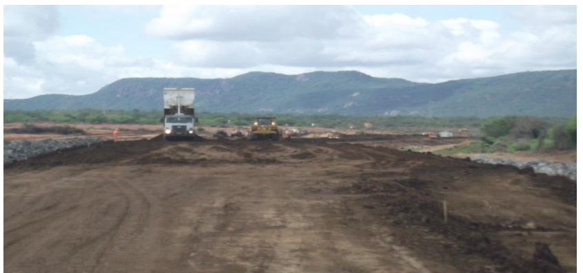
WBS 1106 - Reservatório Terra Nova
