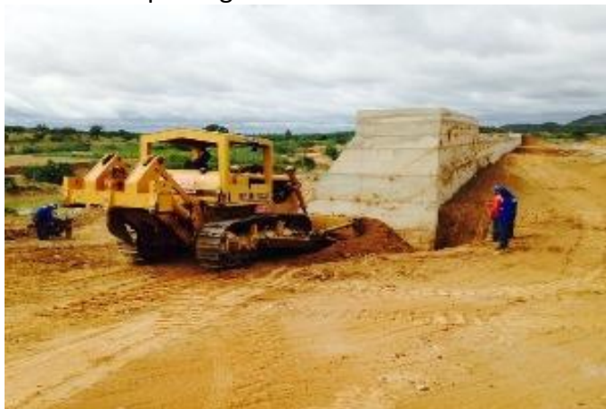
Terraplenagem Cacimba Nova
