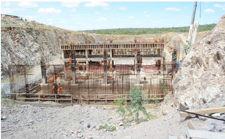
WBS 2620 - EBV-2: Concretagem do edifício da 2ª Estação de bombeamento do Eixo Leste.
