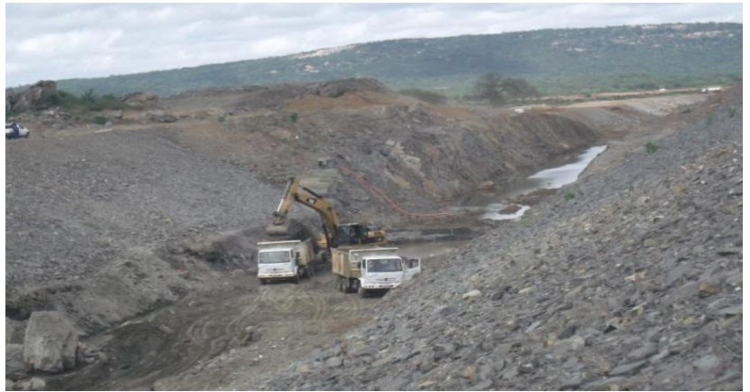
WBS 1212 – Segmento de Canal CN8
