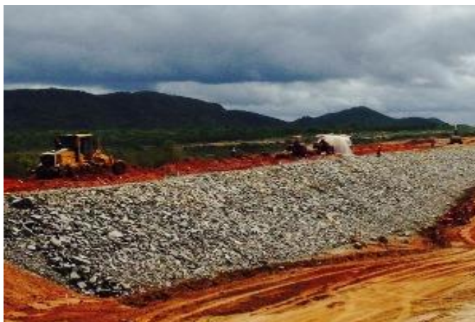
Terraplenagem Barragem Bagres
