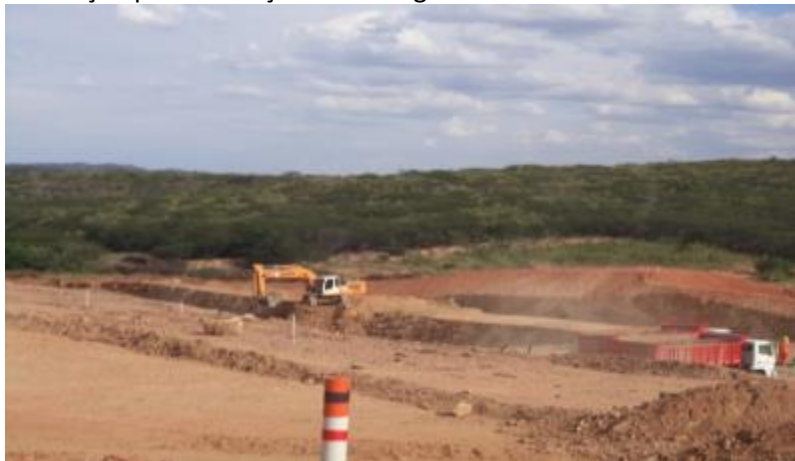
Escavação para fundação da Barragem Barro Branco.
