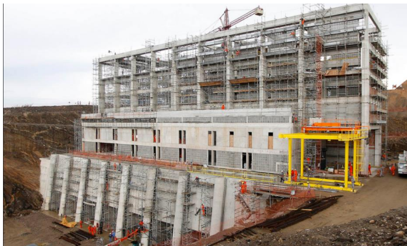
EBI-1: Vista geral da construção do edifício da casa de bombas.
