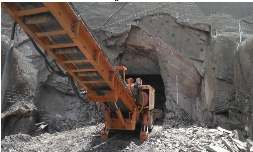
Escavações no emboque do Túnel Milagres-Jati.
