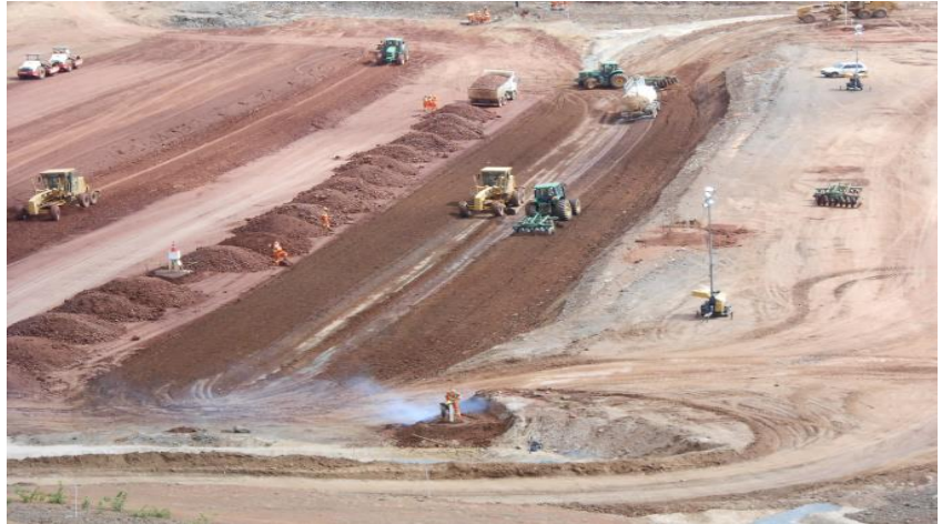
WBS 1111 - Reservatório Jati – Execução da terraplenagem.
