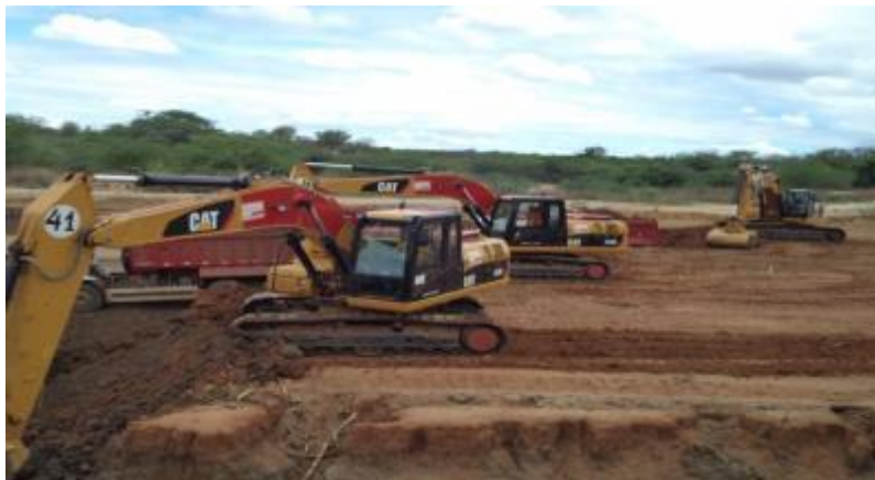
Escavação para fundação da Barragem Moxotó.
