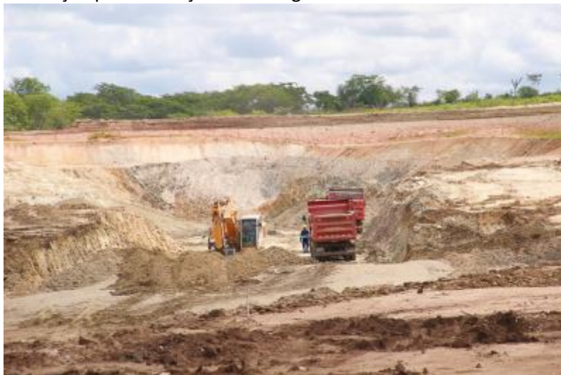
Túnel Monteiro - Escavação do o emboque.
