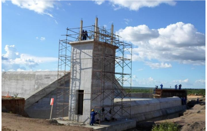
Reservatório Serra do Livramento
