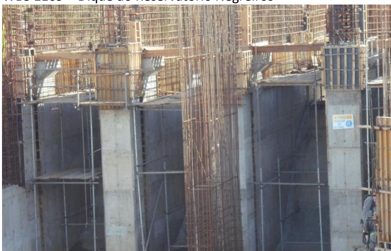
Estrutura de Controle de Serra do Livramento.
