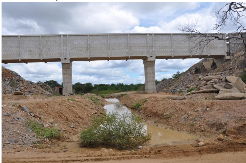
WBS 1305 - Aqueduto Logradouro
