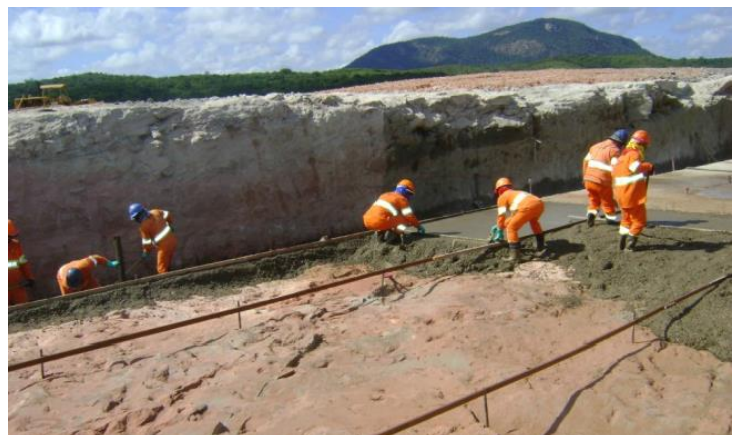
Reservatório Cipó: Concretagem fundação do vertedouro.
