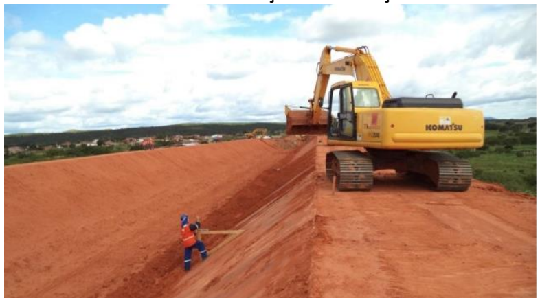
Execução de canal.
