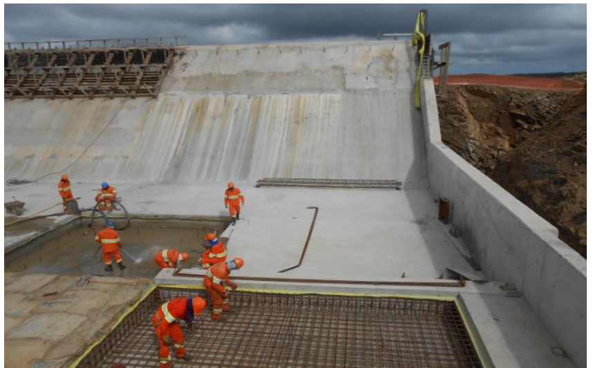
WBS 1111 - Reservatório Jati – Concretagem do vertedouro.
