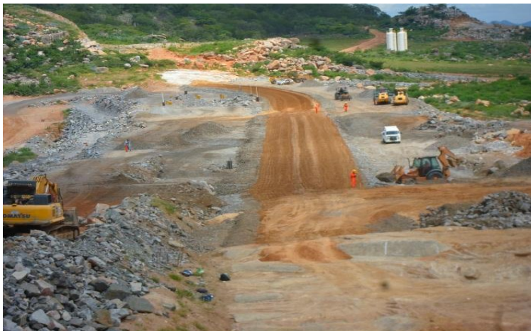
WBS 1109 – Dique do Reservatório Negreiros
