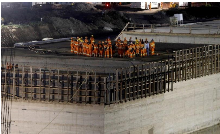
Reservatório Porco: Execução noturna do barramento.
