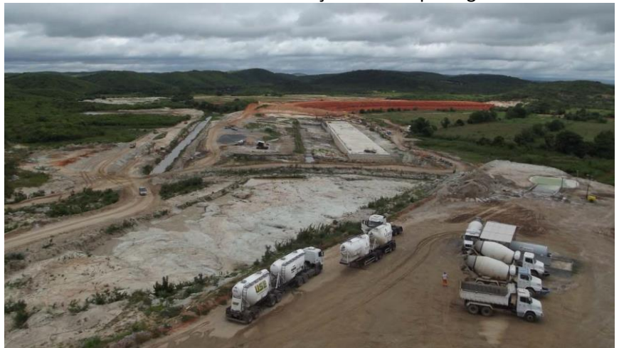
WBS 1113 - Reservatório Porcos – Vista parcial das atividades na área do Vertedouro.
