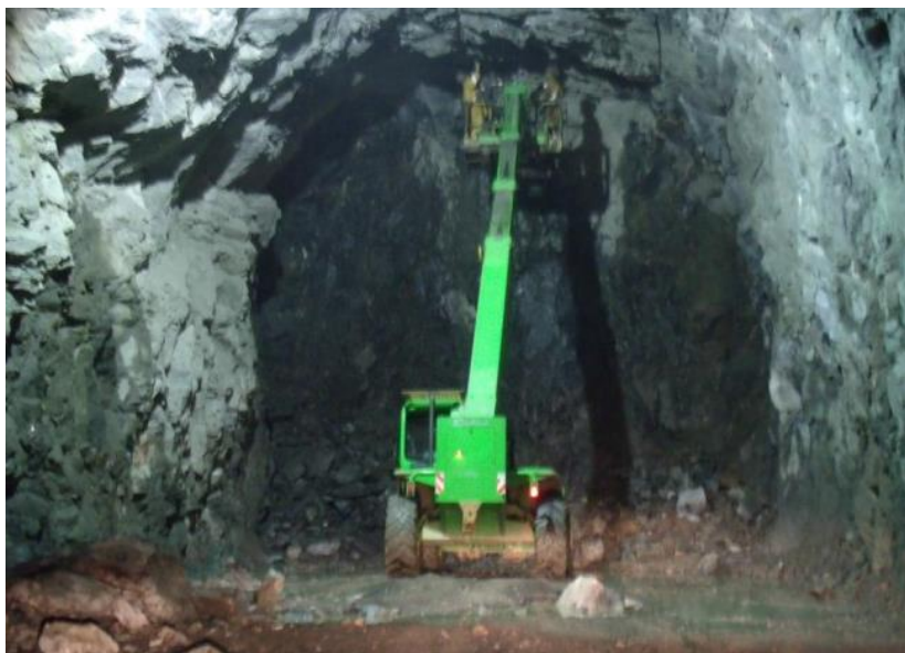
Túnel Cuncas I: Emboque Cuncas I.
