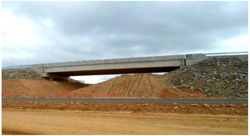
WBS 1505 – Ponte BR-428
