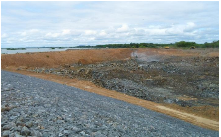
WBS 10204 – Emboque do canal de captação
