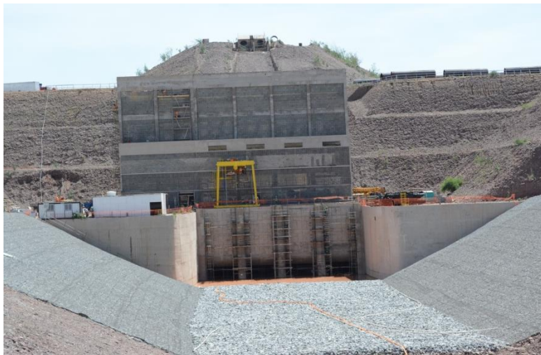
EBV-1: Vista frontal da primeira estação de bombeamento do Eixo Leste
