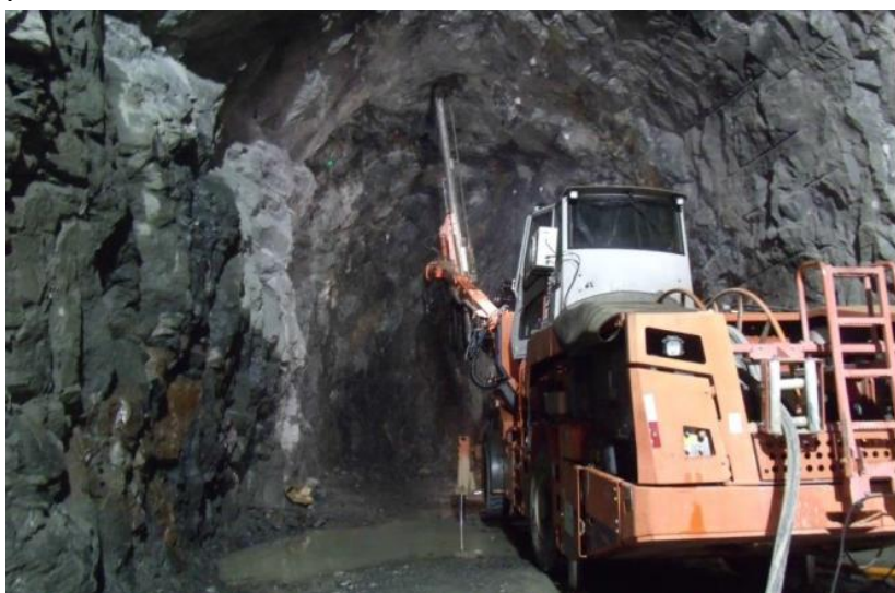
Túnel Cuncas I: Emboque Cuncas I, execução da furação para tirantes.
