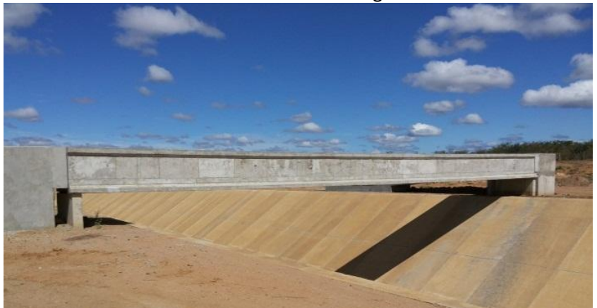
Passarela de pedestre sobre o canal concluída
