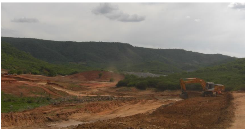
Reservatório Caiçara - Execução da escavação da fundação do barramento.
