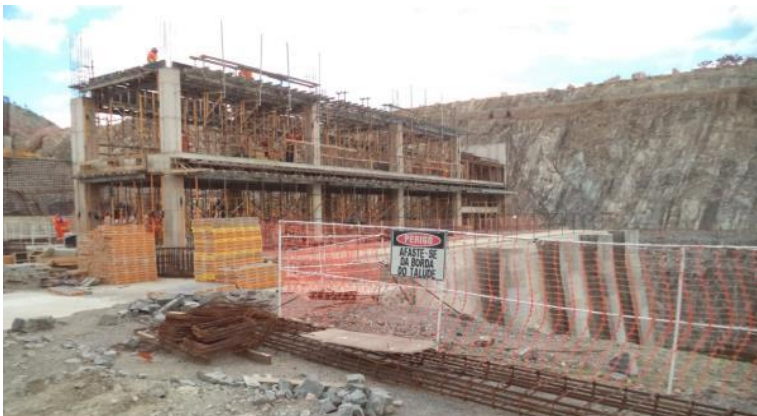
EBV-02 - Execução da montagem da forma e armação da laje do edifício de apoio.
