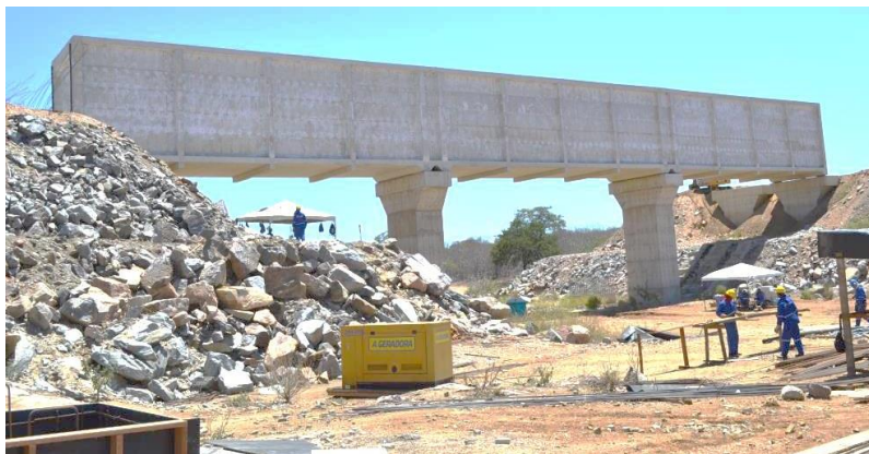
WBS 1306 - Aqueduto Saco da Serra.
