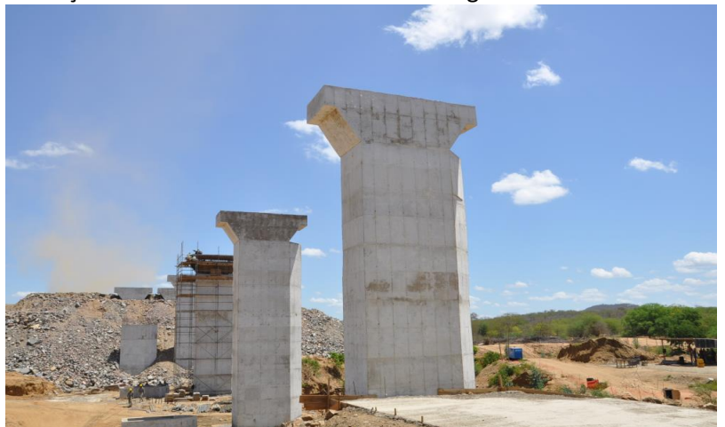
Aqueduto Salgueiro: Execução dos Pilares e Enrocamento.
