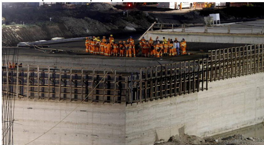
WBS 1113 - WBS 1113 - Reservatório Porcos - Execução de CCR no vertedouro.
