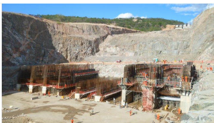
EBI3 – Armação e Concretagem da Estrutura de Deságue
