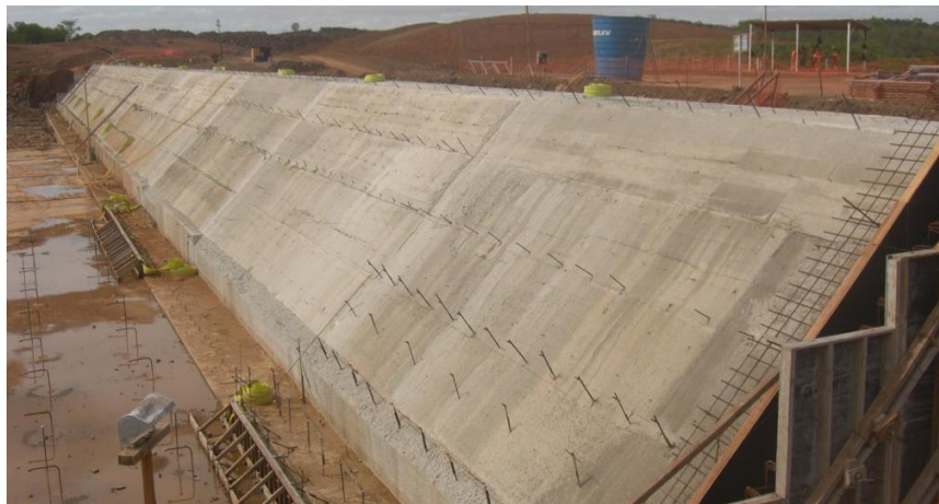
WBS 1111 - Reservatório Jati – Execução do Vertedouro.
