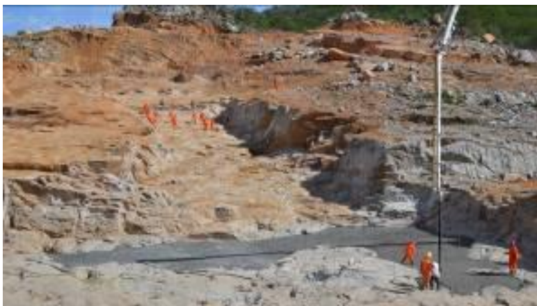
WBS 1109 – Reservatório Negreiros: Limpeza fina na ombreira esquerda e lançamento do concreto dental no barramento.
