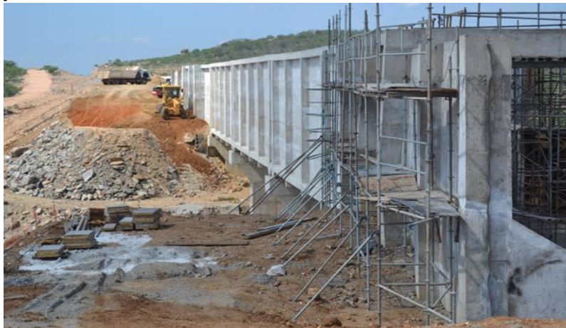
WBS 1305 - Aqueduto Logradouro: Vista geral da execução do reaterro à montante
