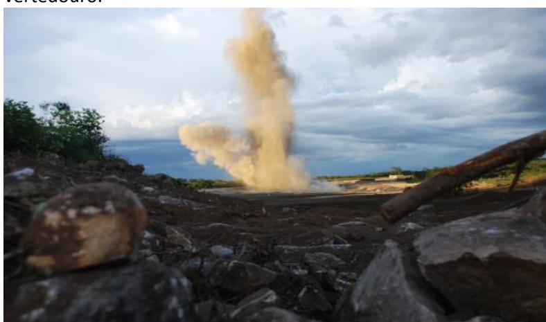
Túnel Monteiro - Detonação.
