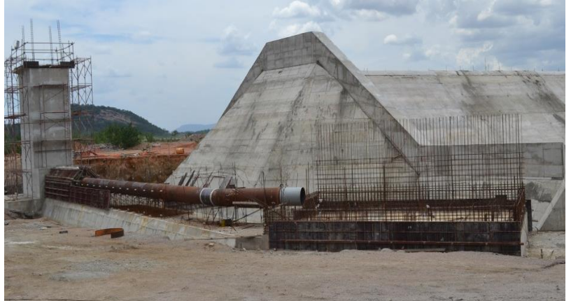
Tomada de uso difuso do Res. Serra do Livramento - Montagem da tubulação da adutora.
