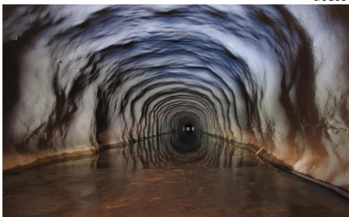
Túnel Cuncas II – Piso executado.
