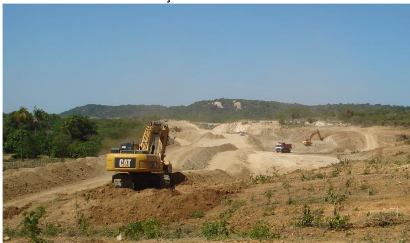
WBS 2226 - Segmento de canal - Escavação entre as estacas 9500 e 9520.
