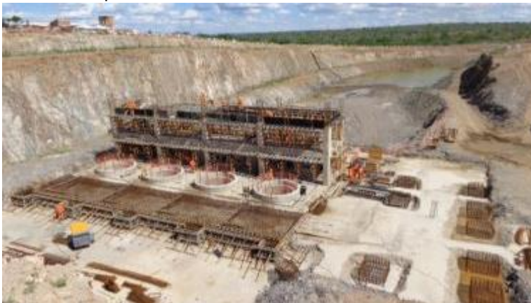
EBV-2: Concretagem do edifício da 2ª Estação de bombeamento do Eixo Leste.
