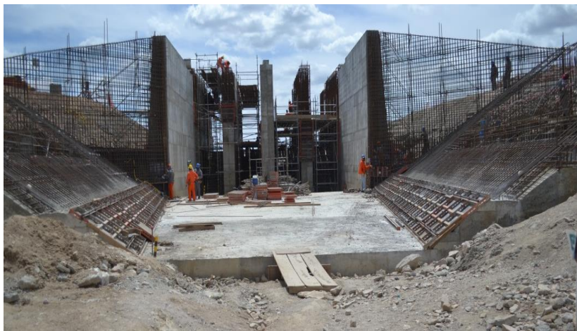
WBS 1255 – Estrutura de controle do Reservatório Tucutu – Vista Geral.
