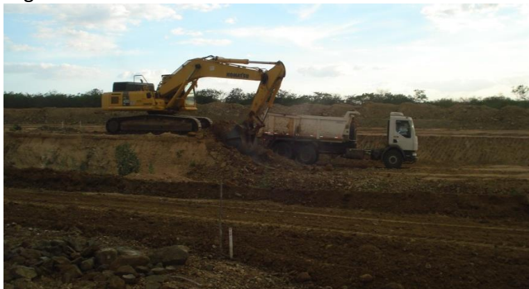
Reservatório Bagres - Execução da terraplenagem do maciço do barramento.
