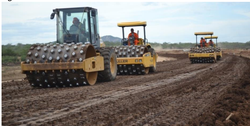
Reservatório Terra Nova – Execução de compactação do barramento.
