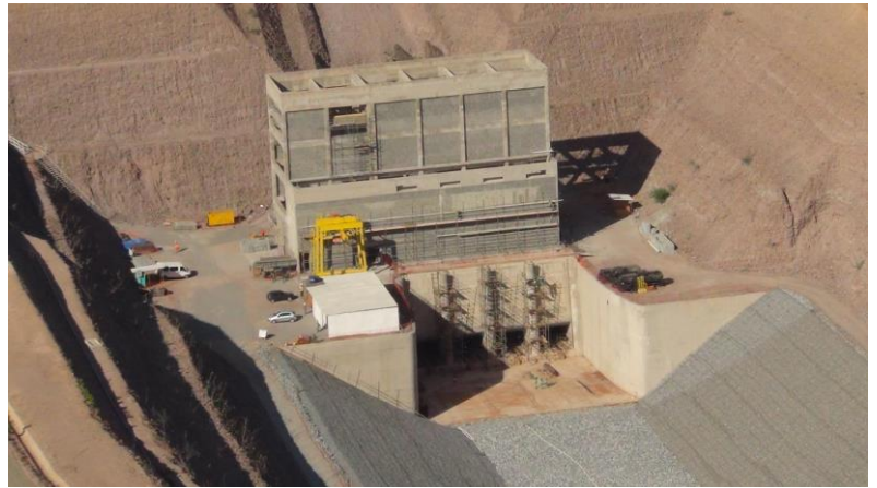
EBV-1: Execução da alvenaria, montagem da ponte rolante e da tubulação da (peça em Y) na estação de bombeamento.
