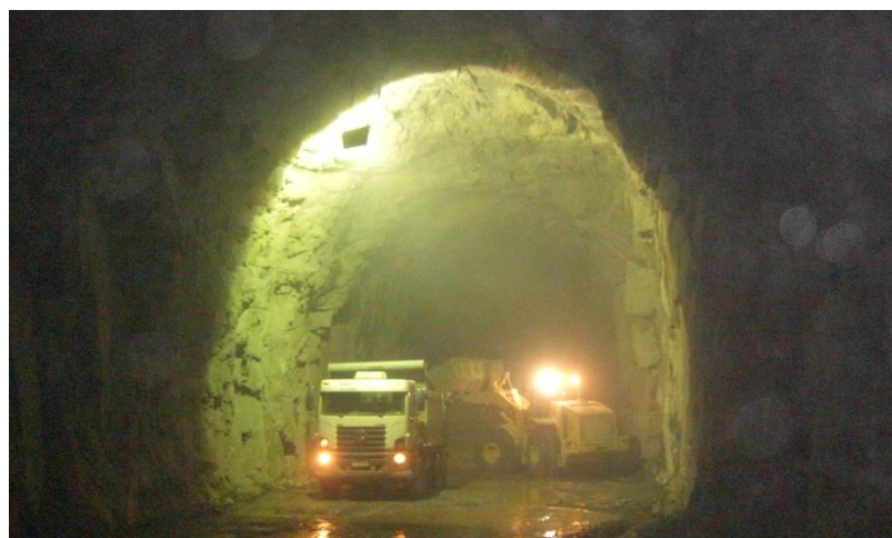
Túnel Cuncas I: em execução piso no trecho do desemboque
