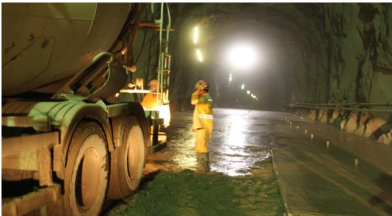
Túnel Cuncas I: em execução piso no trecho do desemboque
