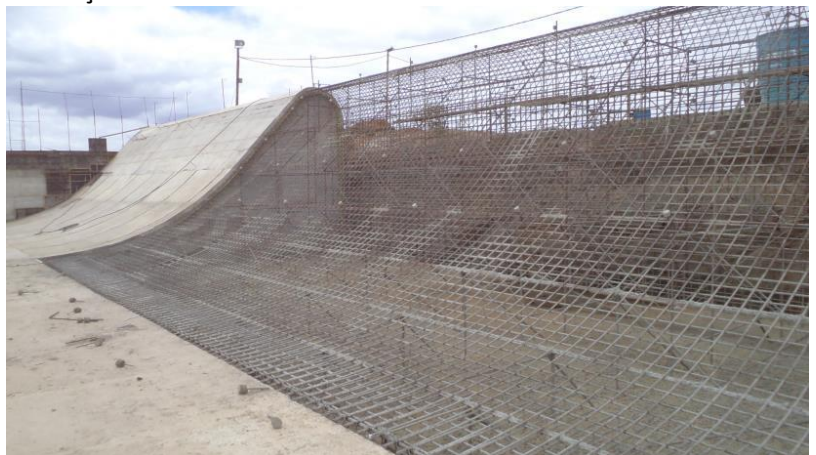
Execução do Barramento Reservatório Mangueira.
