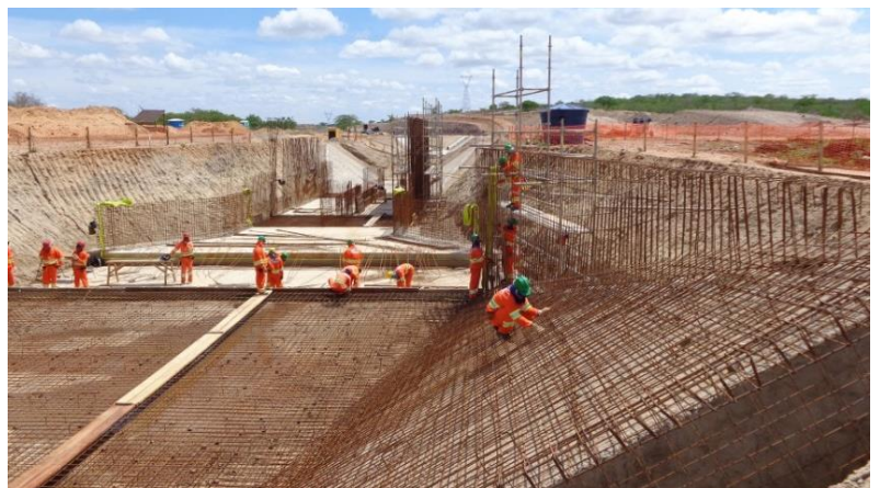
WBS 2255 - Estrutura de controle do reservatório de Areias - Execução da montagem da armação da estrutura.
