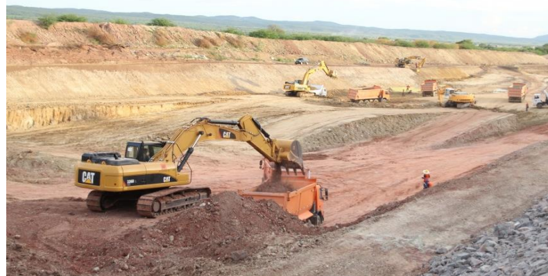
WBS 1234 - Escavação de canal anterior ao Túnel Cuncas I.
