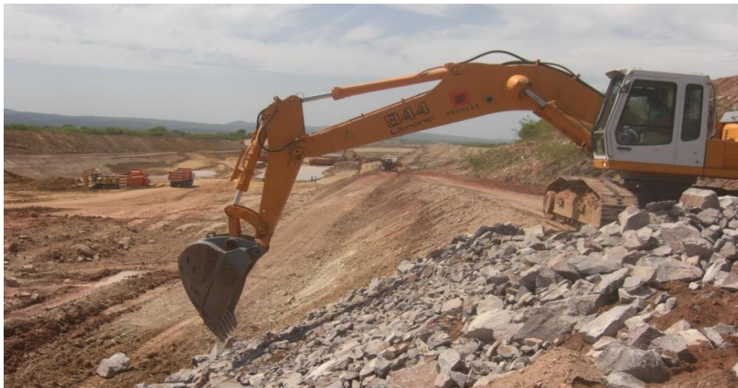
WBS 1234 - Segmento de canal - Execução de enrocamento de proteção.
