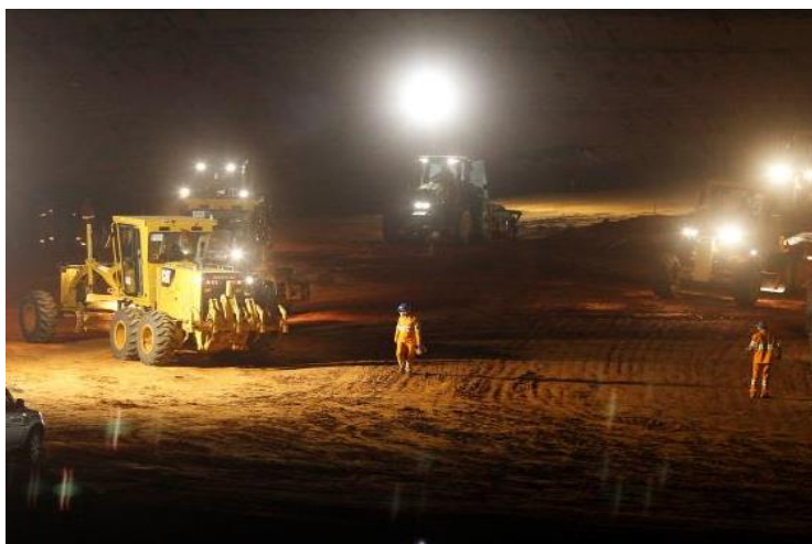
WBS 1113 - Reservatório Porcos – Trabalho Noturno
