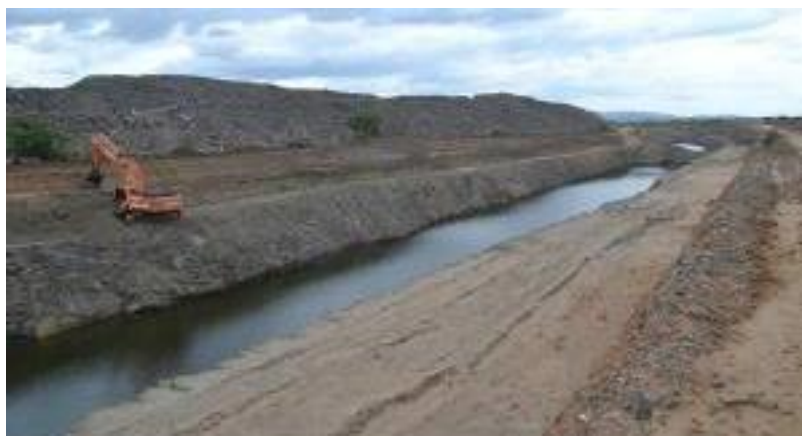
WBS 1212 – Segmento de Canal CN8: Escavação da berma.
