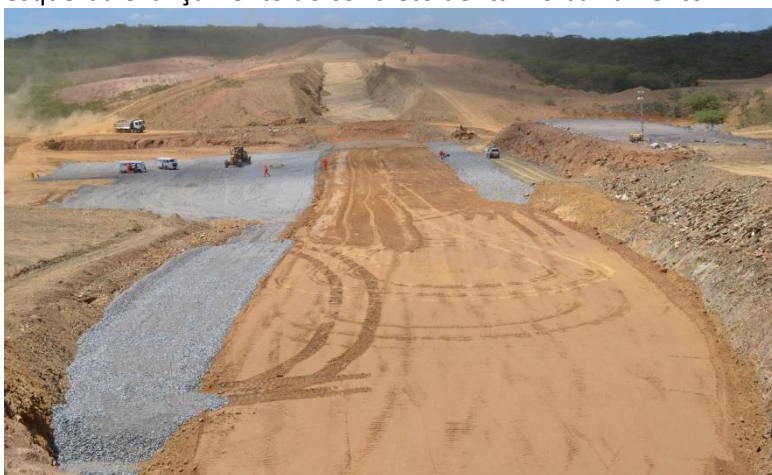
WBS 1110 – Reservatório Milagres: Vista geral da execução do filtro e núcleo argiloso
