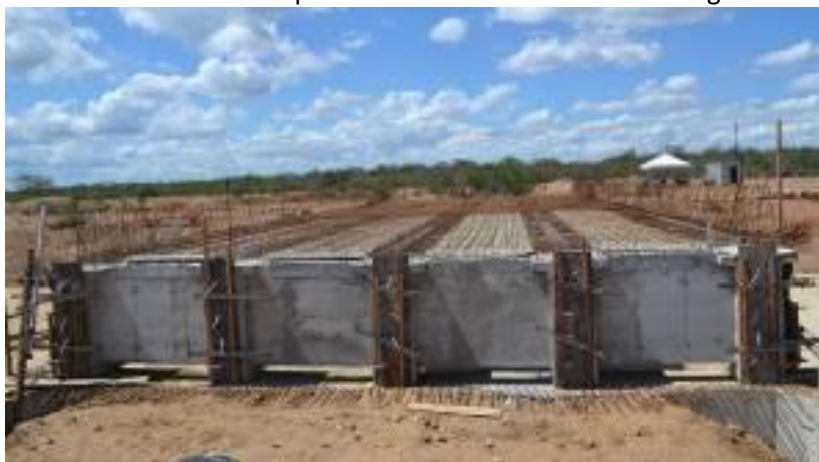
WBS 1506 - Ponte Tipo-I E. 987: Montagem de Cimbramento para vigas.
