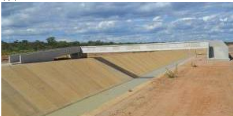
WBS 1145 – Passarela Tipo I E. 1555: Obra concluída. Vista geral.
