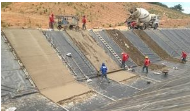
Concreto de Canal Segmento 2217
