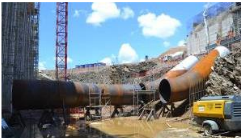
EBI-1 Montagem da tubulação de recalque.
