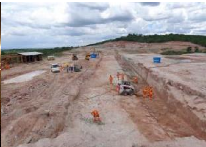
WBS 1115 - Reservatório. Cipó - escavação do vertedouro.
