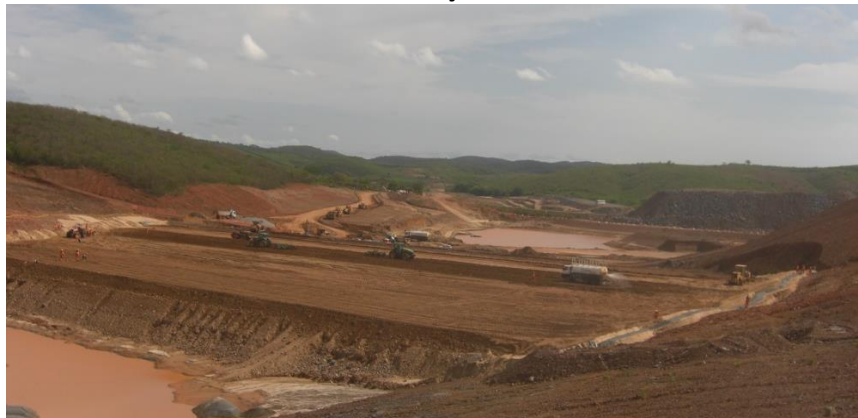
WBS 1111 - Reservatório Jati – Execução do espaldar de jusante e filtro horizontal (barramento principal).
