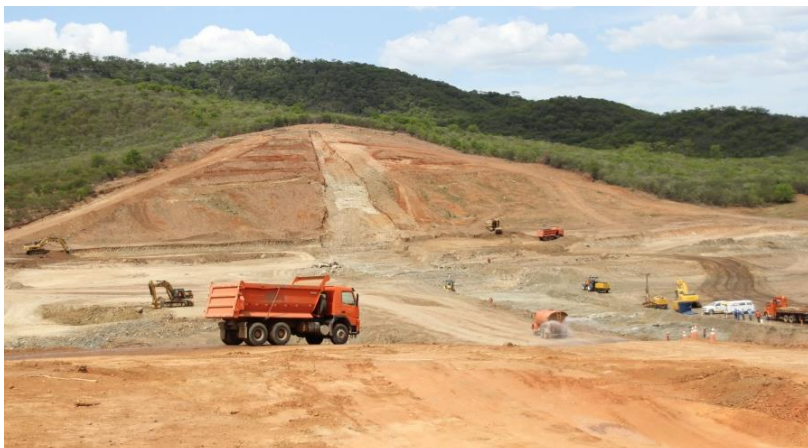
Reservatório Boa Vista - Em execução escavação do barramento.
