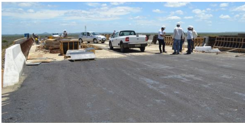
WBS 1505 – Ponte BR-428: Concretagem do guarda-corpo.
