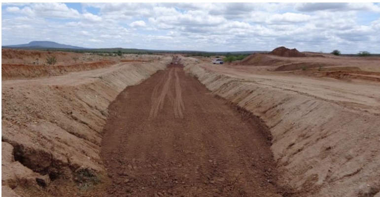
Reservatório Mandantes - Execução do aterro compactado do cut-off.
