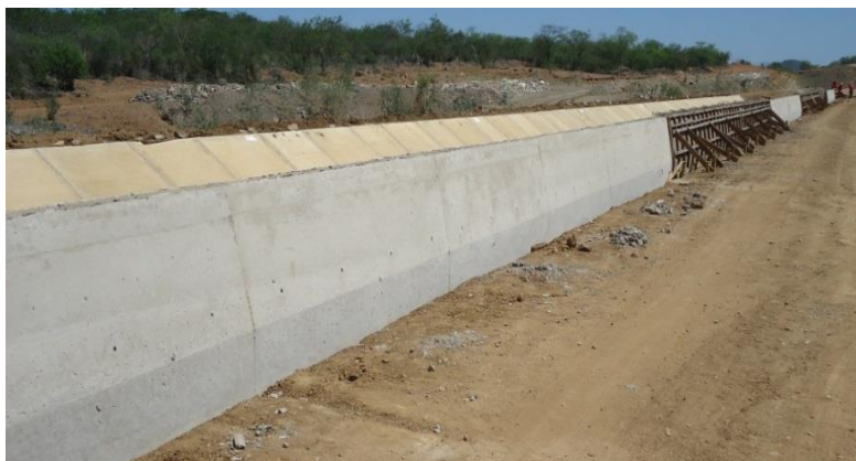
WBS-2212- Segmento de canal - Execução de muretas no segmento de canal
