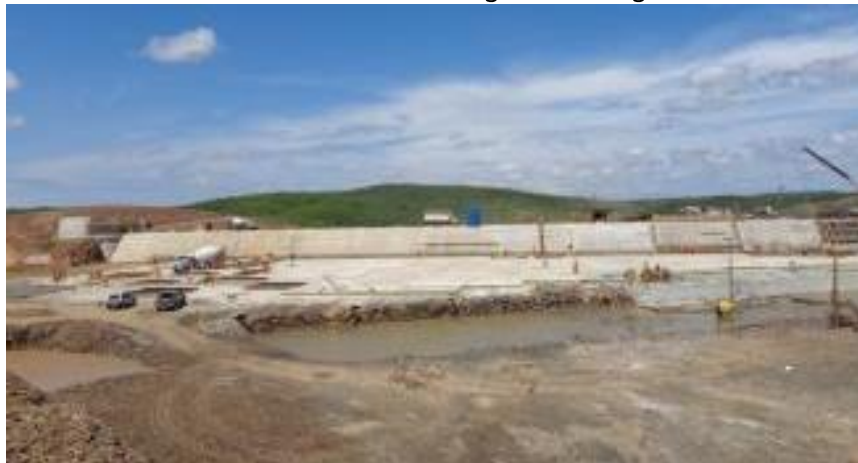
WBS 1111 - Reservatório Jati – Concretagem do vertedouro.
