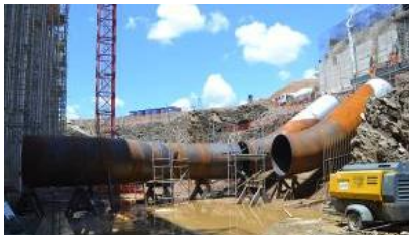
EBI-1 Montagem da tubulação de recalque.
