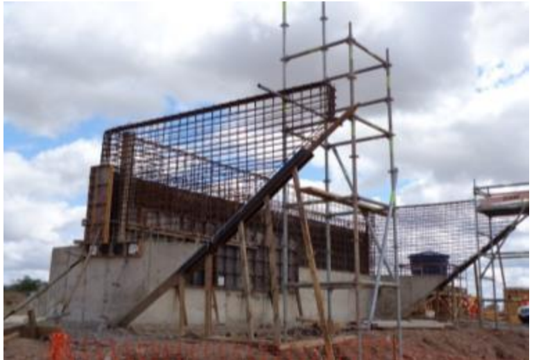
WBS 2506 - Ponte E-545+15,37: Execução da armadura da viga travessa nos pilares P2 e P4.
