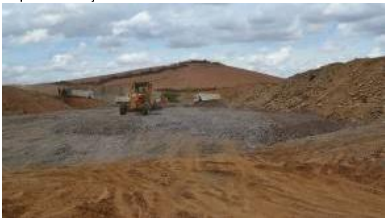
WBS 1110 – Reservatório Milagres: Vista geral do lançamento do filtro e colchão drenante no barramento.
