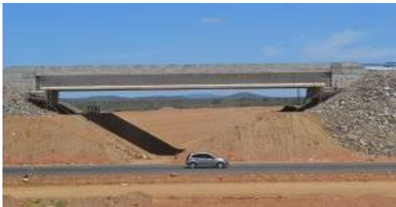
WBS 1505 – Ponte BR-428: Vista geral da ponte, aterro do segmento de canal WBS 1205.
