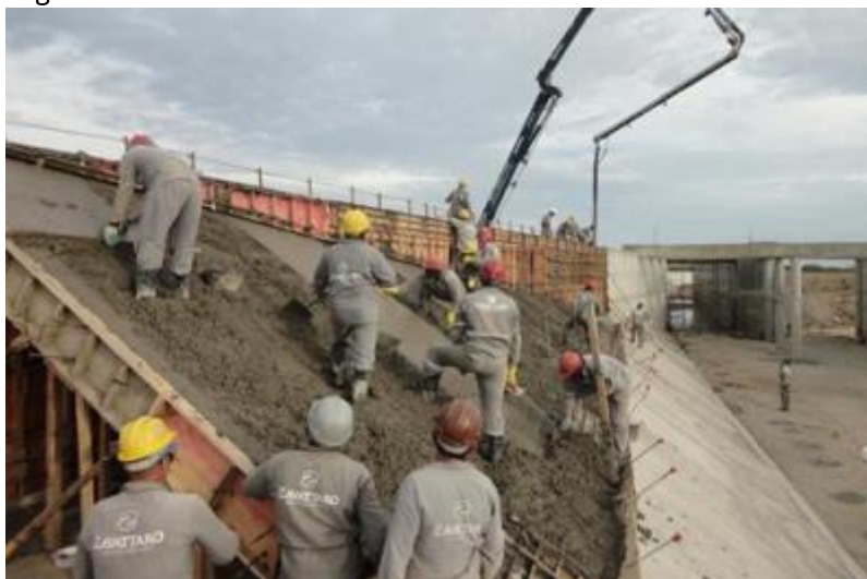
WBS 1307 – Aqueduto Mari: Vista geral execução da transição à jusante..
