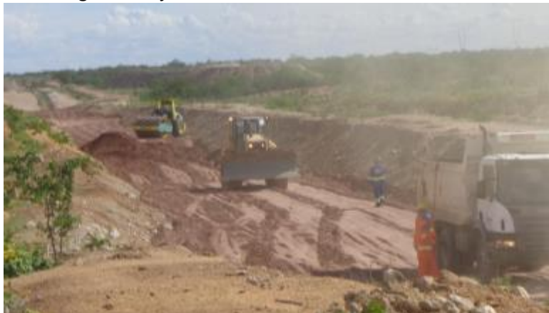
WBS 2107 - Execução da Barragem Salgueiro
