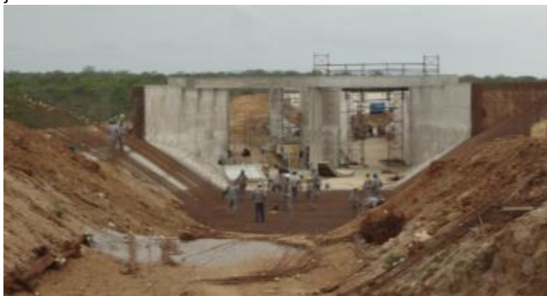
WBS 1305 - Aqueduto Logradouro: Vista geral da execução da transição à jusante.
