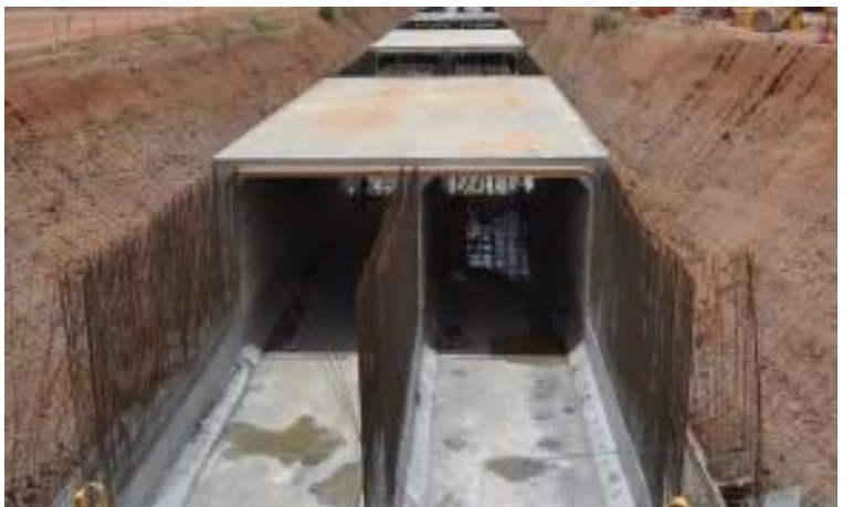
WBS 1365 – Galeria Penaforte: Execução da montagem de forma, armação e concretagem de módulos.
