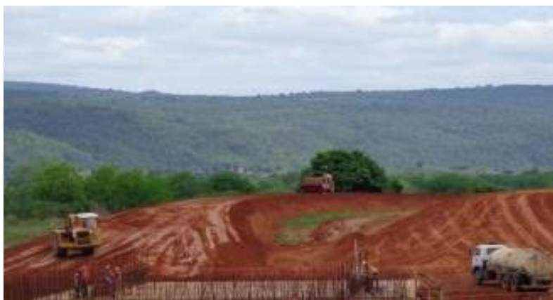
WBS 1232 - Segmento de canal - Execução de aterro.
