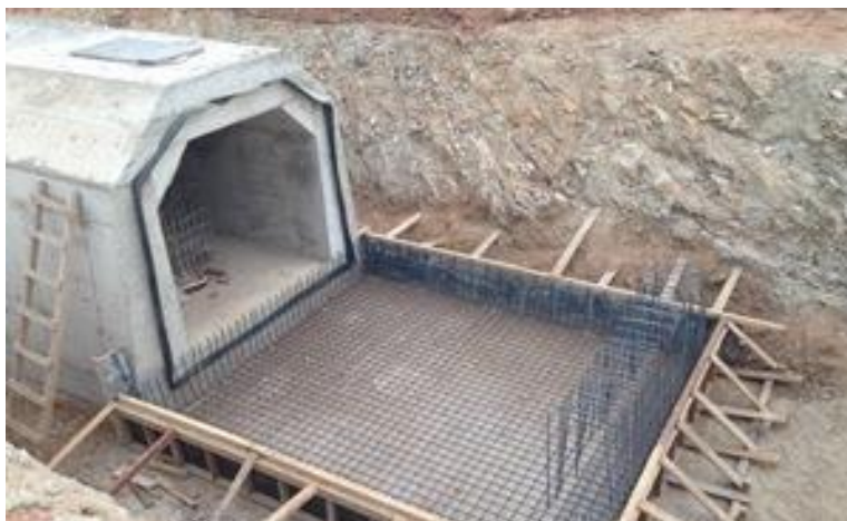
Tomada d'água Barragem Bagres
