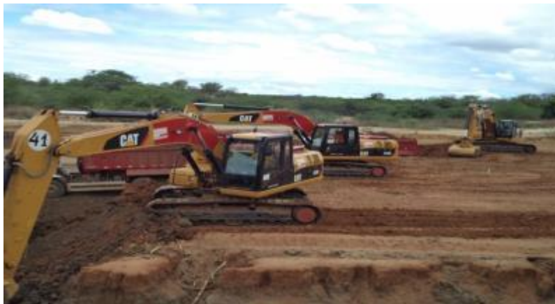
Escavação para fundação da Barragem Moxotó.
