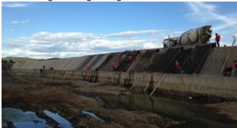
Vertedouro Cacimba Nova
