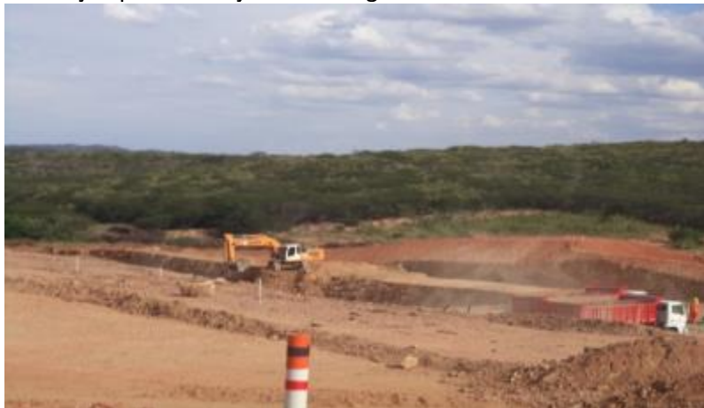
Escavação para fundação da Barragem Barro Branco.
