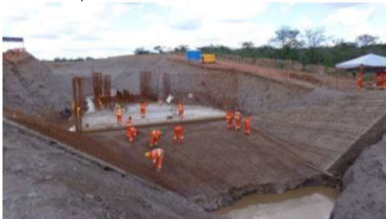
WBS 2256 - Estrutura de controle de Braúnas: Execução de concretagem da laje de fundo da estrutura de controle.
