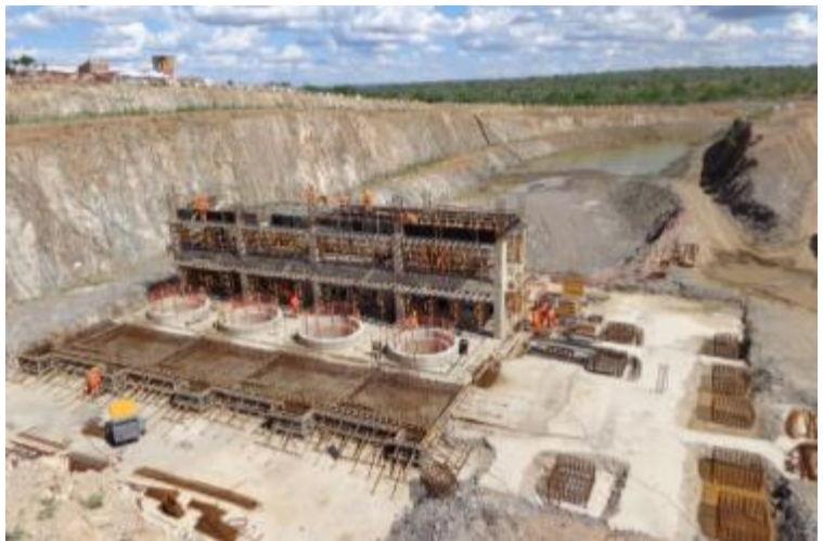
WBS 2620 - EBV-2: Concretagem do edifício da 2ª Estação de bombeamento do Eixo Leste.
