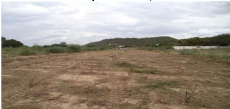
WBS 2227 - Segmento de canal após Túnel Monteiro, em execução Supressão vegetal.
