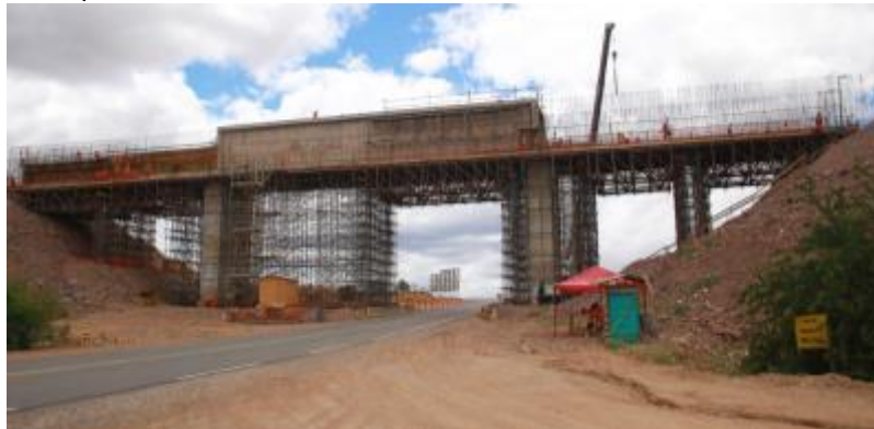
WBS 2304 - Aqueduto BR-316: Armadura e concretagem das paredes.
