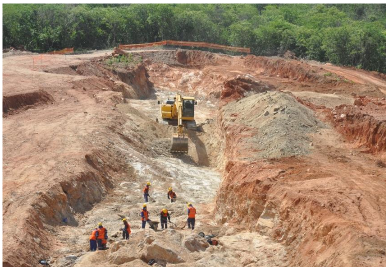
Reservatório Caiçara - Execução da escavação.
