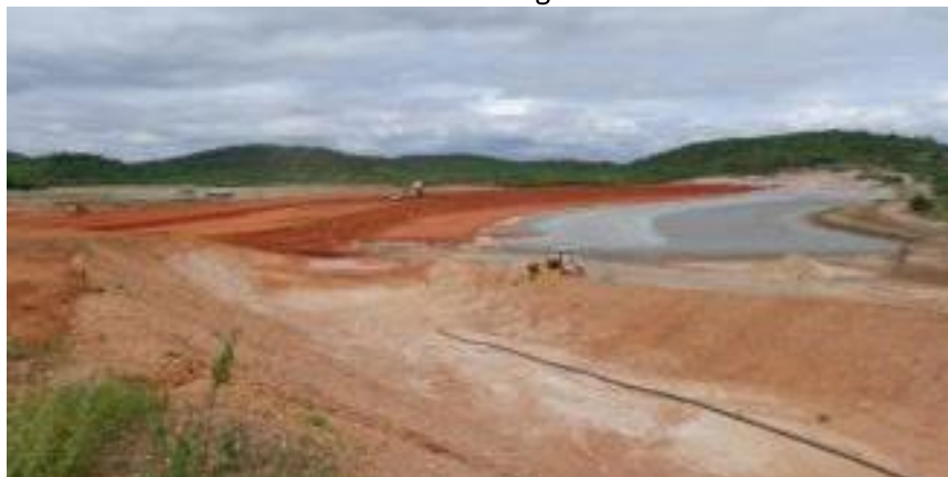
WBS 1113 - Reservatório Porcos – Barramento em execução de filtro horizontal e aterro entre estacas 20 e 41.
