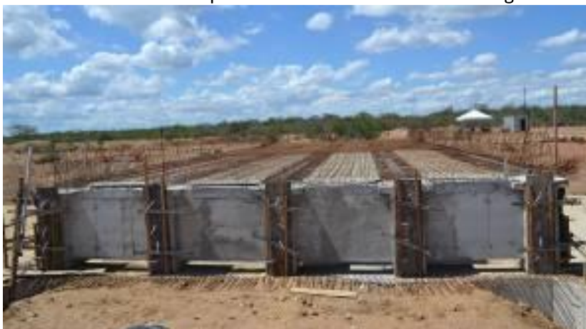
WBS 1506 - Ponte Tipo-I E. 987: Montagem de Cimbramento para vigas.
