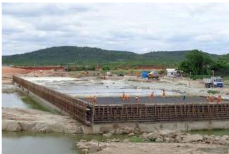
WBS 1113 - Reservatório Porcos – Concretagem da laje do vertedouro.
