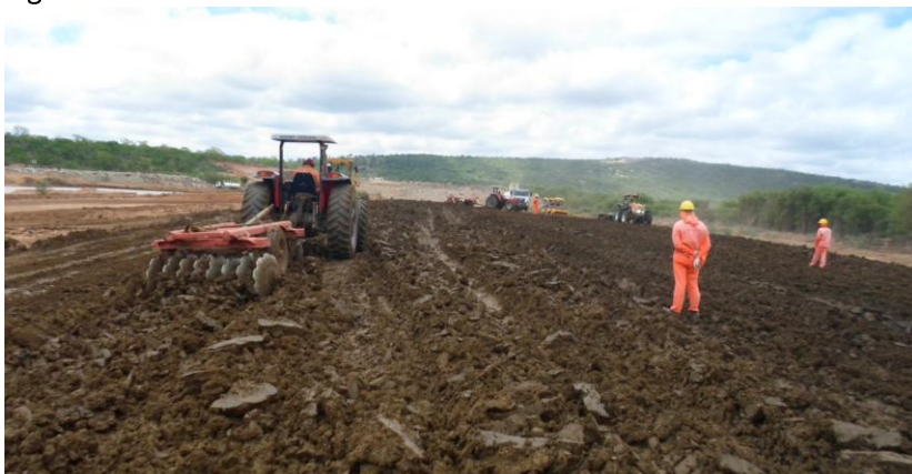
WBS 1106 - Reservatório Terra Nova: execução do núcleo do barramento.
