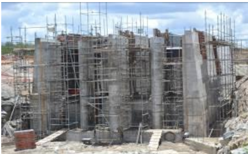
WBS 1255 – Estrutura de Controle Tucutu: Vista geral à montante.
