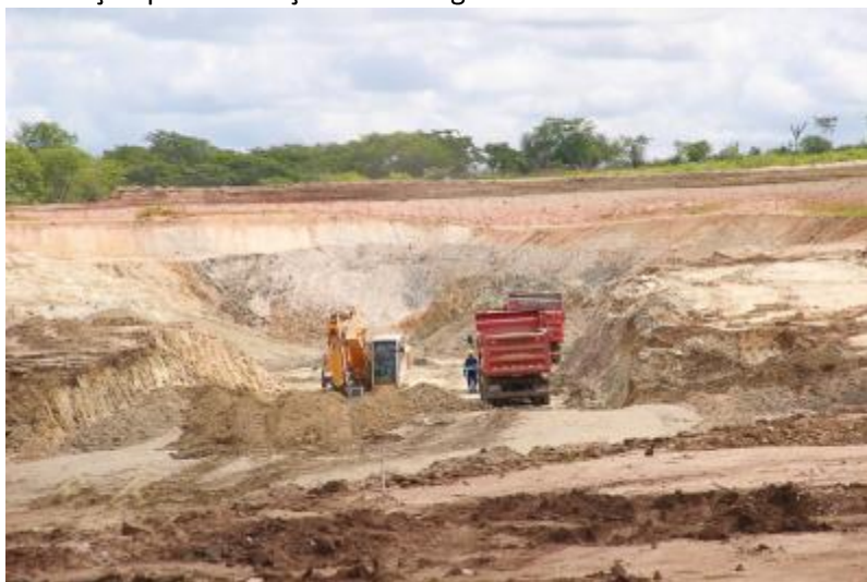
Túnel Monteiro - Escavação do o emboque.
