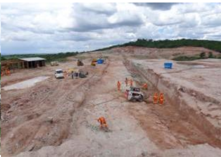
WBS 1115 - Reservatório. Cipó - escavação do vertedouro.
