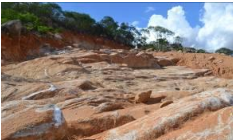
WBS 1109 – Reservatório Negreiros: Vista da limpeza fina na ombreira direita.
