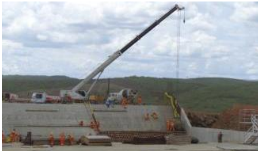
WBS 1111 - Reservatório Jati – Concretagem do creager do vertedouro.
