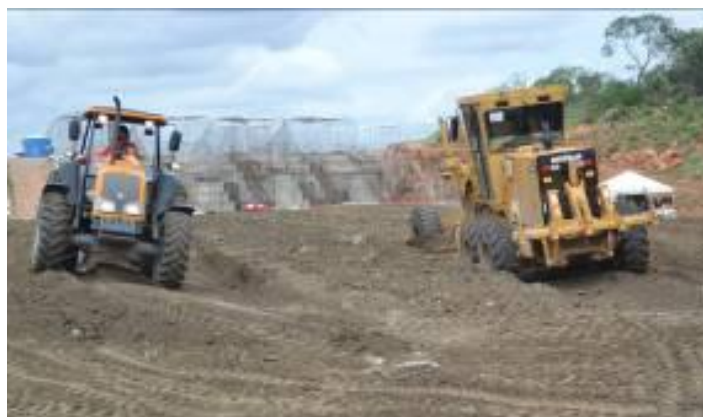
WBS 1630 – EBI-3: Execução do aterro compactado do forebay de montante.
