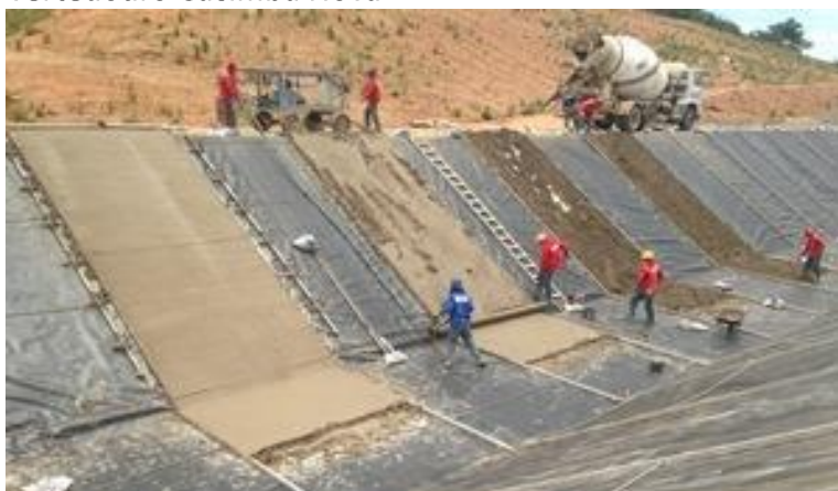
Concreto de Canal Segmento 2217
