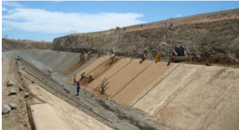
WBS 2206 - Segmento de canal entre Reservatório Areias e EBV-2
