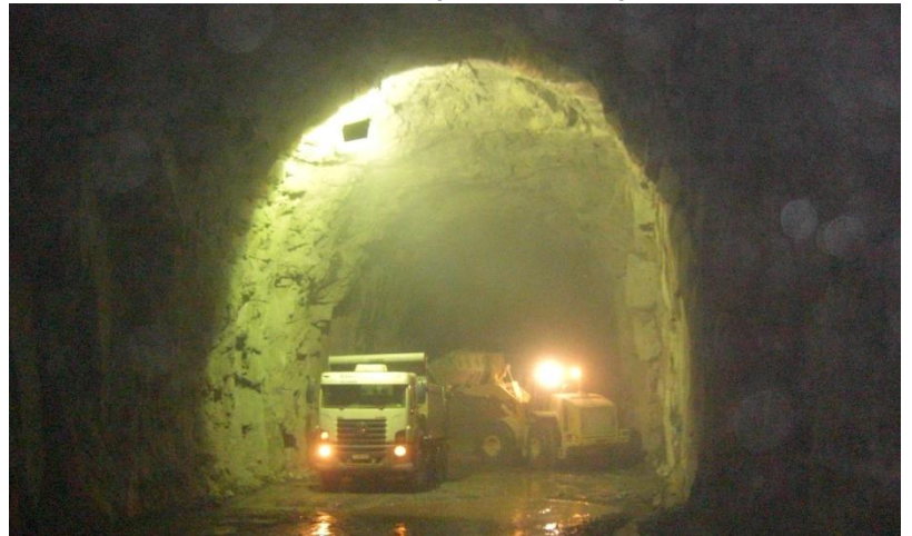
Túnel Cuncas I: frente de serviço de escavação.
