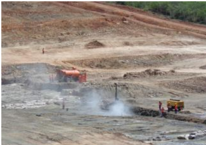
Reservatório Boa Vista – Execução de tratamento da fundação.
