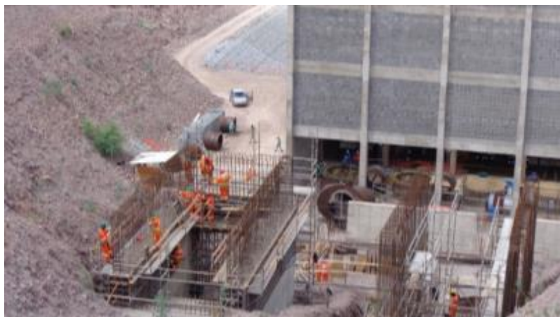
WBS 2610 – Execução dos blocos de ancoragem da tubulação de recalque da EBV-I.
