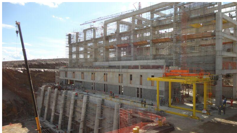
EBI-1: Vista geral da construção do edifício da casa de bombas.
