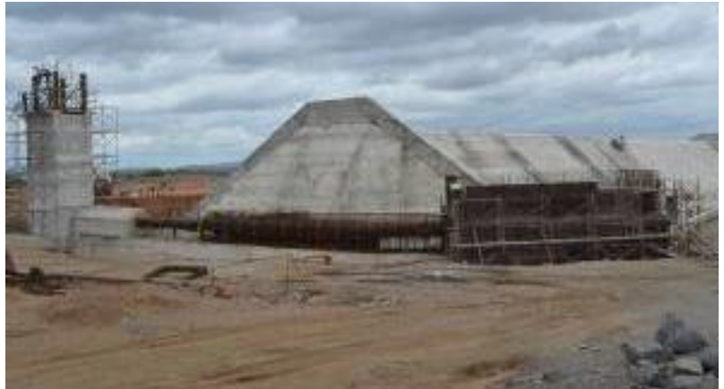
WBS 1157 – TUD em Serra do Livramento: Montagem de forma, armação e concreto de envelopamento da adutora.
