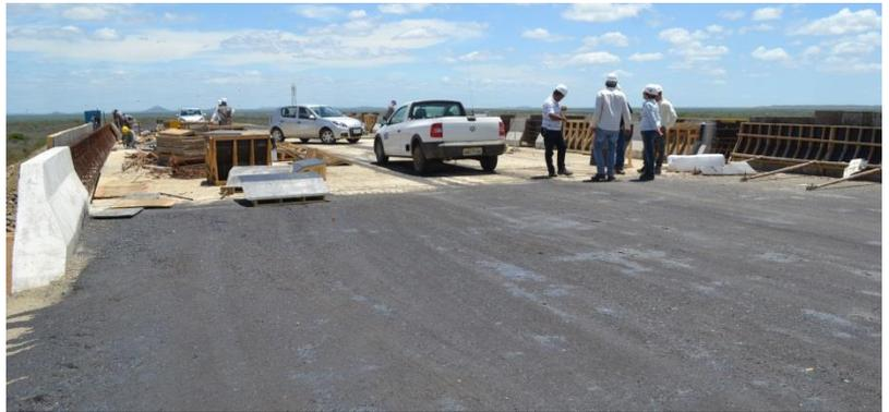
WBS 1505 - Ponte BR-428 - Concretagem do guarda-corpo.
