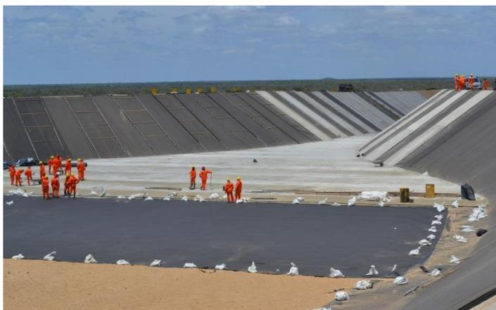
EBI-1 - Aplicação de geomembrana e concreto de proteção no forebay de jusante.
