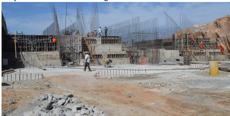
EBI-3 – Armação e concretagem da estrutura de deságue.
