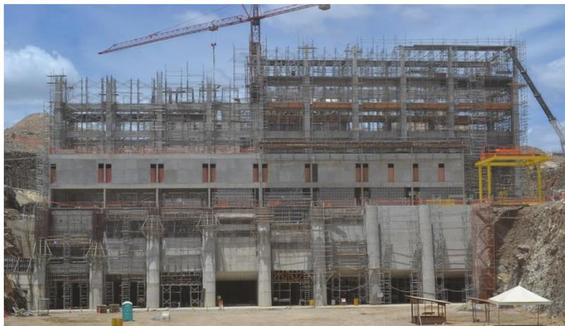
EBI 1 - Execução de alvenaria de elevação e elementos vazados na casa de bombas
