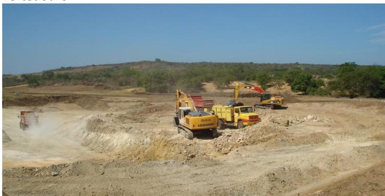
Túnel Monteiro - Escavação do emboque do túnel
