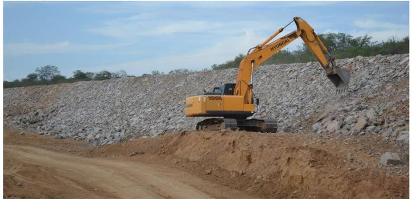
WBS 1215 - Segmento de canal - Enrocamento de proteção na estaca 3595.
