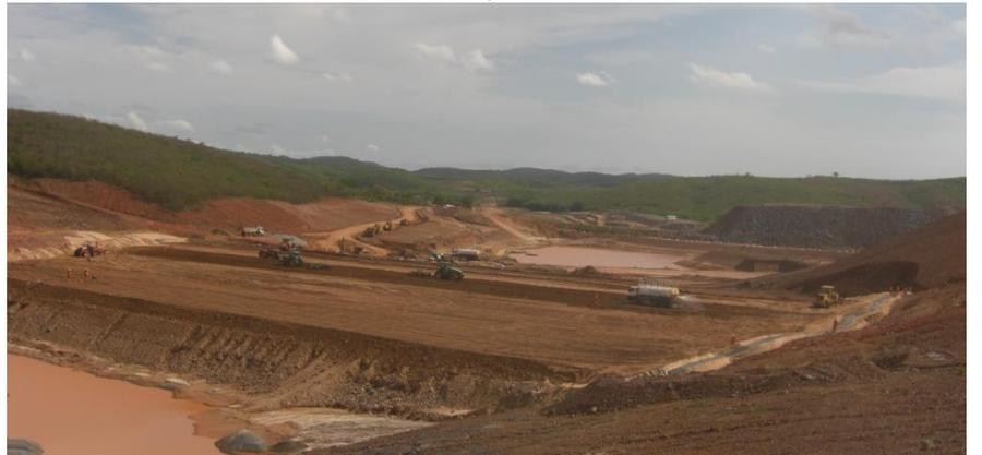
WBS 1111 - Reservatório Jati - Execução do espaldar de jusante e filtro horizontal (barramento principal).
