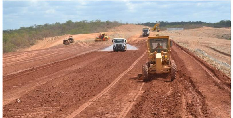
WBS 1219 - Segmento de canal: homogeneização e umectação de aterro na estaca 5014.
