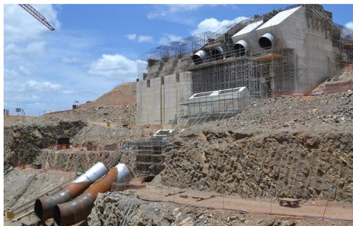
EBI-1 - Vista geral da estr. de deságue, bloco de ancoragem e condutos forçados.
