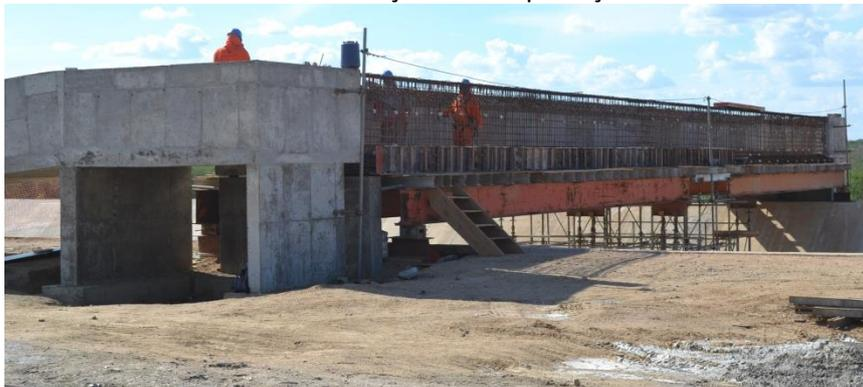
WBS 1556 - Passarela E-1418 - Vista da montagem da forma e armação da viga.
