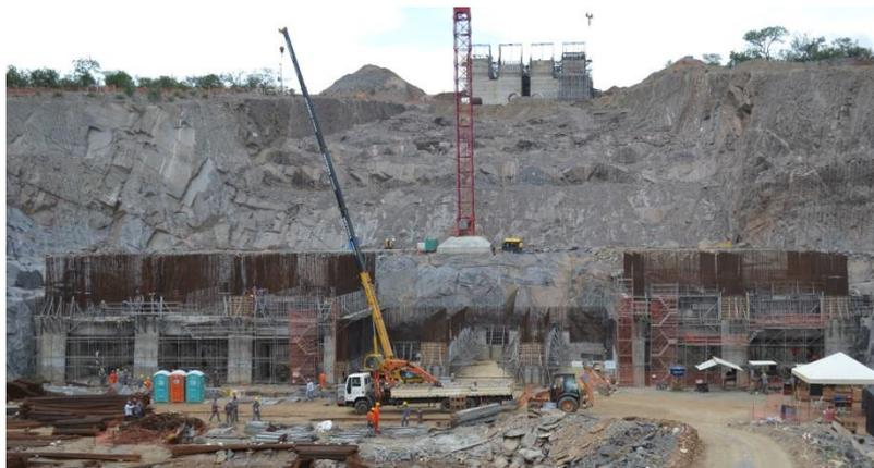
EBI 2 Vista geral da montagem de forma e armação do poço de sucção e da estrutura de deságue.
