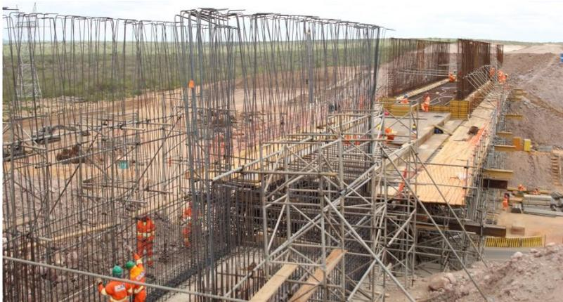
WBS 2304 - Aqueduto BR-316 - Execução da armadura da laje de fundo e das laterais.
