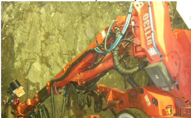
Túnel Cuncas I: em execução perfuração no sentido janela de acesso - emboque.
