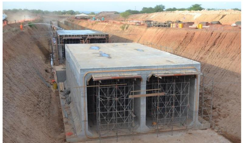
WBS 1365 - Galeria Milagres - Células concretadas e execução da cura do concreto
