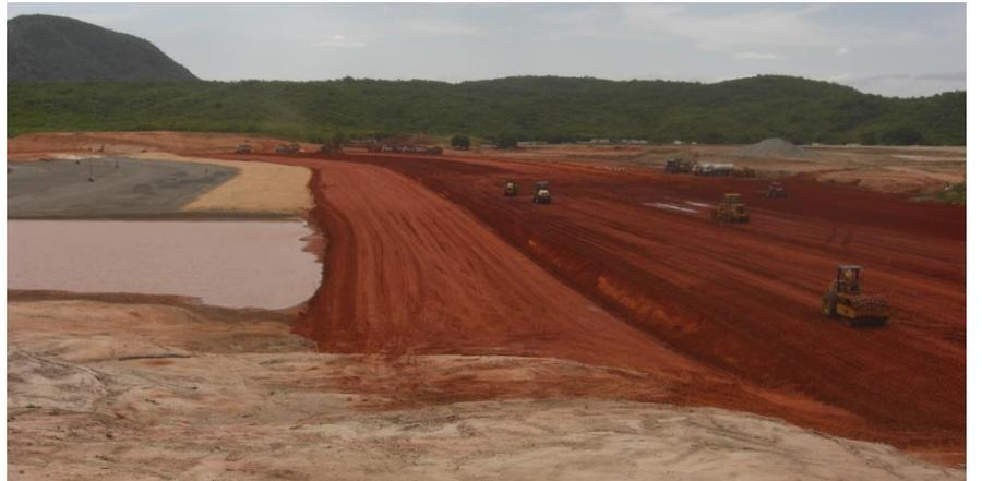
WBS 1113 - Reservatório Porcos - Execução do aterro compactado entre as estacas 20 e 42.
