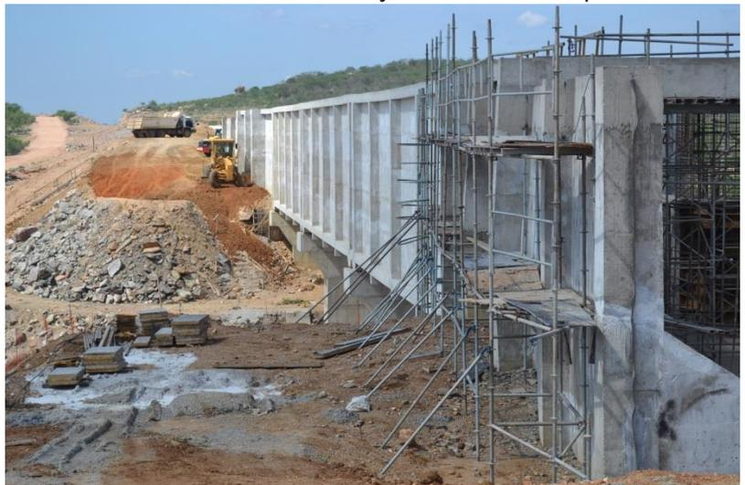
WBS 1305 - Aqueduto Logradouro - Vista geral da execução do reaterro à montante.
