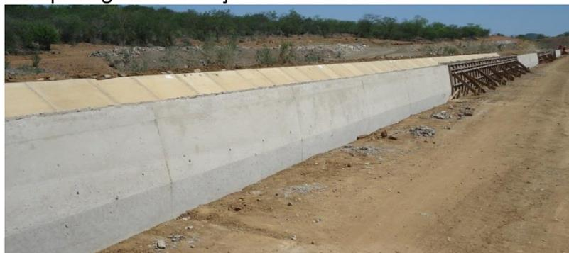
WBS-2212- Segmento de canal - Execução de muretas no segmento de canal
