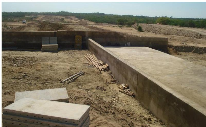
WBS 2110 - Reservatório Bagres - Soleira e muro de proteção do vertedouro.
