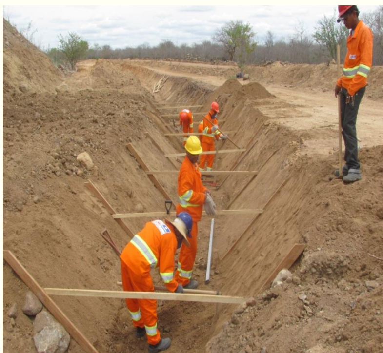
WBS 2205 execução de vala de drenagem D13 estaca 567
