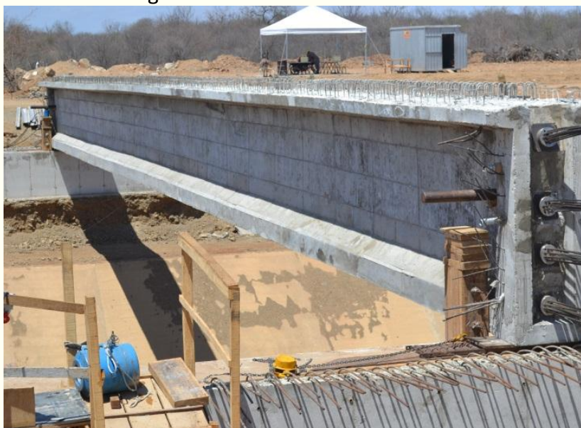
Vista lateral da execução das vigas da ponte tipo-III na E-987
