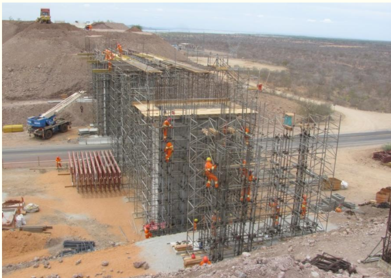
WBS 2505 Montagem de Cimbramento metálico do aqueduto
