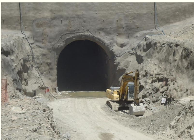
Emboque Túnel Cuncas II
