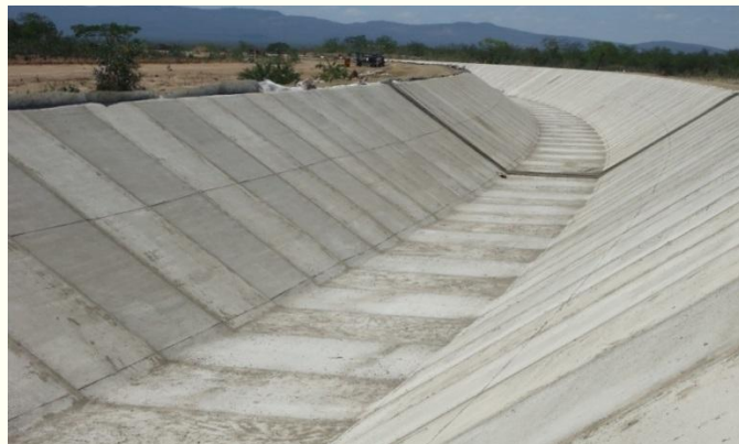
WBS-2212- Segmento de canal - Trecho de segmento de canal com placas de concreto concluídas recentemente
