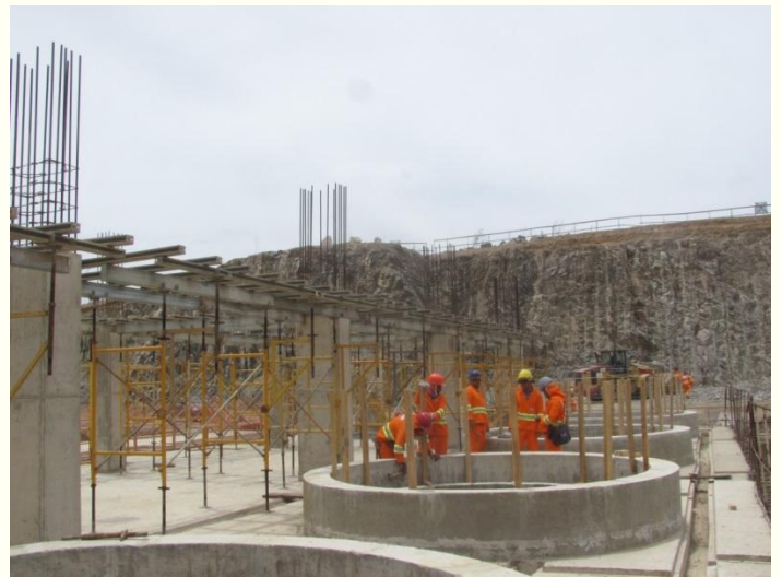
WBS 2620 Escoramento para colocação do fundo de vigas da EBV-2.
