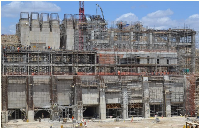
WBS 1610 EBI 1 Vista geral da estrutura de deságue e da execução da casa de bomba da EBI -1
