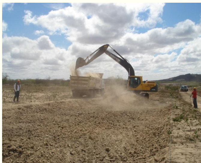
WBS - 2110 - Reservatório Bagres- Execução da escavação da fundação do barramento
