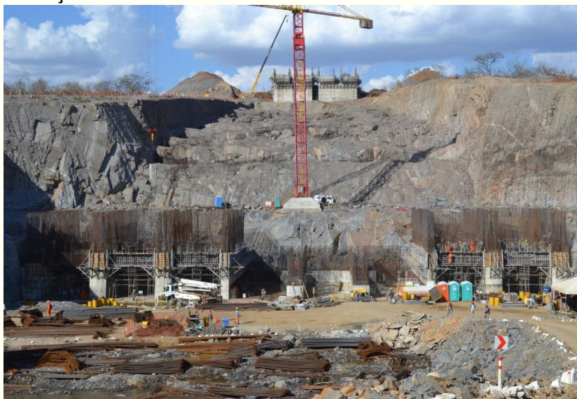
WBS 1620 EBI 2 Execução da montagem de forma e armação da estrutura de deságue da EBI-2
