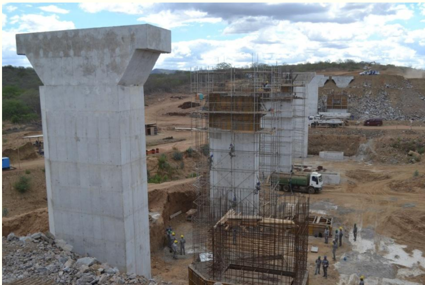
WBS 1309- Aqueduto Salgueiro -Execução da concretagem dos pilares do aqueduto Salgueiro.
