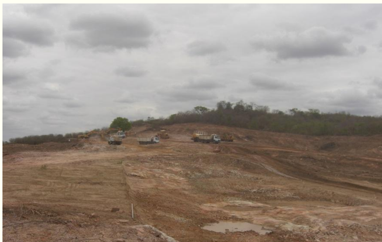
WBS 1115 Barragem Cipó - execução de cut off.
