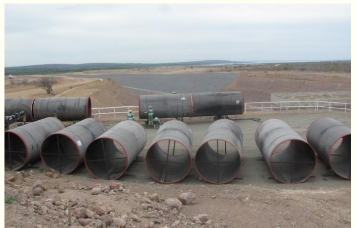
WBS 2610 - Solda dos tubos retos da primeira linha de recalque da tubulação.
