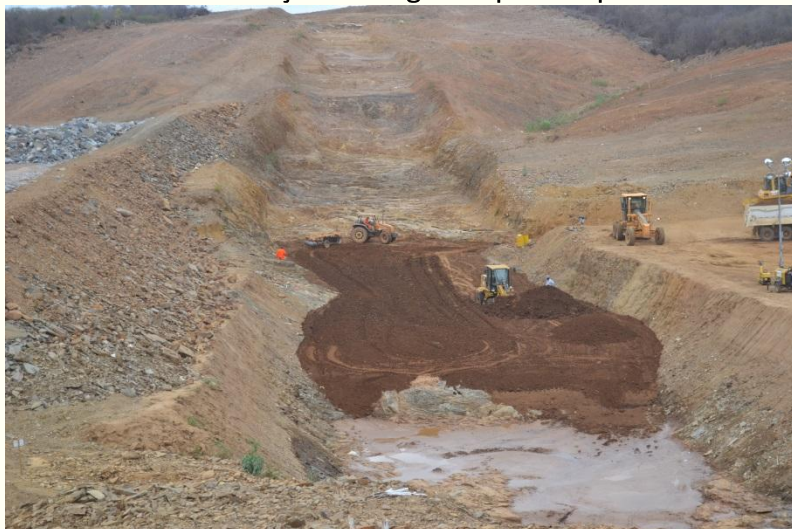
Lançamento de material argiloso no núcleo do barramento do reservatório Milagre
