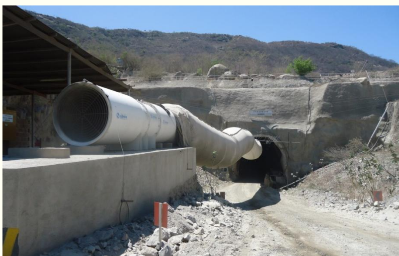
Desemboque Túnel Cuncas I
