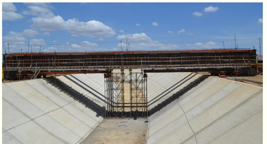
Vista frontal da execução da ponte tipo-III na E-732
