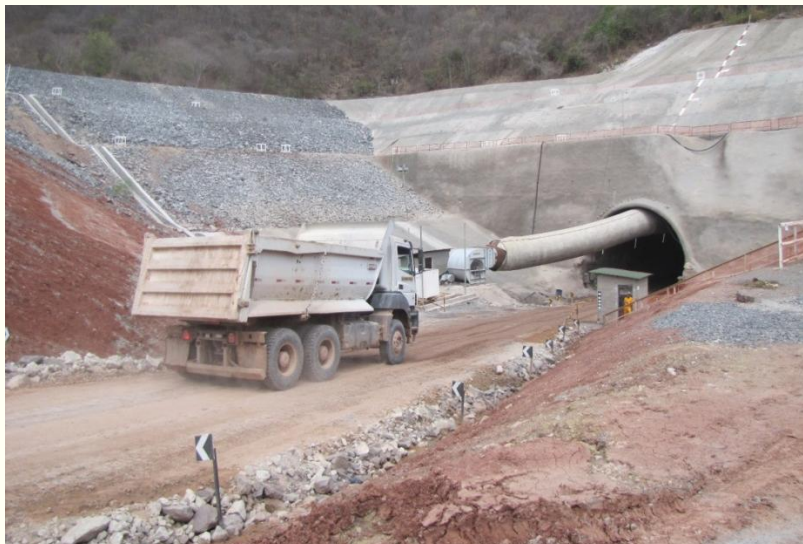
Emboque Túnel Cuncas I
