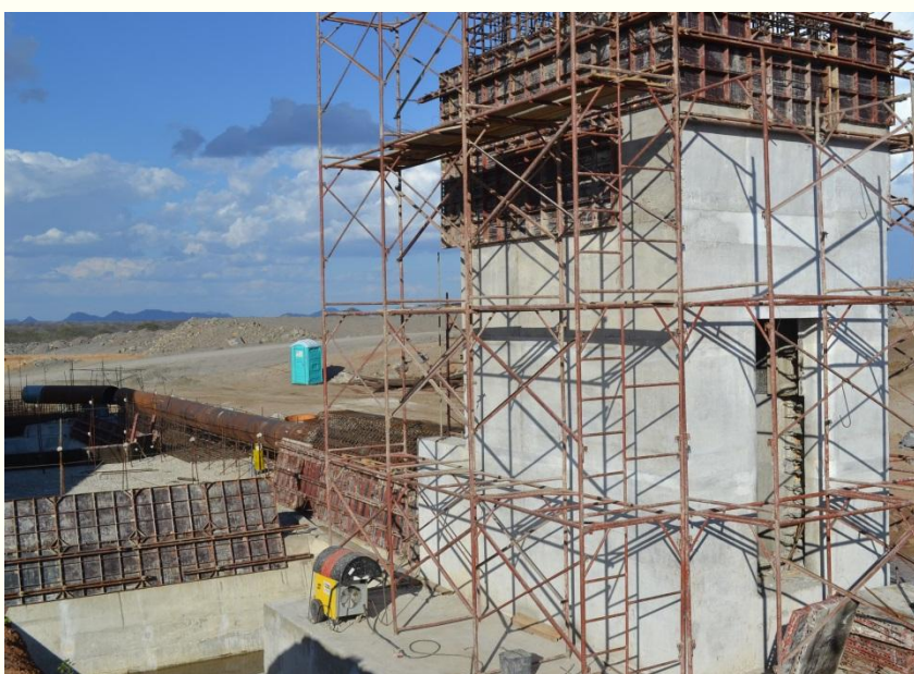
WBS 1107- Reservatório. Serra do Livramento-Execução da concretagem da tomada d'água do reservatório Serra do Livramento.
