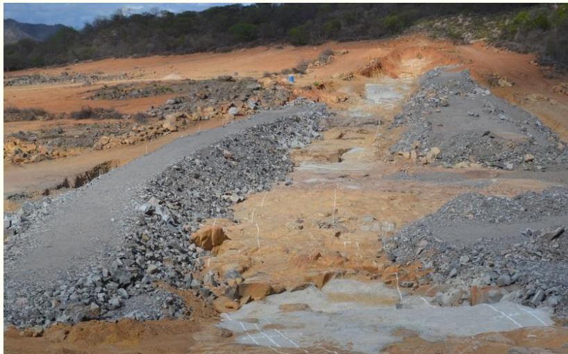
WBS 1109 - Reservatório Negreiros - Enrocamento de montante, jusante, e concreto dental no dique do reservatório Negreiros
