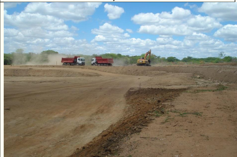
WBS 2410 - Escavação do emboque do Túnel Monteiro
