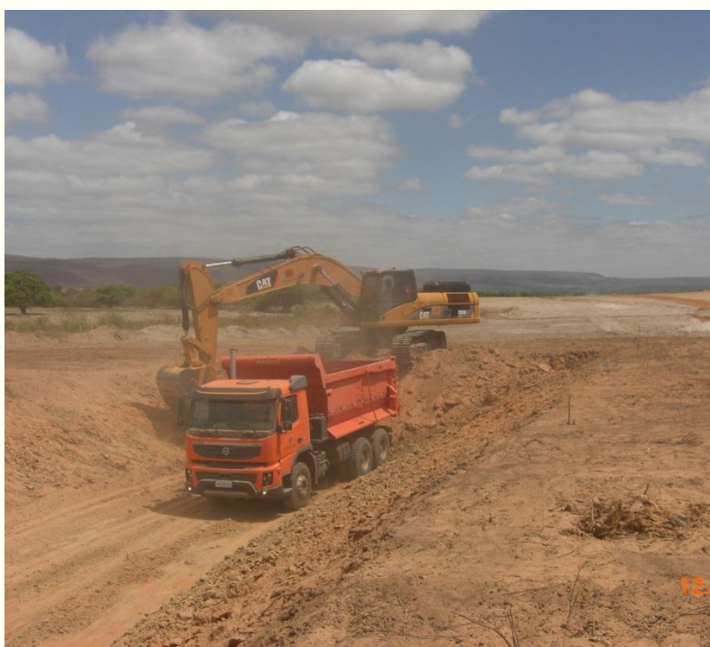
WBS 1233 - escavação estaca 70
