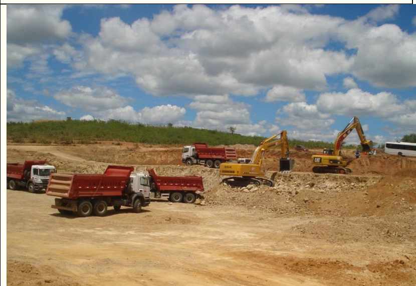
WBS 2115 - BARRAGEM BARRO BRANCO - Vista parcial do desmatamento na área do maciço.
