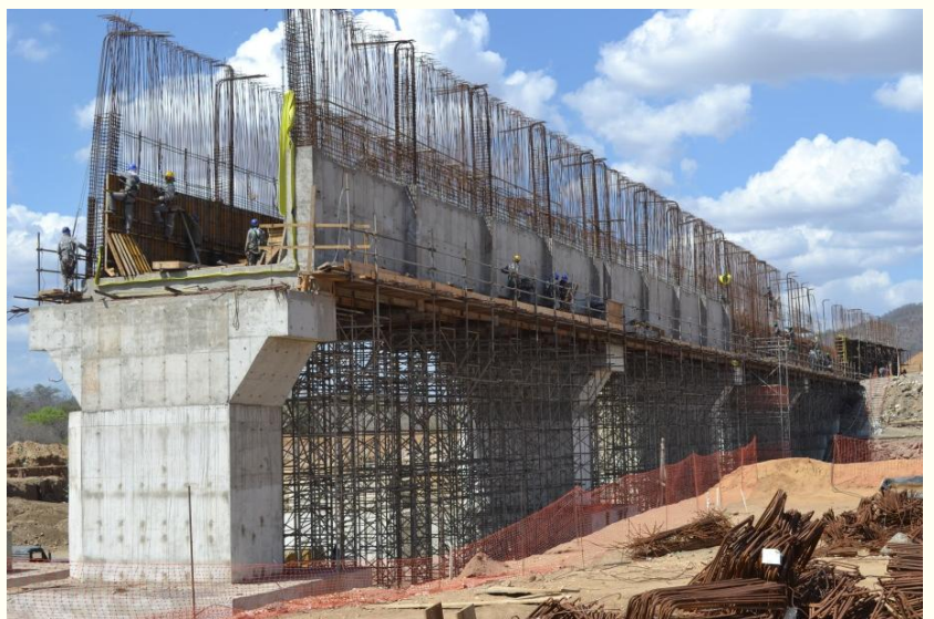
Vista lateral da concretagem das paredes dos módulos do aqueduto Mari.
