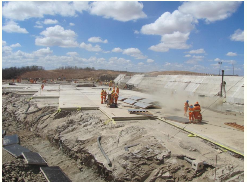
Vertedouro do Reservatório de Porcos
