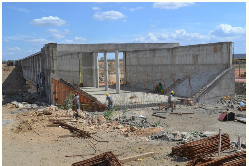
Vista Execução da concretagem da transição a jusante do aqueduto Terra Nova com o WBS-1211.
