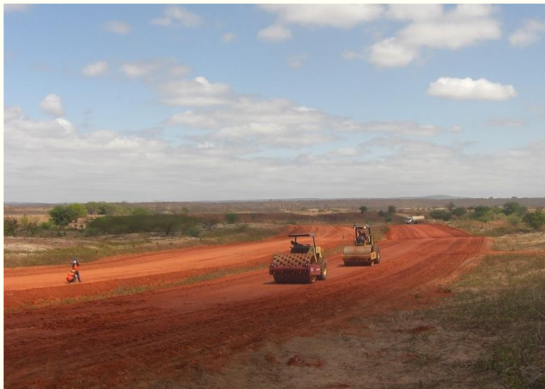
WBS-1232: execução de aterro compactado nos intervalos entre as estacas
