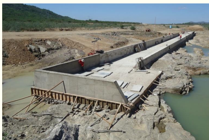
WBS-2109 -Reservatório Cacimba Nova- Vista geral a jusante do vertedouro
