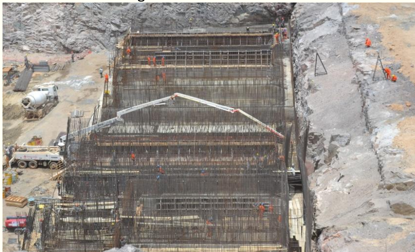
WBS 163 EBI-3 Vista lateral das montagens de forma e armação das paredes do poço de sucção da EBI-3
