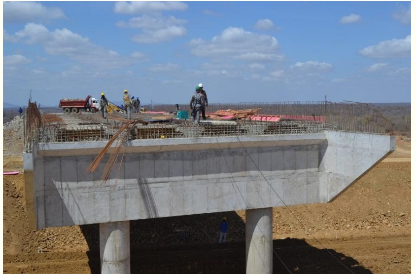
Execução da montagem de forma e armação da laje da ponte da BR-428
