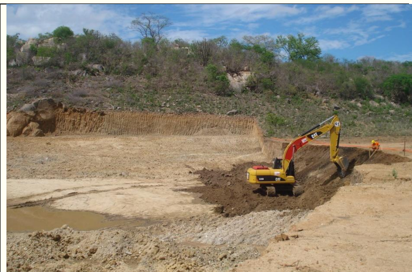
WBS 2112 - BARRAGEM MOXOTÓ - Escavação da fundação a partir da estaca 02.
