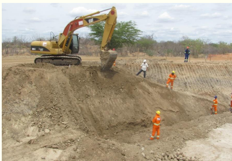
WBS 2255 Execução de aterro para paredes da estrutura de transição de entrada Controle de Areias
