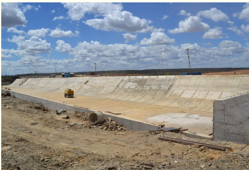
Executada a concretagem do vertedouro do reservatório Mangueira.
