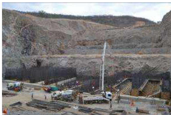
Execução da concretagem das paredes do poço de sucção da EBI-3.
