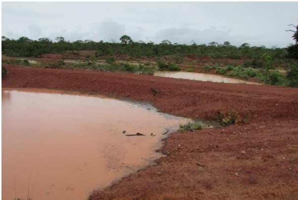
Foto 07 – Bacias de contenção de água de chuva construídas em sequência para armazenar o maior volume de enxurradas para abastecimento do lençol freático.
