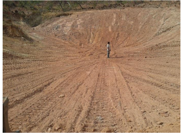
Foto 06 – Bacia de contenção de água de chuva pronta, construída na cabeceira do córrego das Lajes, para acúmulo de água pluvial.
