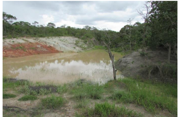
Foto 08 – Bacia de contenção de água de chuva construída na cabeceira do córrego das Lajes, armazenando água de chuva para aumentar a infiltração na microbacia.
