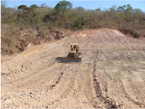
Foto 05 – Máquina usada para conformação e construção de bacia de contenção de água de chuva (barraginha) para reduzir o escoamento superficial.
