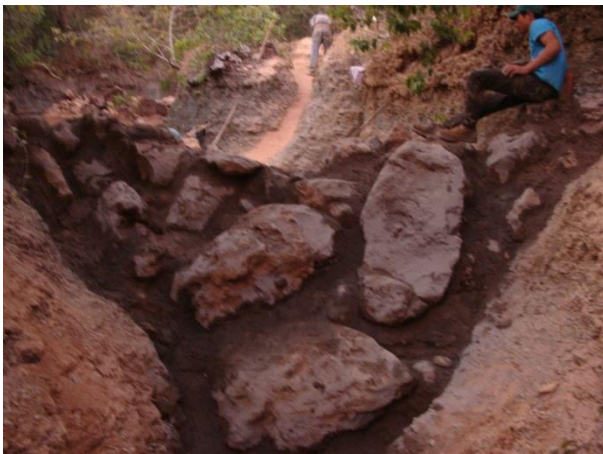
Foto 09 – Barramento de base zero construído para aumentar o potencial hídrico e conter sedimentos na bacia do Córrego das Lajes.
