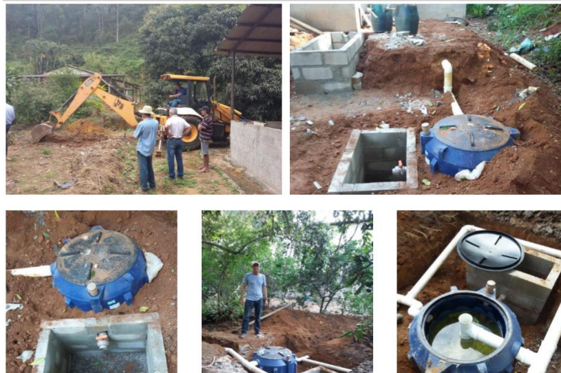
Figura 6: modelo de mini ETE utilizado no Projeto “Sanear águas é preservar vidas” Fonte: Prefeitura do Município de Domingos Martins, ES.
