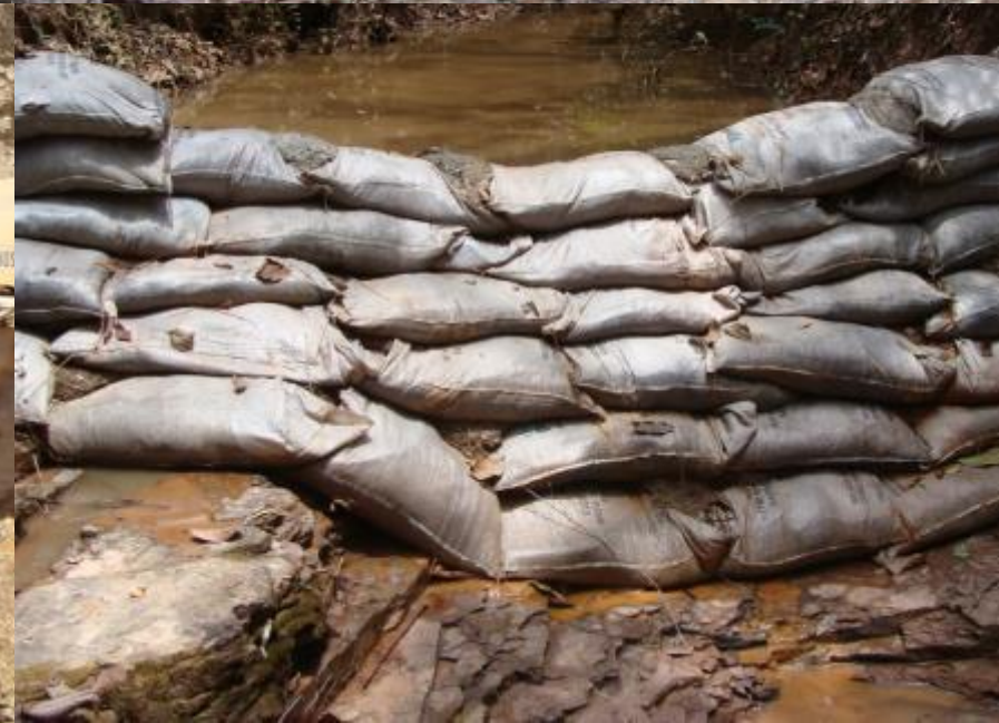
CONTENÇÃO DE SOLO CIMENTO
