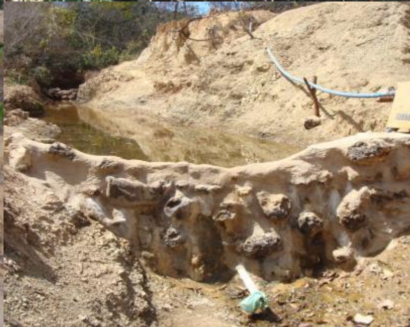
CONTENÇÃO DE PEDRA CIMENTO
