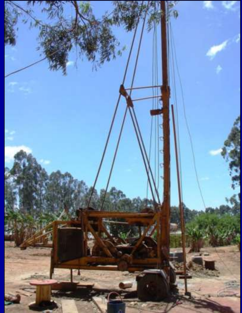
Perfuração de poço tubular profundo na Fazenda Grão Dourado (BA).
