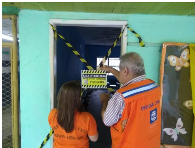
Figura 2 – Interdição preventiva de uma área da escola após vistoria técnica realizada por Engenheiros da SMDC-NI. Fonte: SMDC-NI
