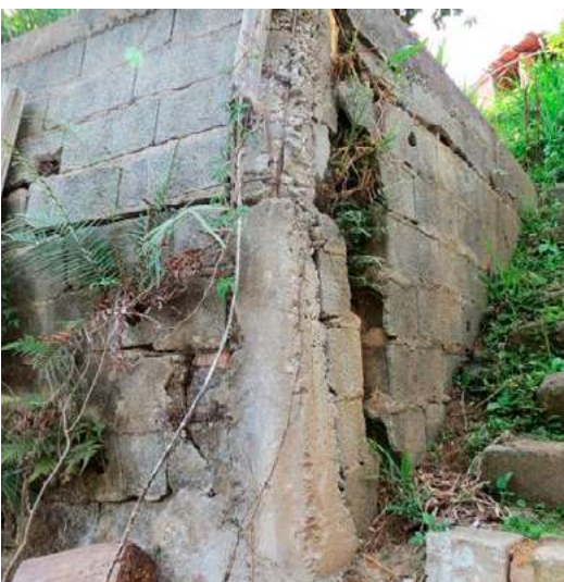
Figura 5. Muro embarrigado. Fonte: LabGRis, 2020.
