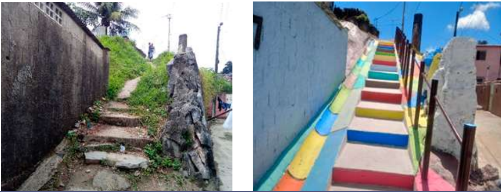
Figura 9. Obra de acesso do Programa Parceria no Bairro Ibura, Recife - famílias beneficiadas: 30; custo: R$ 1.953,49; conclusão: 16/01/2020. Fonte: Coordenadoria de Defesa Civil do Recife, 2020.
