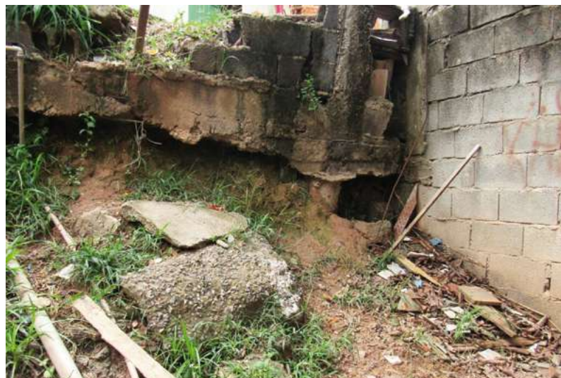
Figura 13. Erosão causada pela ausência de dispositivos de captação e direcionamento do escoamento das águas superficiais, o que acarretou no colapso parcial da estrutura e o seu comprometimento. Fonte: LabGRis, 2020.
