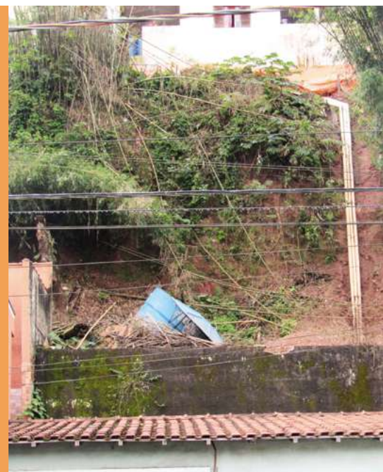
Figura 13. Erosão causada pela ausência de dispositivos de captação e direcionamento do escoamento das águas superficiais, o que acarretou no colapso parcial da estrutura e o seu comprometimento. Fonte: LabGRis, 2020.
