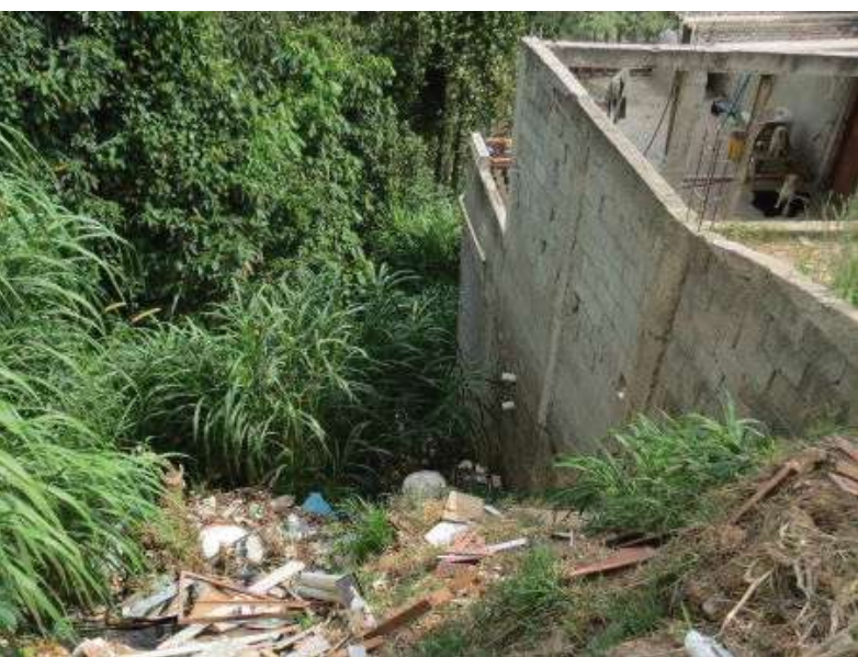
Figura 14. Lançamento de lixo e entulho em talude de alta declividade. Fonte: LabGRis, 2020.
