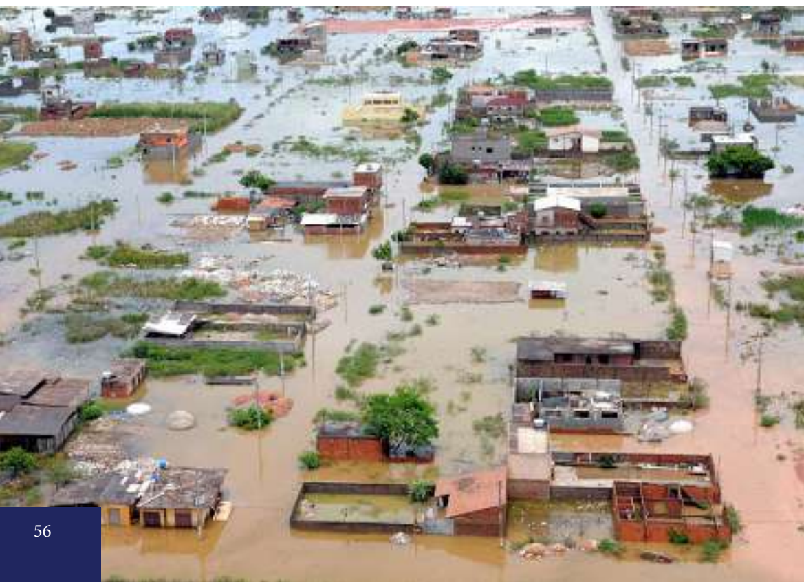
Figura 5. Inundação associada à passagem de ciclone extratropical pelo Sul do Brasil. Fonte: BANDNEWS FM, “Cerca de 4 mil moradores estão desalojados por causa das inundações no Rio Grande do Sul”, 7/10/2020.
