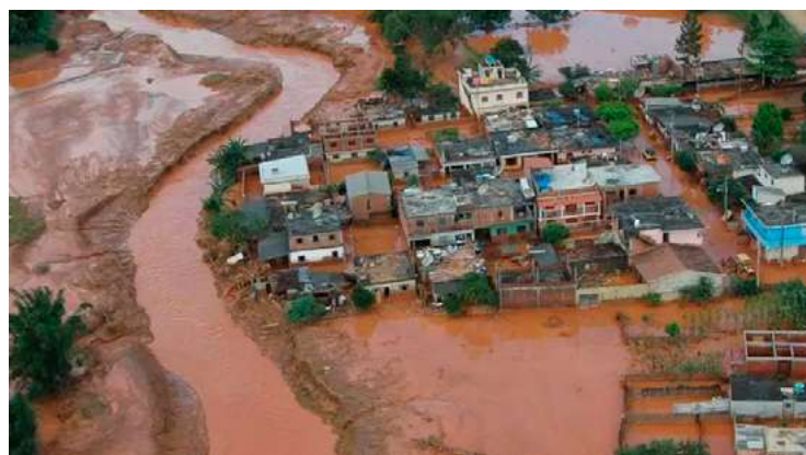
Figura 19. Rompimento da barragem de uma indústria em Cataguases, na Zona da Mata (MG), que espalhou 900 mil metros cúbicos de rejeitos industriais (2003). Fonte: O Tempo, 2019.
