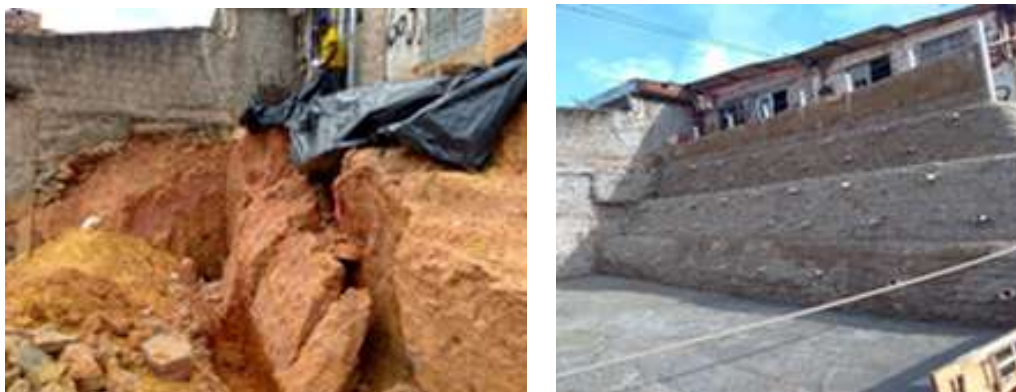
Figura 8. Contenção de encosta em RIP RAP do Programa Parceria no bairro Nova Descoberta, Recife - famílias beneficiadas: 2; custo: R$ 39.591,08; conclusão: 29/04/2020. Fonte: Coordenadoria de Defesa Civil de Recife, 2020.
