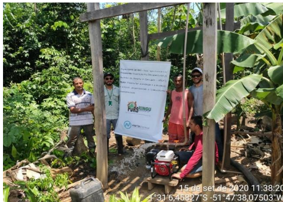
Figura 27: Vistoria e instalação do novo motor bomba para beneficiários do projeto 307/20127 “Água Limpa - Fonte de Vida”
