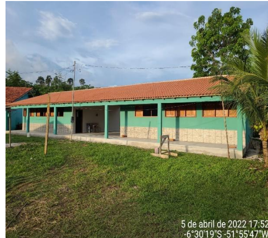
Figura 30: Registro fotográfico de um dos pavilhões da CFR de São Félix do Xingu, construído via Projeto PDRSX 317/2017 “Construindo para o Futuro”
