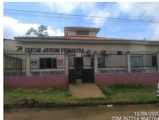
Figura 32: Registro fotográfico da creche construída via projeto PDRSX 096/2013 “Construção de uma (01) creche/EMEI em área de vulnerabilidade social em Altamira”
