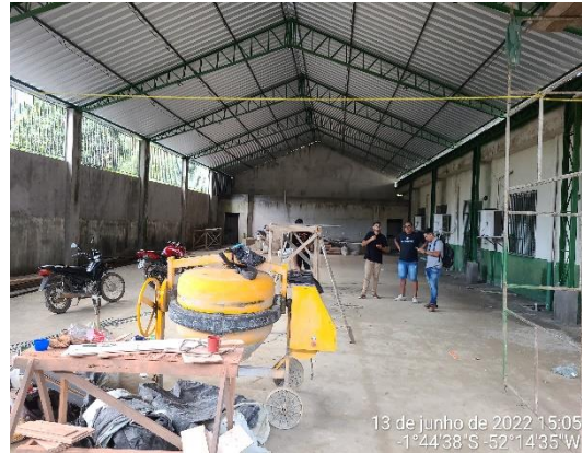
Figura 26: Registro fotográfico da visita técnica de monitoramento e medição da obra de ampliação da colônia de Pesca de PMZ via projeto PDRSX 305/2017 “Ampliação Colônia Z-64”.
