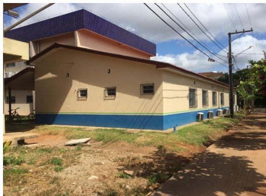
Figura 31: Registro fotográfico do prédio construído via projeto PDRSX 330/2017 “Centro de Informação e Formação do Xingu (CEFORM - XINGU)”
