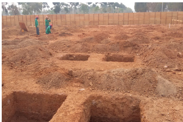
Foto 11. ZPE de Cáceres (MT) – Obras de implantação.
