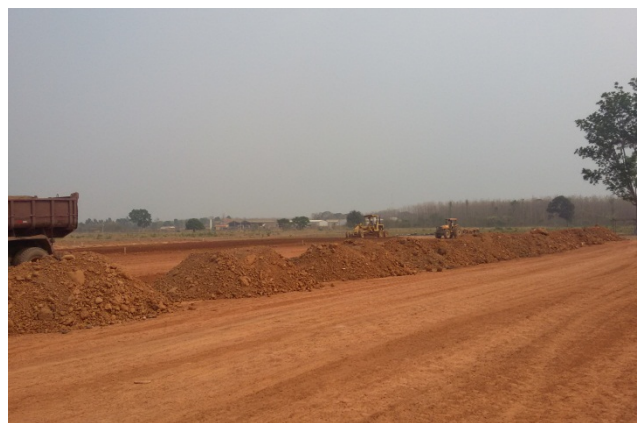
Foto 12. ZPE de Cáceres (MT) – Obras de implantação.
