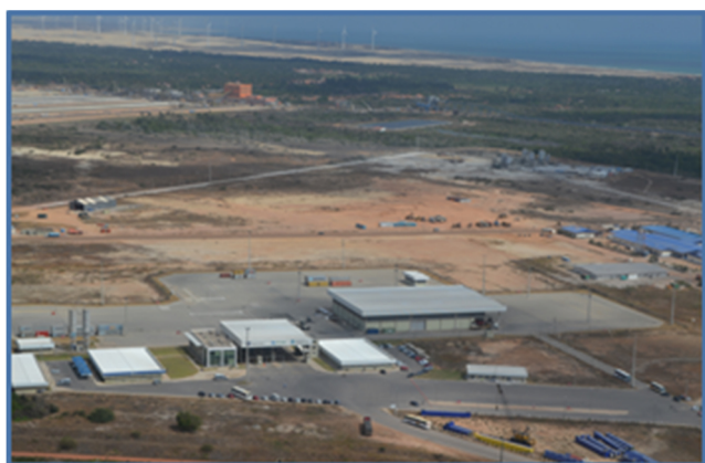
Foto 3. ZPE do Ceará (CE) – Visão Aérea da Área de Despacho Aduaneiro.
