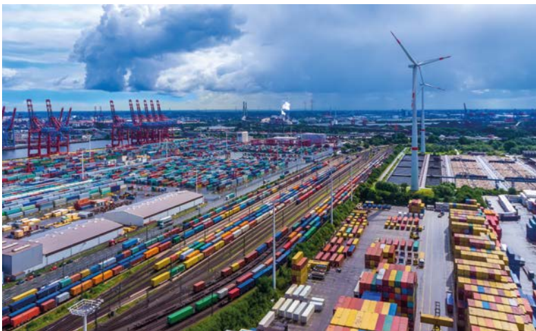
Porto e unidade de energia limpa
