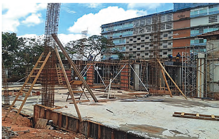
Memorial da Anistia em construção, 2014.
