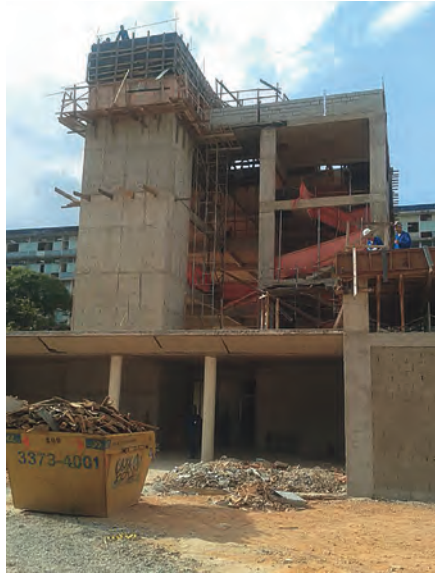
Memorial da Anistia em construção, 2014.
