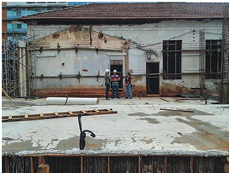
Memorial da Anistia em construção, 2014.
