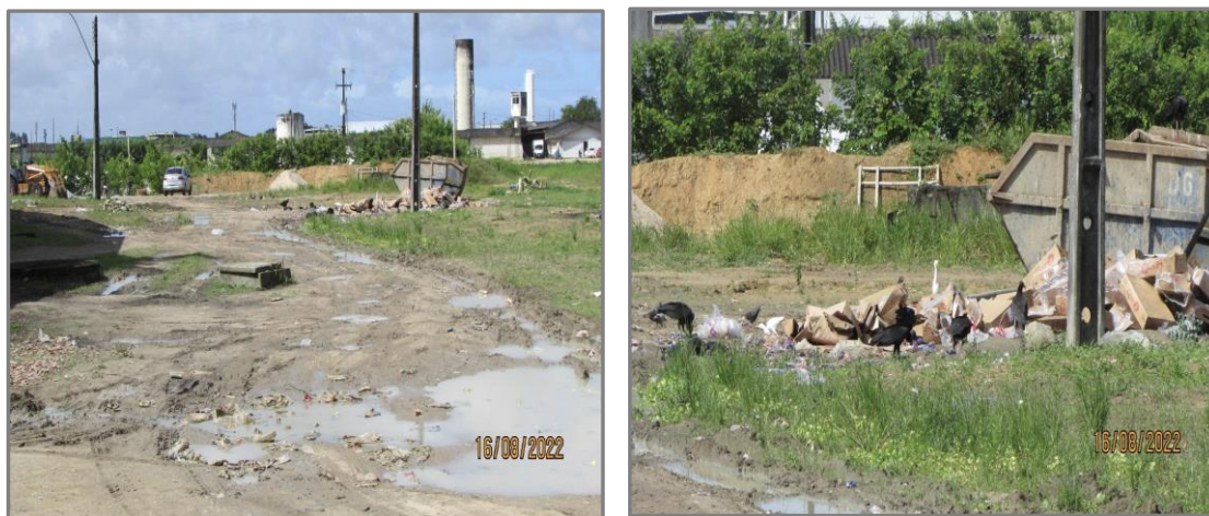
Fotos 04 e 05: Lixo a céu aberto ao lado da cozinha do Complexo. Fonte: MNPCT.
