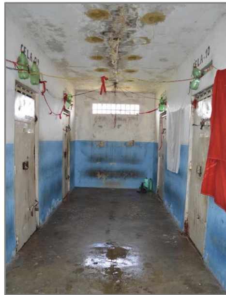
Fotos 1 e 2: Infiltrações, fios elétricos aparentes, cela e banheiro em péssimas condições. Fonte: MNPCT.
