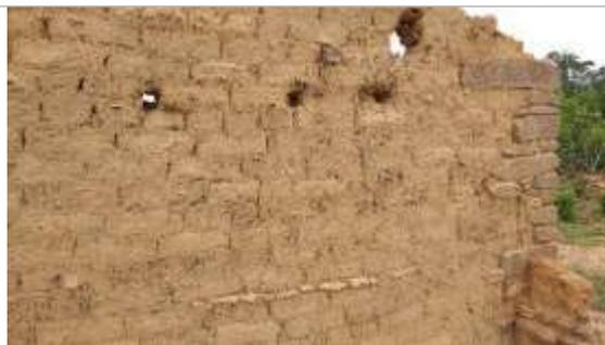
*Parede da casa, que tem aspecto de templo, com sinais de possíveis intervenções posteriores (os buracos e a argamassa no canto direito, embaixo). Notar a borda da lateral direita sem “amarras” para uma parede em ângulo de 90°, possivelmente local de janela e reforçada para suportar batentes e telhado (não há sinais vigamentos verticais na estrutura)*
