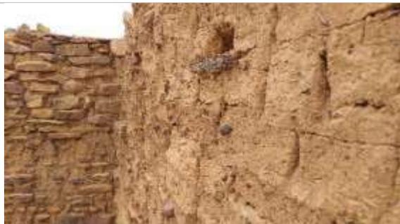
*Detalhes das paredes diferentes, a do fundo é a lateral da edificação e possivelmente mais reforçada para estruturar as outras.*
