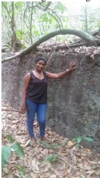
FIGURA 11- Muro da barragem do antigo engenho hidráulico
