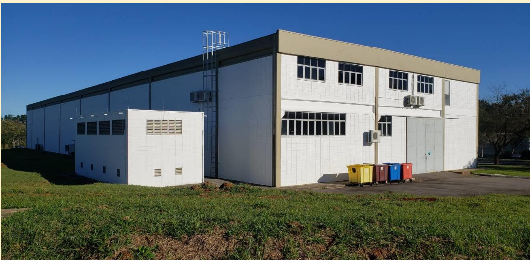
Vista Lateral do Prédio da Divisão de Aerodinâmica e Hipersônica
