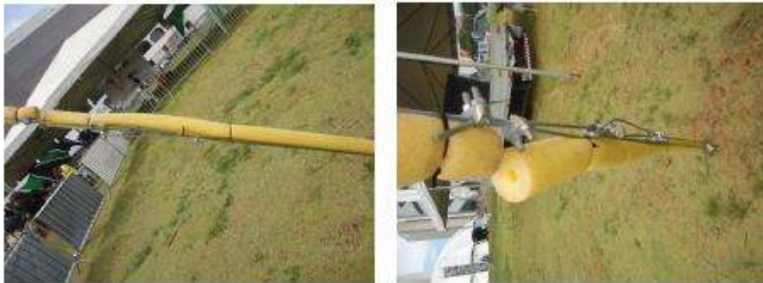
Figura 5 e 6 Cabo de aço com proteção com macarrão de piscina.
