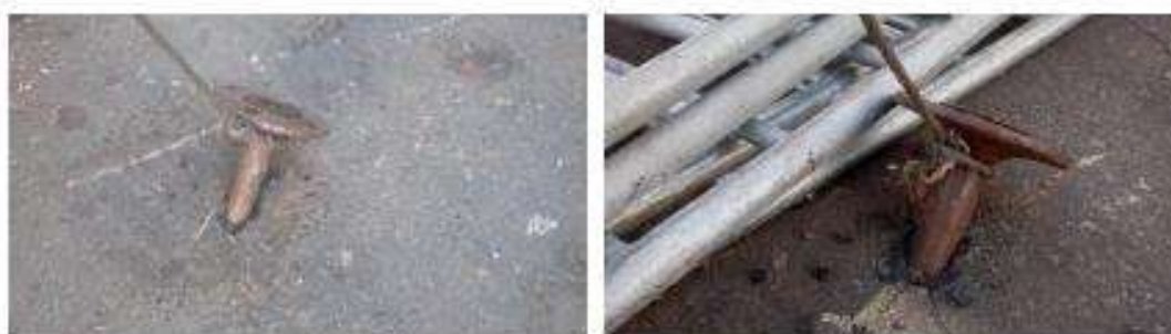
Figura 9 e 10 Cabo de aço amarrado.
