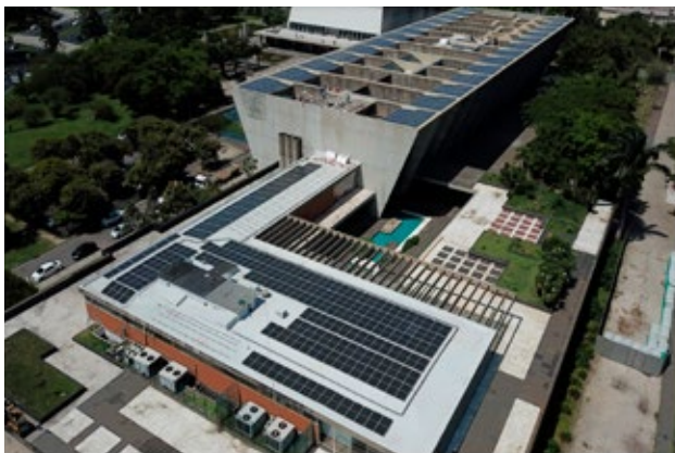
Fonte: Imagem de drone realizada pela empresa SolarCorp
