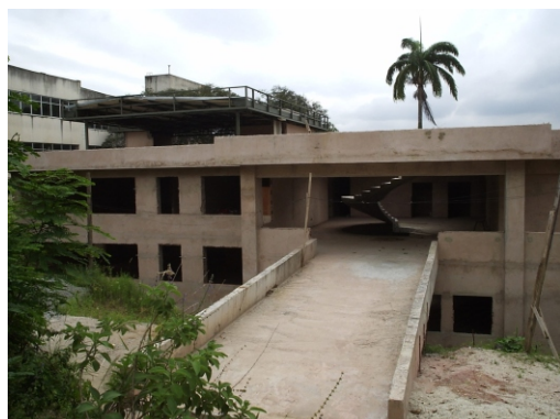
Obra do novo Prédio de Pesquisa e Preservação em História da Ciência. Out. 2006.
