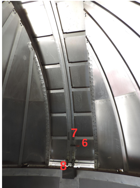
Figura 03 – Visão parcial da trapeira do OnT. O modo de travamento e destravamento desta é realizado pela peça 6 e as alças para realizar a movimentação manual estão indicadas por 7. O conjunto de polias lisas, na qual a trapeira se sustenta, está exemplificado por 8.
