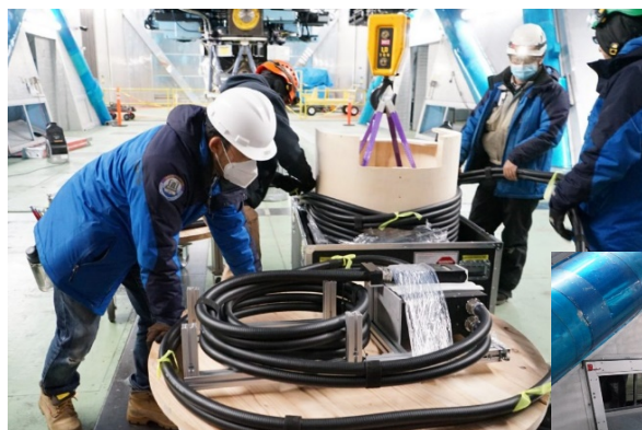
Figura 1 – (acima) Remoção da caixa de transporte e posicionamento em base giratória para desenrolar sem ocasionar torção das fibras
