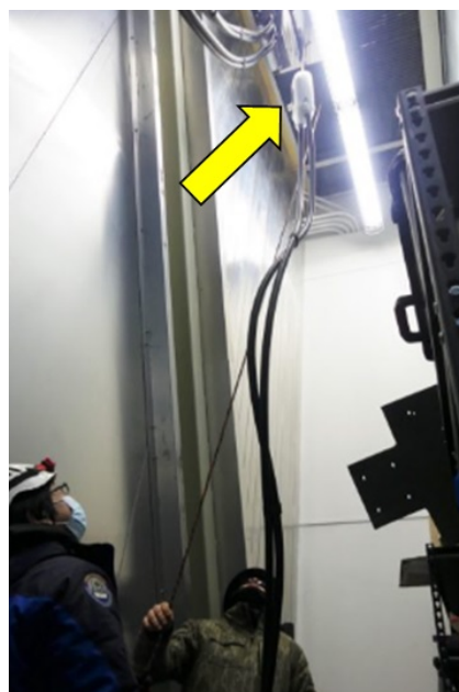
Figura 5 - (acima) Conectores terminais do cabo já instalados para conexão com o PFI, quando necessário.
