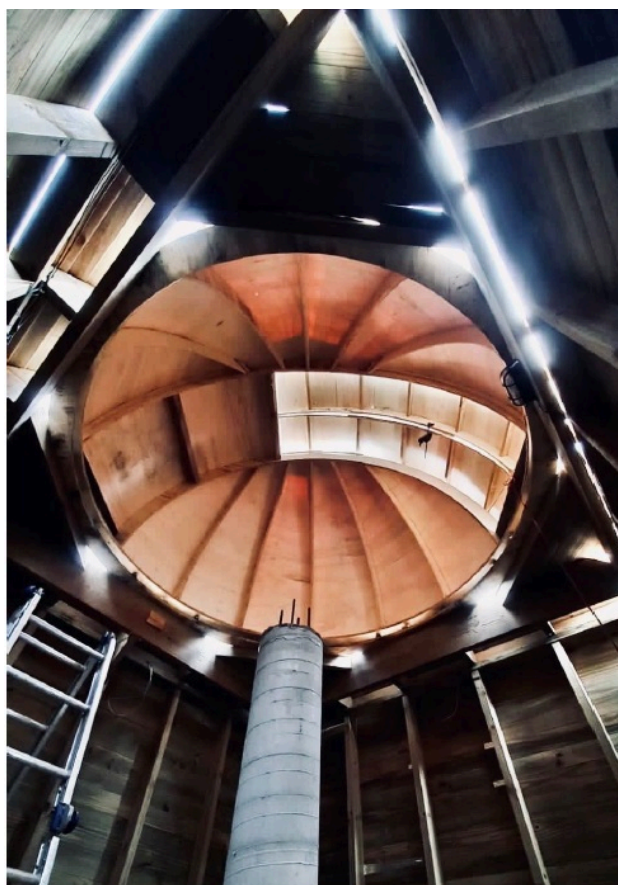
Figura 4: Visão de dentro da parte do observatório mostrando o pilar e a cúpula
