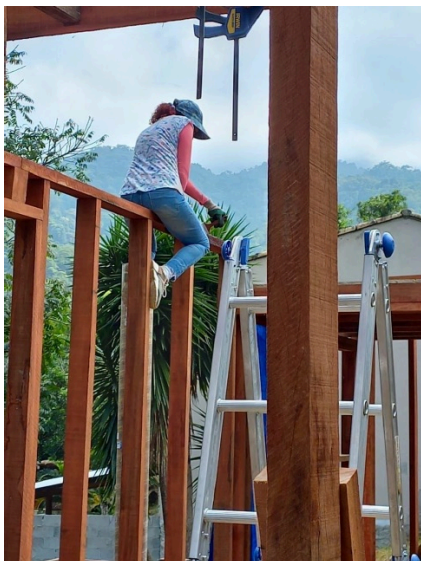
Figura 3: Lucia tratando a madeira com óleo queimado (final de março de 2022).
