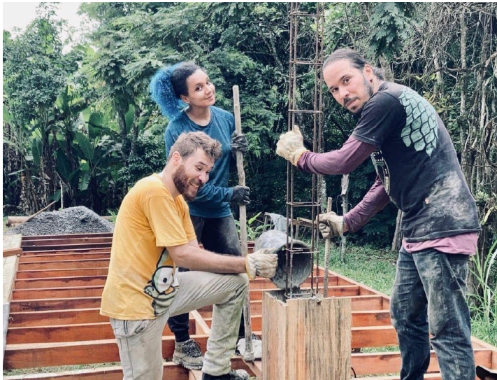
Figura 2: Concretagem da base do pilar em março de 2022. Da esquerda para a direita: George Siqueira, Aléxia Thamy e Ted Leandro.
