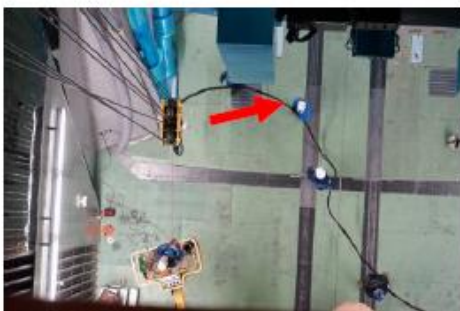
3ª. etapa: preparação para instalação final
