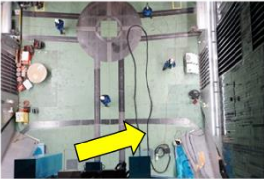
Vista aérea do topo do telescópio mostra o terceiro cabo sendo preparado para instalação
