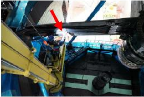
1ª. etapa: instalando cabo no topo do telescópio
