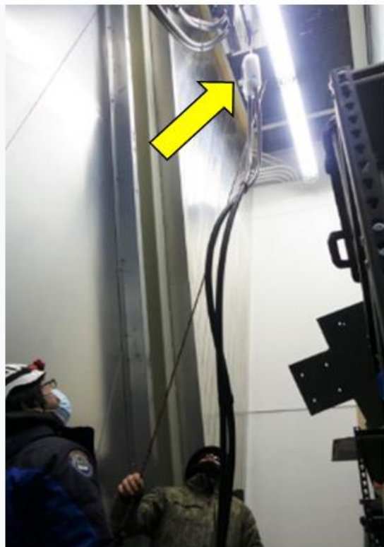
Outra extremidade do cabo sendo elevada para atravessar a parede e alcançar a Sala de Espectrógrafos
