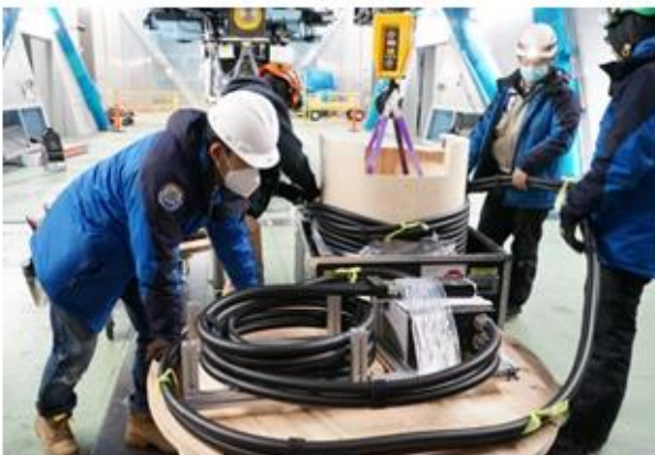
Remoção da caixa de transporte e posicionamento em base giratória para desenrolar sem ocasionar torção das fibras
