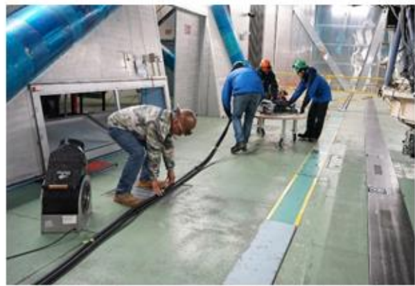
Preparação para realização de testes de desempenho óptico (no solo), antes da instalação na estrutura do telescópio Subaru
