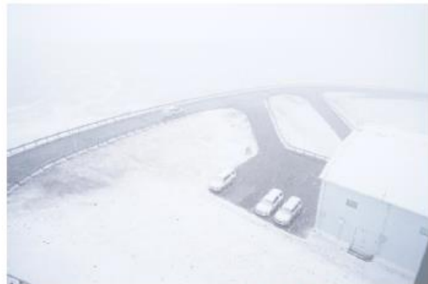
P.S. Nevou “um pouco” nos dias das atividades de instalação (final de maio).
