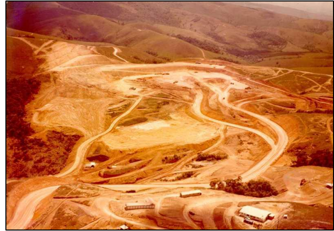
Implantação - Abertura da cava da mina.
