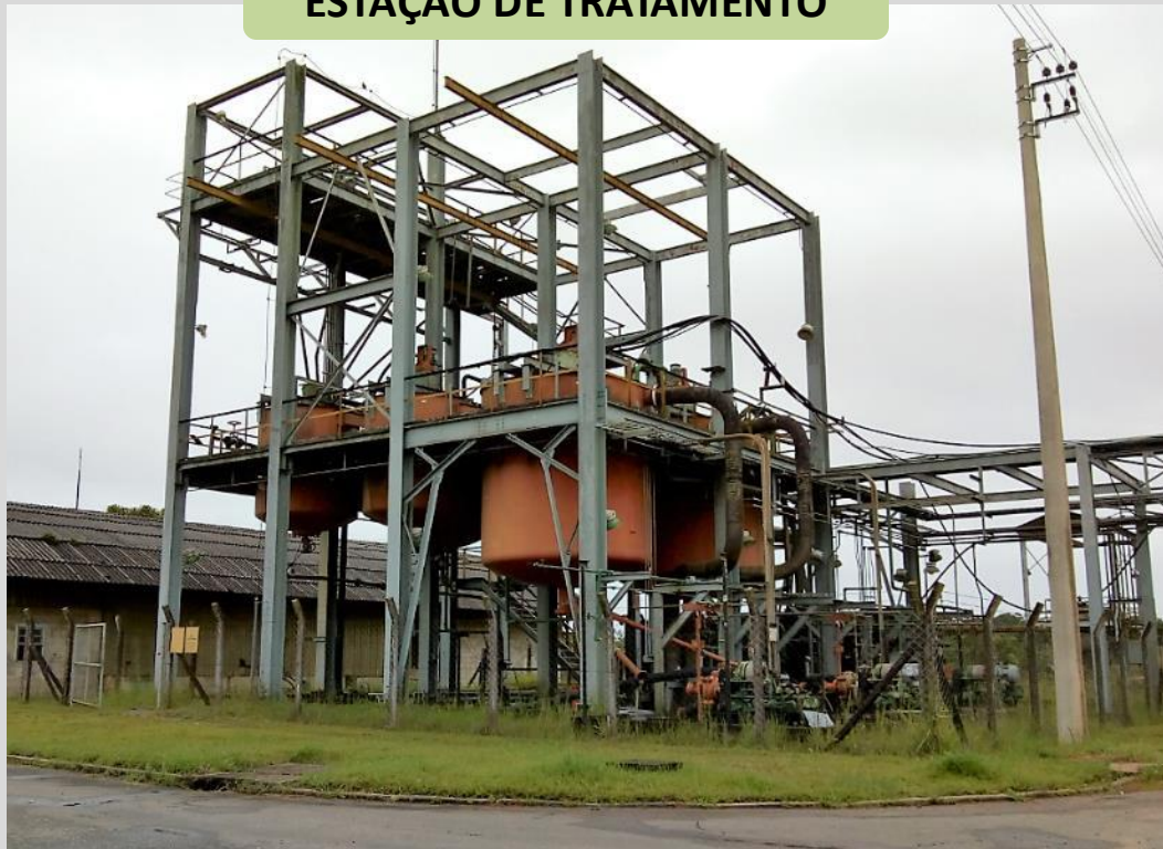
ESTAÇÃO DE TRATAMENTO
