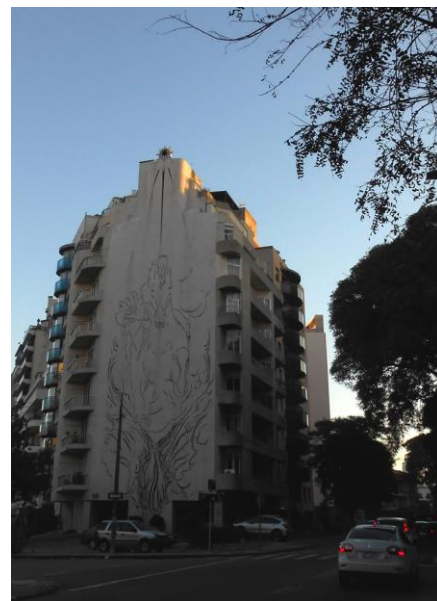
Imagem 2: Edifício El Indio, 2015. Foto: Roberto Heiden.
