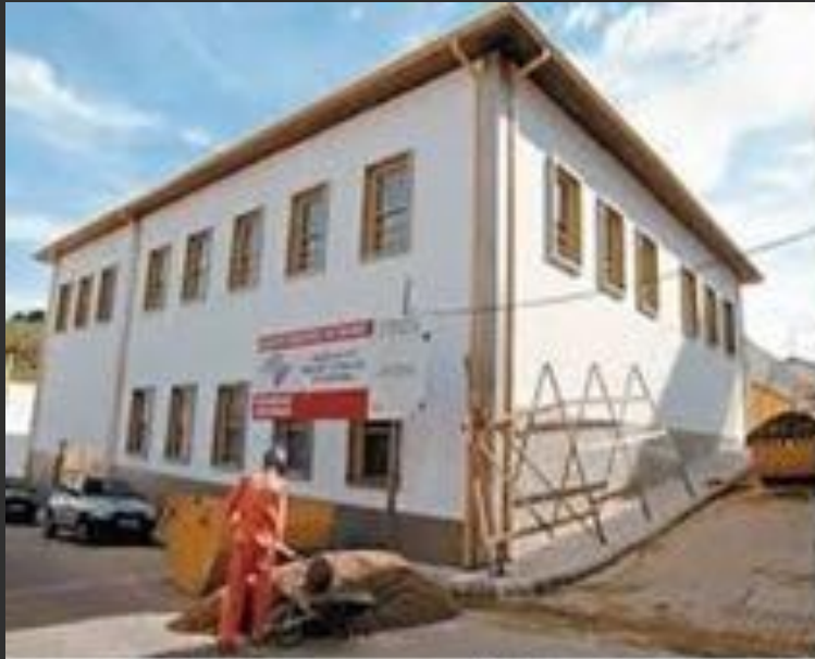
Foto de 2012: Reconstrução do Prédio
