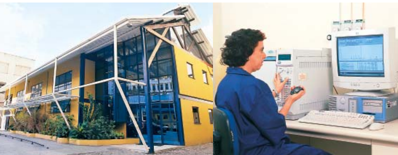
Fachada do prédio da Divisão de Energia - Laboratório de Gases Combustíveis
