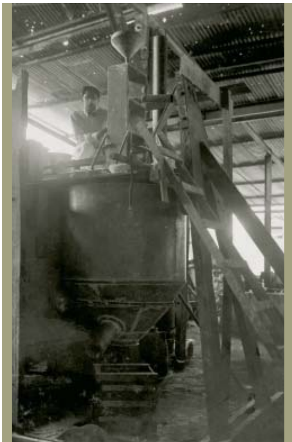
Sílvio Fróes de Abreu na retorta, equipamento destinado às experiências de destilação do maranito, em uma das primeiras atividades da EECM, entre 1922 e 1923.
