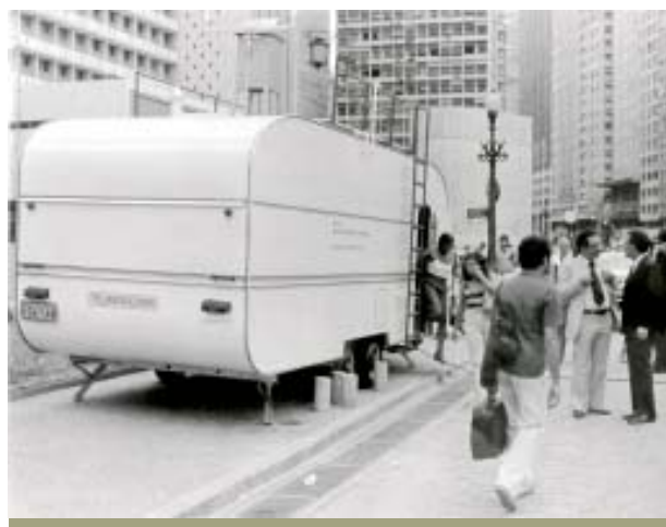
Unidade Móvel de Controle da Poluição do ar construída pelo INT/GESPI e instalada em 1979 no Largo da Carioca, Centro do Rio de Janeiro.
