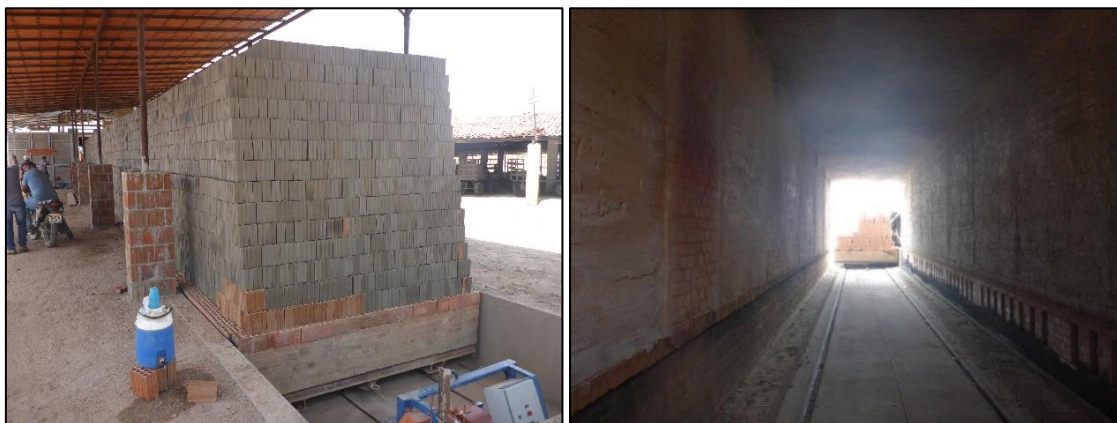
Figura 27 - Vagão de alimentação e interior do forno vagão metálico.
