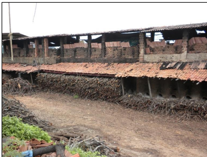
Figura 7 - Fornos tipo caipira, construídos contiguamente (uma parede lateral serve a dois fornos).
