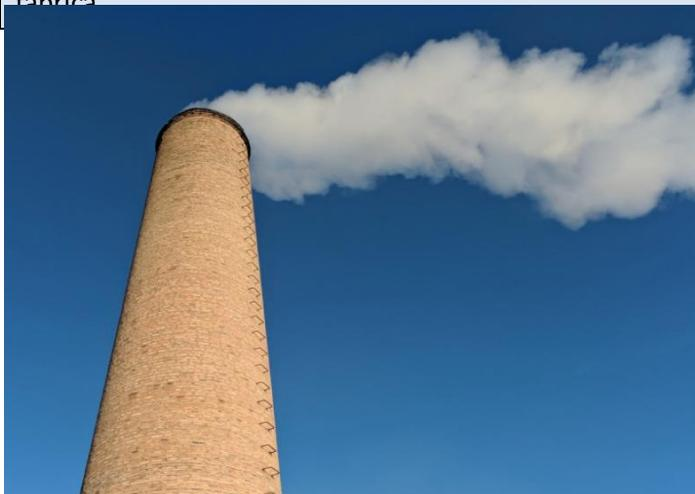
Notar que a “fumaça branca” em uma chaminé não indica necessariamente que se esteja emitindo material poluente. Essa emissão é basicamente vapor d’água proveniente da umidade da lenha e/ou dos próprios produtos cerâmicos não completamente secos.
