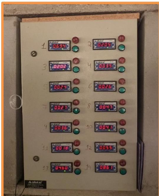
O controle da curva de temperatura se faz fundamental, não somente para garantir uma boa qualidade dos produtos, mas também para evitar desperdício de energia. Cada tipo de “traço” ou de mistura de argilas deve obedecer a uma determinada curva de queima.
